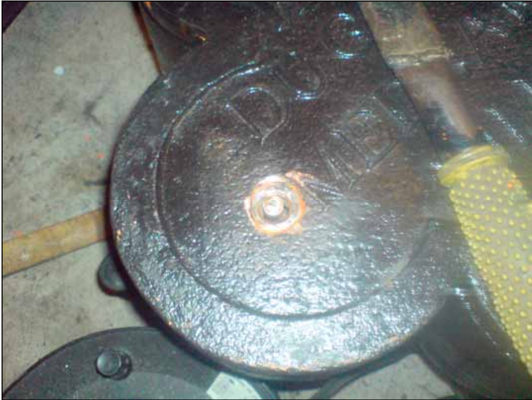
Montage av nya bultförband på den bakre korsdetaljen.
