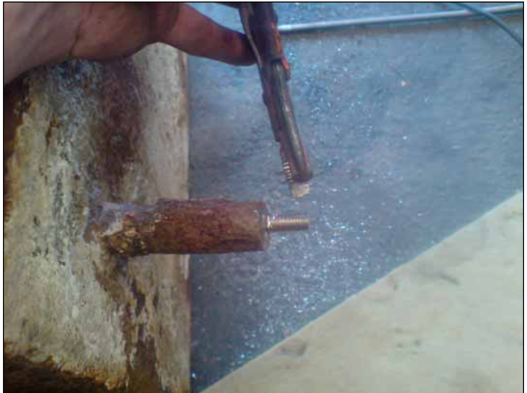
Gängstångsfästen för de nya förlängningsdubbarna i 24 mm rostfritt stål.
