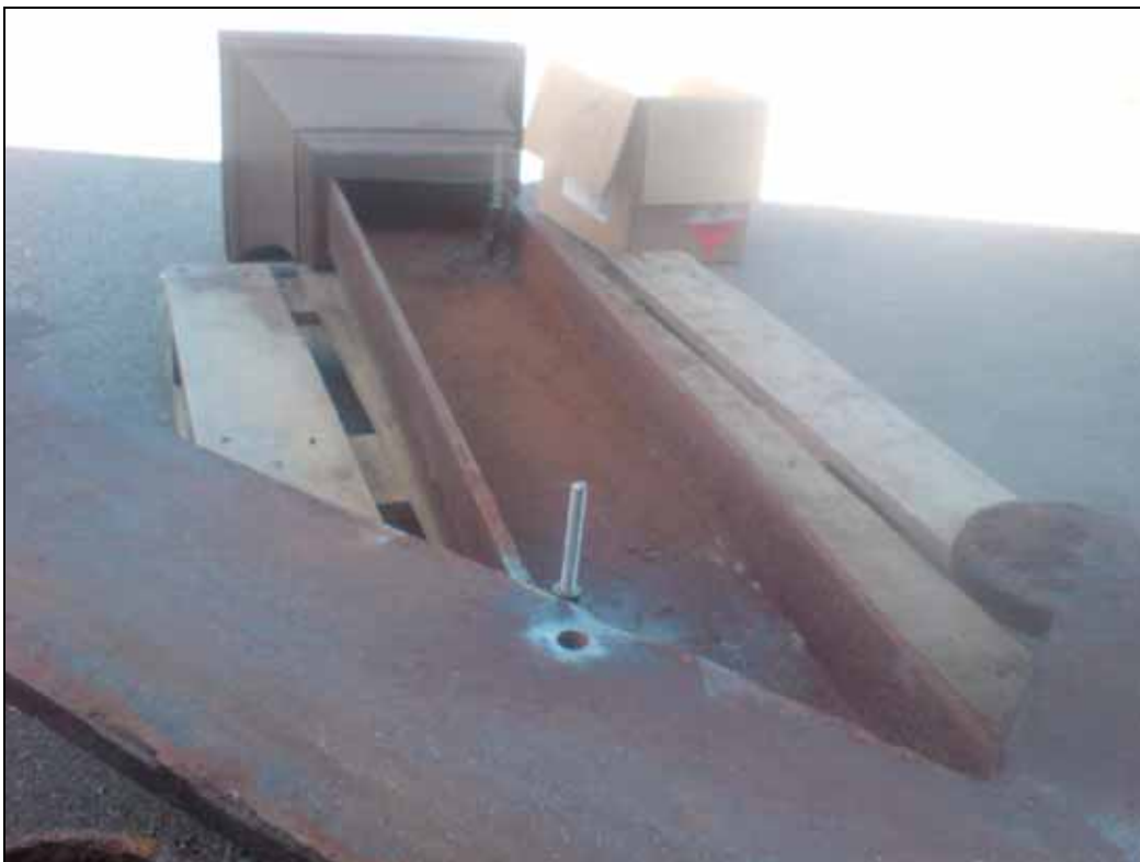
Nya bultförband av rostfritt stål för den bakre korsdetaljens montage mot den främre.
