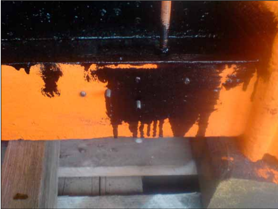
Förstärkningsplattjärnen monterades vått i vått för bästa korrosionsbeständighet.
