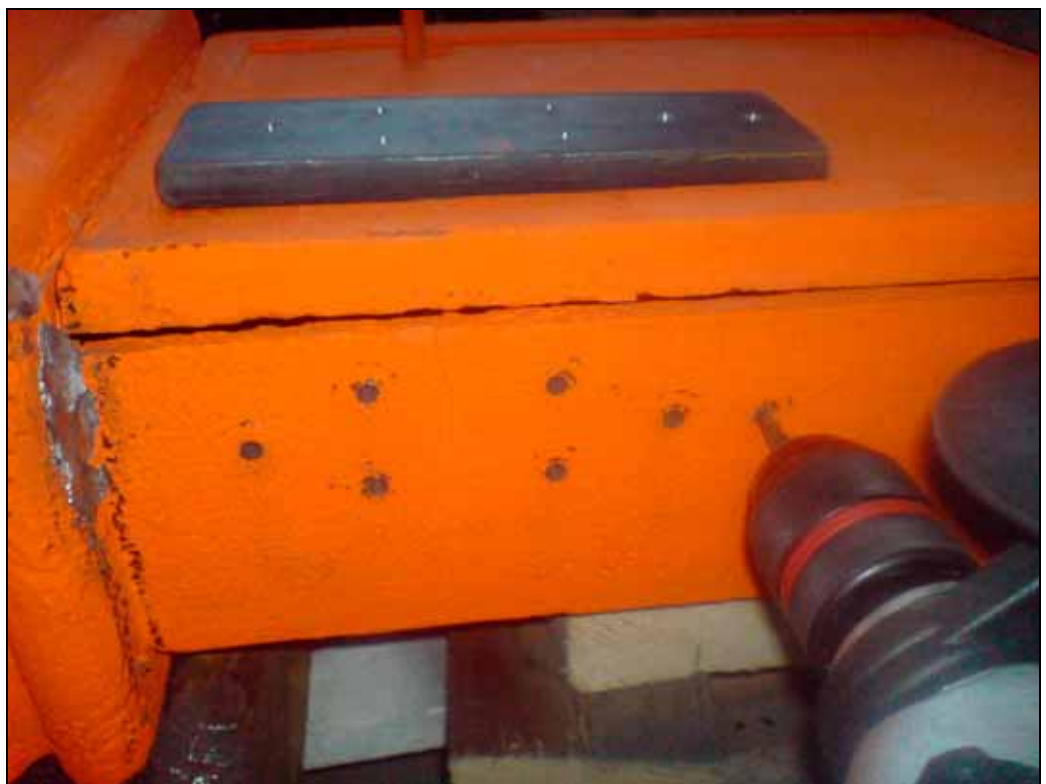
Förberedelser för montering av förstärkningsplattjärn vid sockelpartiet. Sprickan är knappt synlig i mitten av de fyra hålen.
