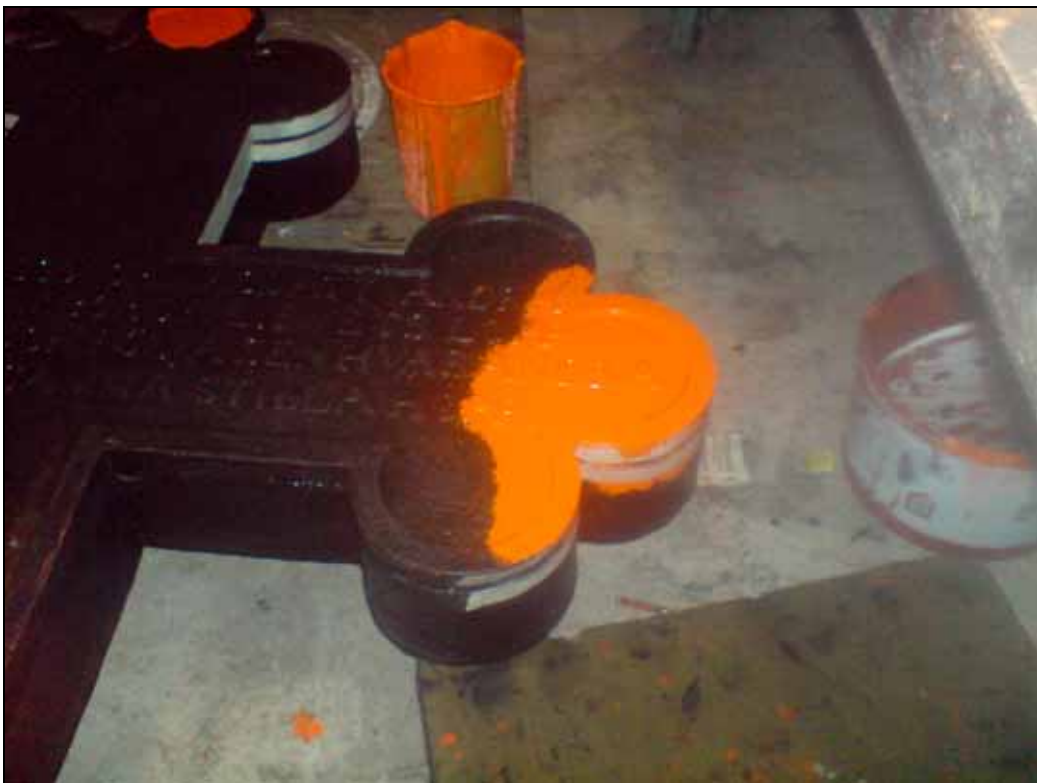
Kompletterande grundmålning på montageytor.
