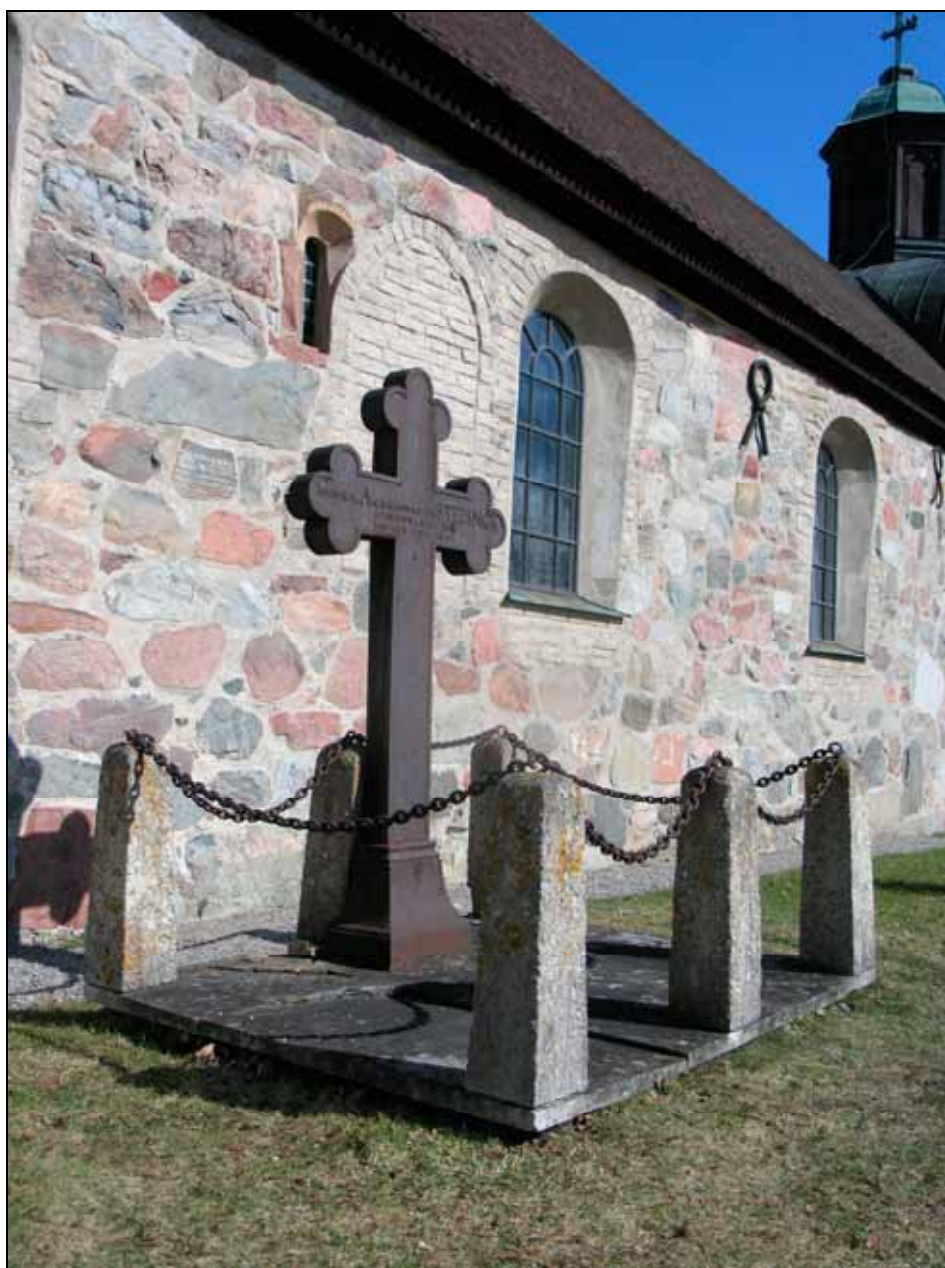
Von Stedingska gravens gjutjärnskorset var kraftigt rostigt.
