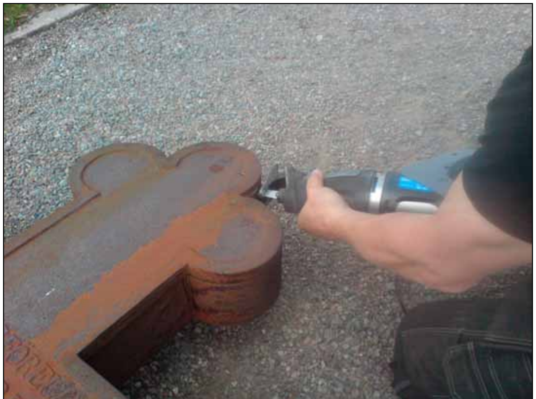
Demontering av korsets bakre parti.
