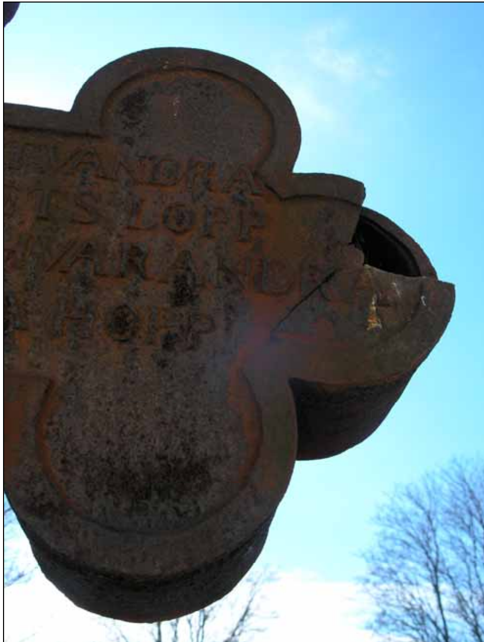
Gjutjärnskorset saknade en del som har rekonstruerats.
