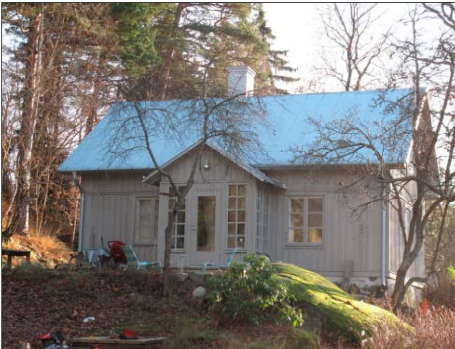
Byggnad i Söder Grävlingberg med varsamhetsbetckningen k. Huset är ursprungligen byggt som ett torp på 1850-talet. Byggnaden totalrenoverades innan detaljplanen antogs; det äldre tegeltaket har bytts ut till plåttak, vindsvåningen har isolerats, och den tidigare förstuvisten har byggts in. Den tidigare ljusgula träpanelen har blivit grå. Ägaren ville "bevara byggnadens karaktär". Trots att byggnadskroppen i stora drag är bevarad, utstrålar den en tydlig modernitet med de gråmålade fasaderna och snickerierna, liksom det blänkande plåttaket och entréns varierade fönstersättning. Lp20090514.
