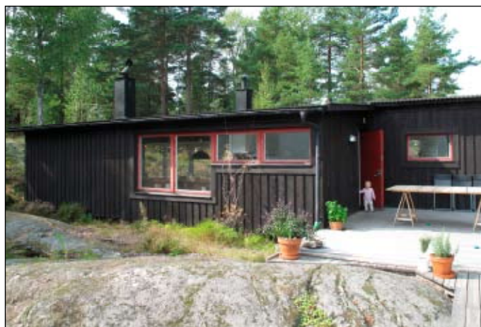
Villan är renoverad med ny panel, nytt takmaterial samt ny dörr, men smälter fortfarande väl in i området karaktär. Lp20090517.
