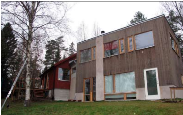
Här har fastighetsägarna- trots att de inte har någon k- bonus byggnad, valt att bevara det äldre huset. "Det var mycket dyrare att bygga till än att bygga allt nytt, men det hade varit vårt hem i 10 år, så vi ville bevara det" Det gamla huset försågs med en modern arkitektritad tillbyggnad 2009. Lp20100011.
