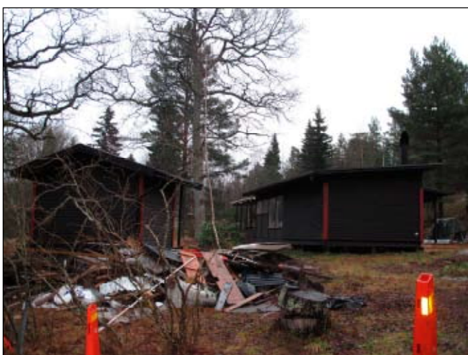
Ett hus i Norra Kopparmora som genomgått en förhållandevis varsam upprustning. Lp2010061.
