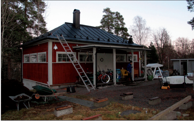
I stället för en mindre tillbyggnad kommer nu ett större separat bostadshus att uppföras bredvid det gamla huset. Lp20090513.
