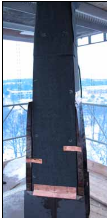
Slättäckning på spiran efter renovering. Under kopparplåten har lagts ett lager av byggpapp. T.v. Bildnr: lp20100151 och t.h. lp20100152.
