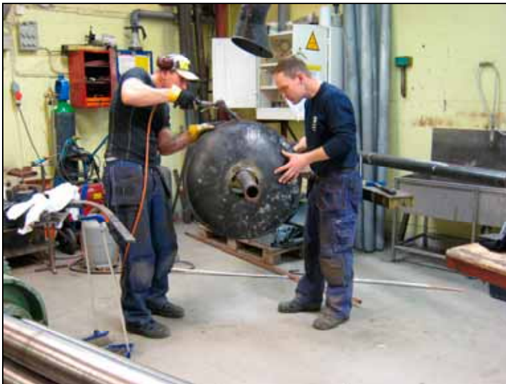
Nod från tornspiran renoveras på verkstan av Micke och Micke. Mått: ca 80 cm i diameter. Foto: Mona Lantzourakis, 2010
