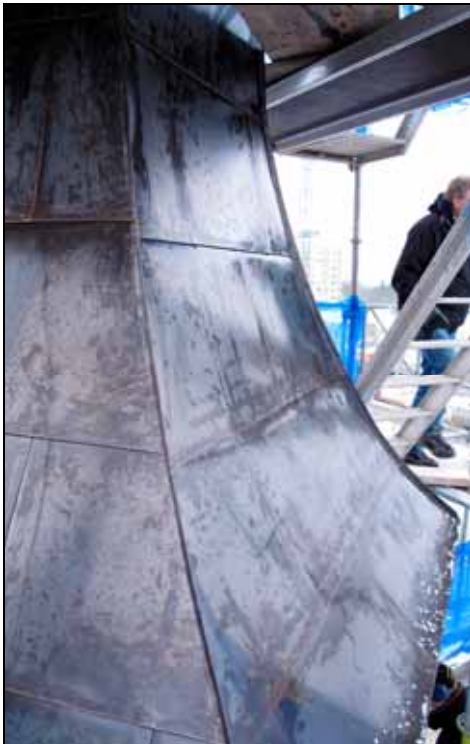
Slättäckning på spiran efter renovering. Under kopparplåten har lagts ett lager av byggpapp. T.v. Bildnr: lp20100151 och t.h. lp20100152.
