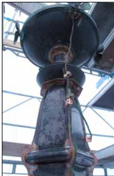
Del av spiran efter renovering. Nya fästen för åskledarlinor. Bildnr: lp20100160
