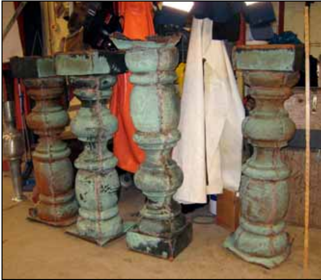
T.v. Balusterdockor från 1891 består av massiv träkärna beklädd med kopparplåt i fyra delar, skarvad och lödd på träkärnan. Foto Mona Lantzourakis, 2010
