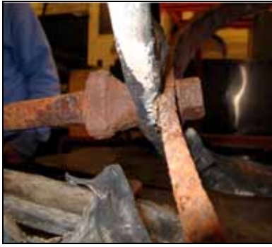
Korsets infästning före renovering. Bildnr: lp20100484
