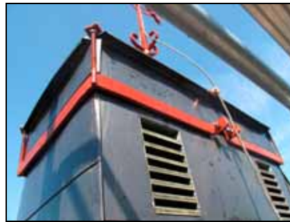
Infästning med nya bultar Bildnr: lp20100487
