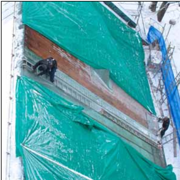
Rivning av kopparplåt och perforerad masonit på långhusets sydsida. Bildnr: lp20100162
