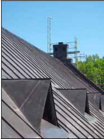
Omlagda takkupor med bibehållen originalfront. Trappad ståndskiva vid anslutning mot tornmur. Bildnr: lp20100167 och lp20100165
