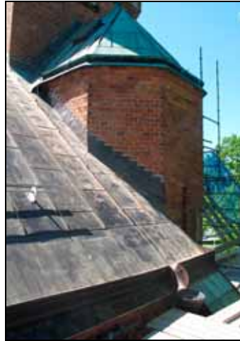
Omlagda takkupor med bibehållen originalfront. Trappad ståndskiva vid anslutning mot tornmur. Bildnr: lp20100167 och lp20100165
