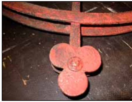
Korsets infästning före renovering. Bildnr: lp20100484
