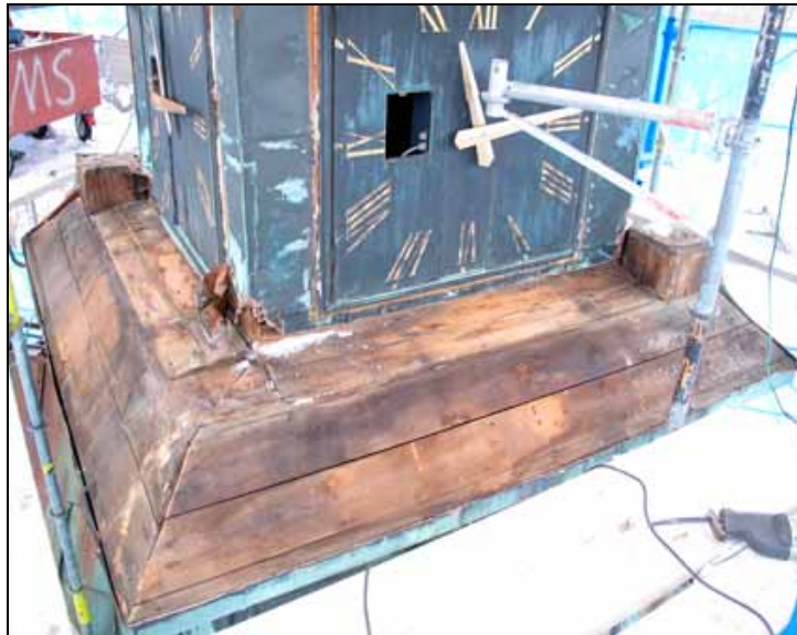
Trästimme under kopparplåten visade sig vara i gott skick. Bildnr: lp20100155
