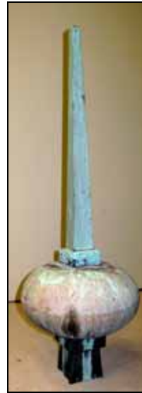
T.v. Balusterdockor från 1891 består av massiv träkärna beklädd med kopparplåt i fyra delar, skarvad och lödd på träkärnan. Foto Mona Lantzourakis, 2010
