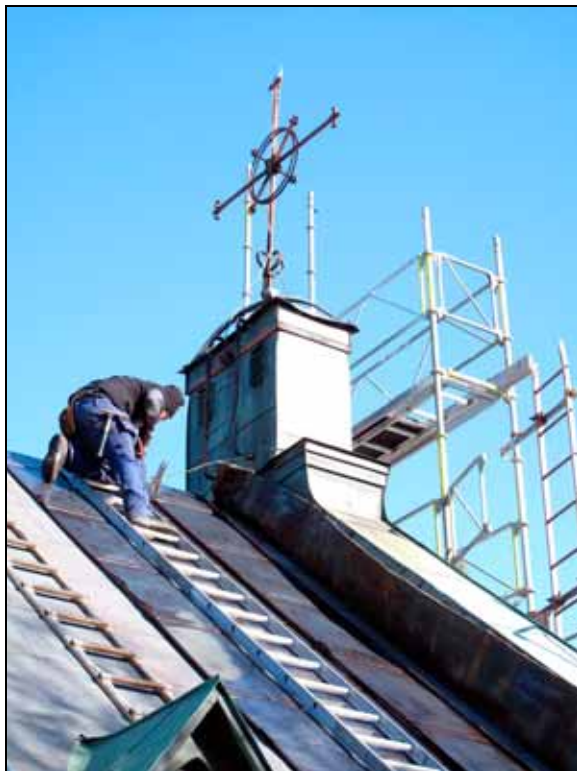
Dubbelfalsad skivtäckning med kopparplåt på nylagd byggpapp. Bildnr: lp20100473
