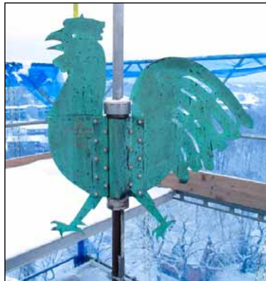
Tuppen efter renovering. Rostfria fästen, ifylld inskription: "H J HALLBERG 1949". Bildnr: lp20100157
