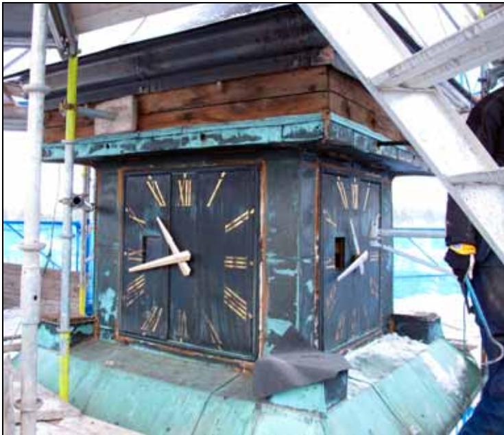
Tornur med fyra urtavlor före renovering. Fyra kopparbeklädda balustrar är demonterade för ombeslagning. Bildnr: lp20100149
