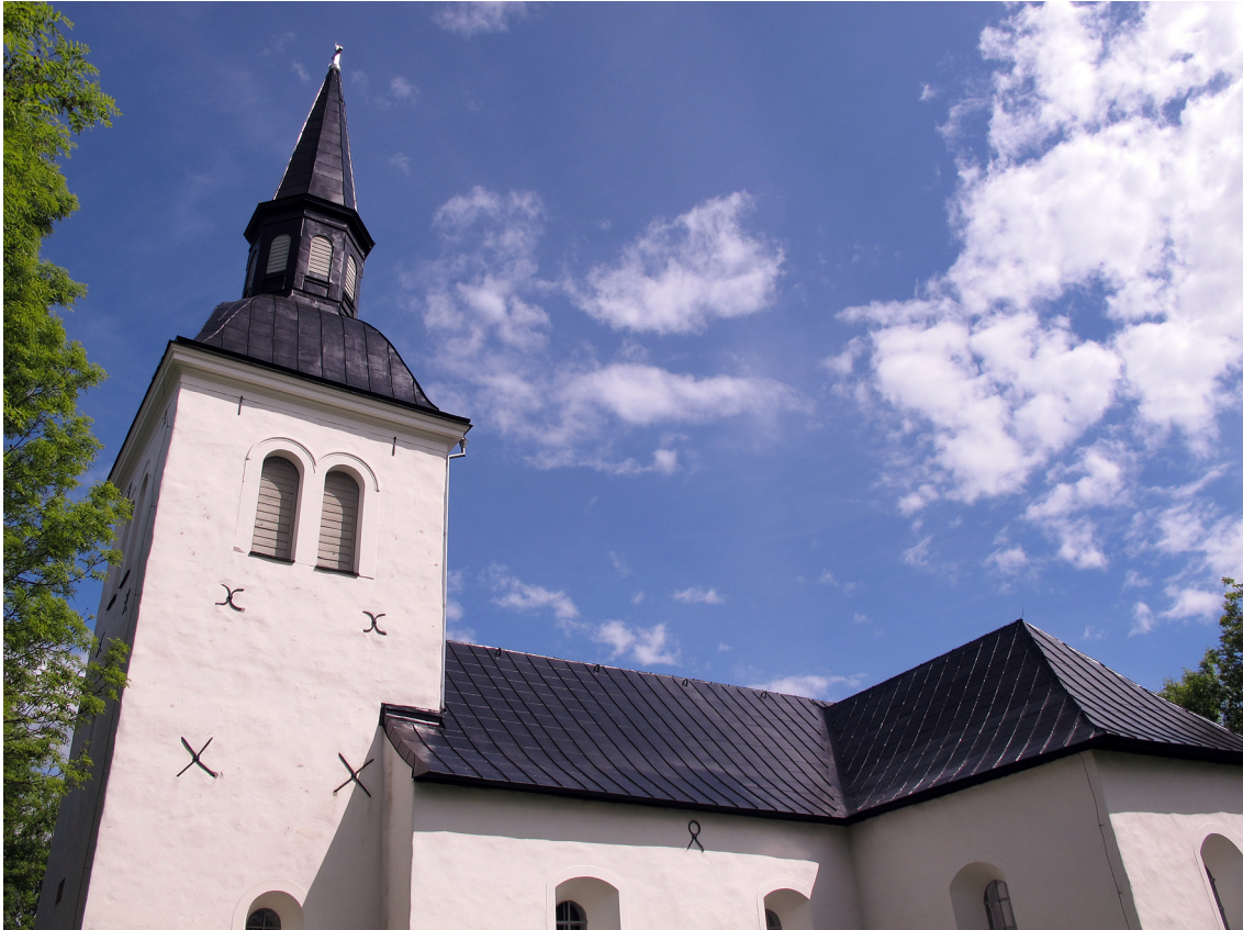
Fig 6. Färdigmålade tak på torn, långhus och kor, sedda från söder. Foto Martina Berglund, bildnr LP201200173.
