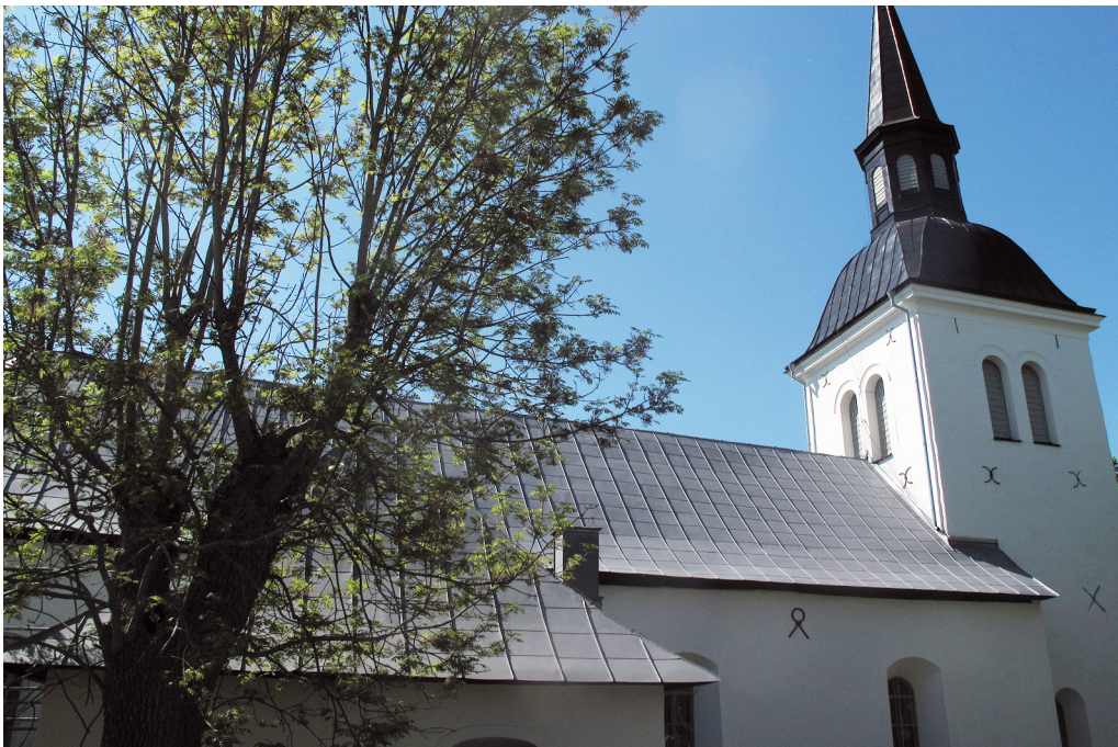
Fig 3. Tak på långhus ännu omålat, torntak färdigmålat. Foto Hedvig Bellberg, bildnr LP201200170.
