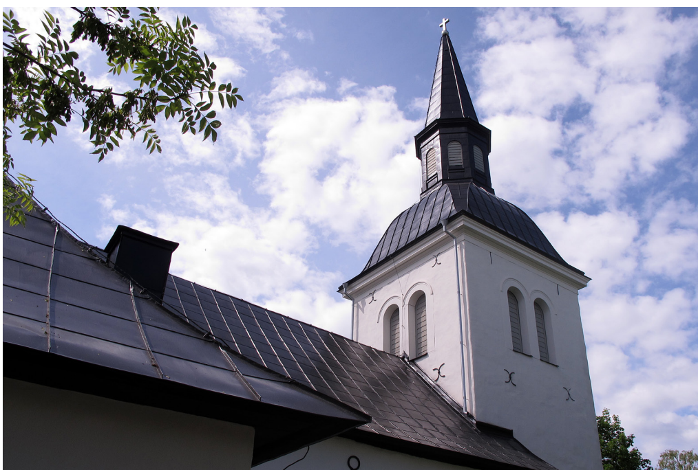
Fig 5. Färdigmålade tak på sakristia, långhus och torn, sedda från norr. Foto Martina Berglund, bildnr LP201200172.
