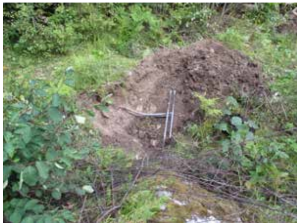
Fig 10. Schaktning vid stag 3. Foto: Tina Mathiesen (LP_2012_00224).
