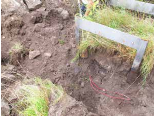
Fig 4. Schaktning vid fundament 2. Från sydöst. Foto: Tina Mathiesen (LP_2012_00220).
