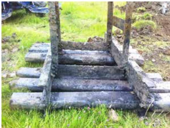
Fig 9. Fundament med tillhörande stockmatta. Foto: Vattenfall Services Nordic AB.
