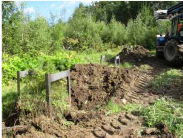
Fig 8. Schaktning vid stolpplats 2. Från väster. Foto: Tina Mathiesen (LP_2012_00223).
