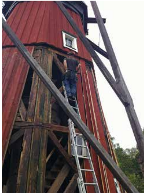
Figur 7. Den nya panelen utförd upptill på kvarnhuset. Den nedre delen av panelen under utförande av Roland Henkel. Foto: Göran Gripberger.
