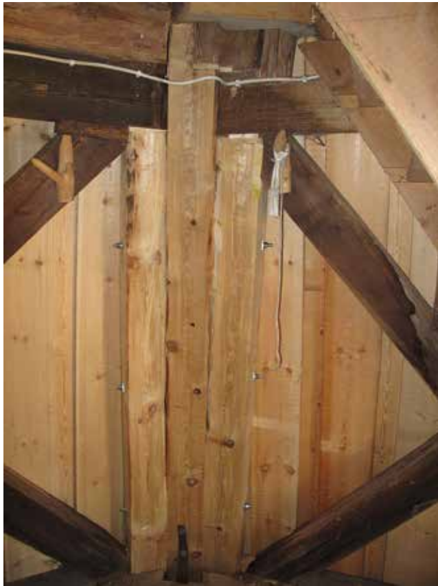
Figur 3. Nya timmerstockspartier tillfördes den bärande konstruktionen i nedervåningen. Foto: Hedvig Bellberg, LP_2012_00607
