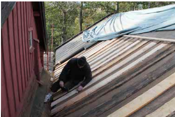
Figur 4. Kvarnbyggnadens tak under omläggning. Bild från entreprenör.
