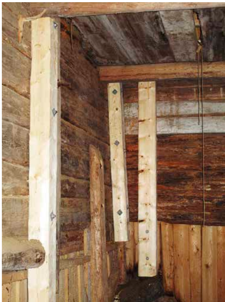
Figur 20. Överbyggnaden efter åtgärd. Lp 201200848.
