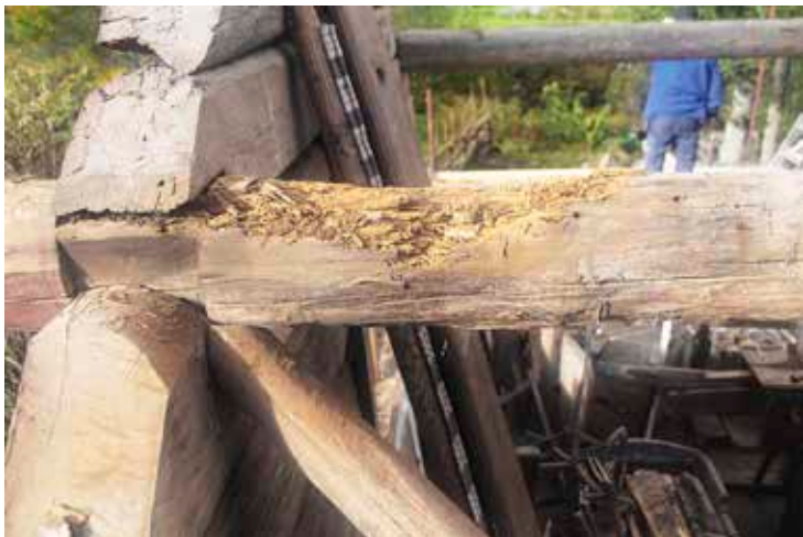
Fig 10. Kvarnkamarens tak under omläggning. Bild från entreprenör.
