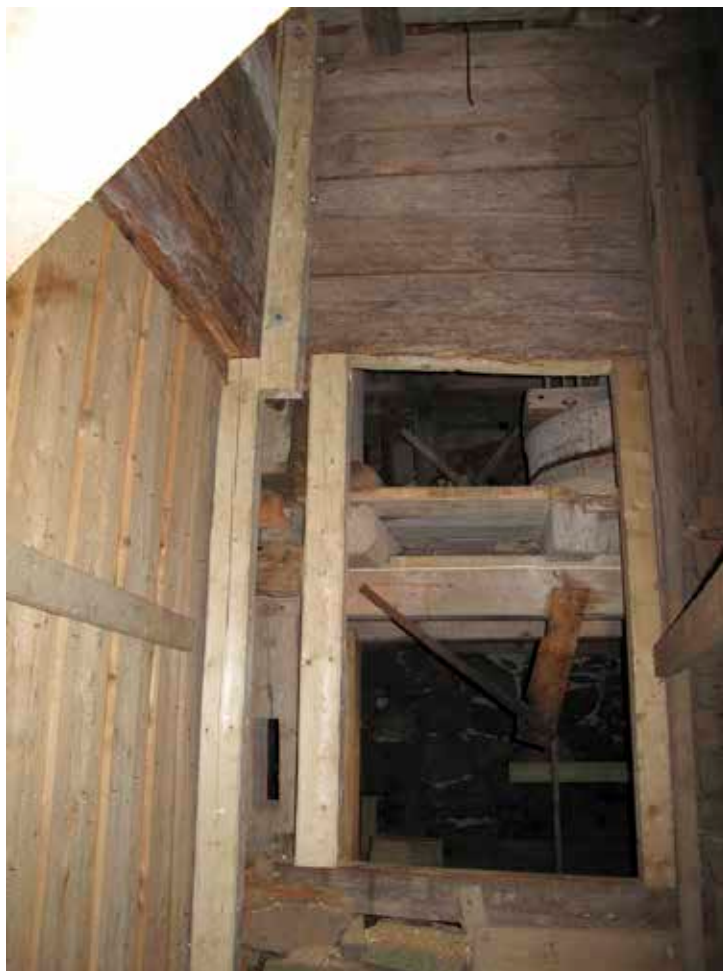
Figur 24. Överbyggnaden efter åtgärd. Lp 201200853.
