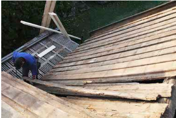
Fig 8. Kvarnkamarens tak under omläggning. Bild från entreprenör.
