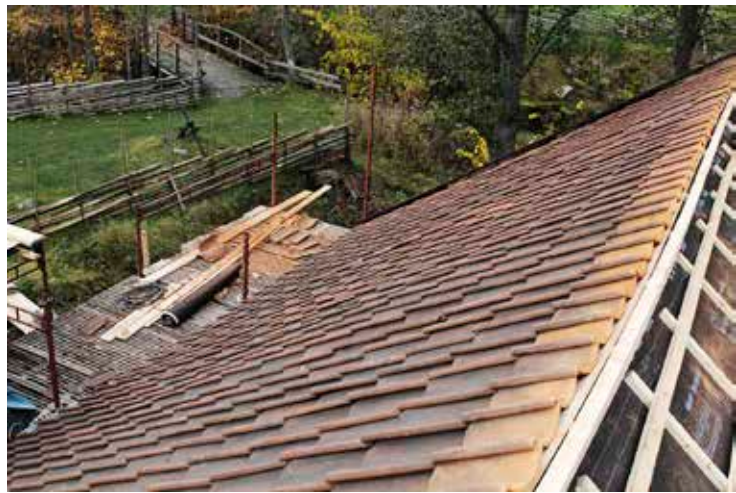
Figur 6. Kvarnbyggnadens tak under omläggning. Bild från entreprenör.
