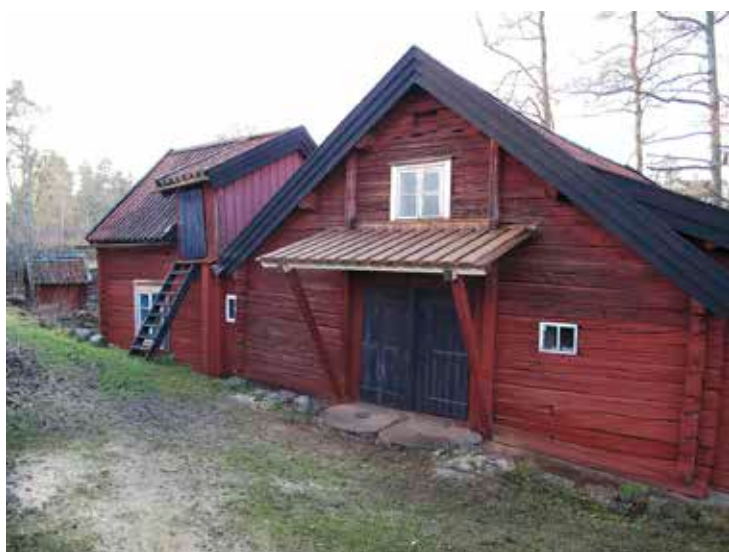
Figur 15. Skärmtaket efter åtgärd. Lp 201200813.
