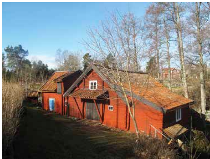
Figur 14. Skärmtaket innan åtgärd. Lp 201200793.
