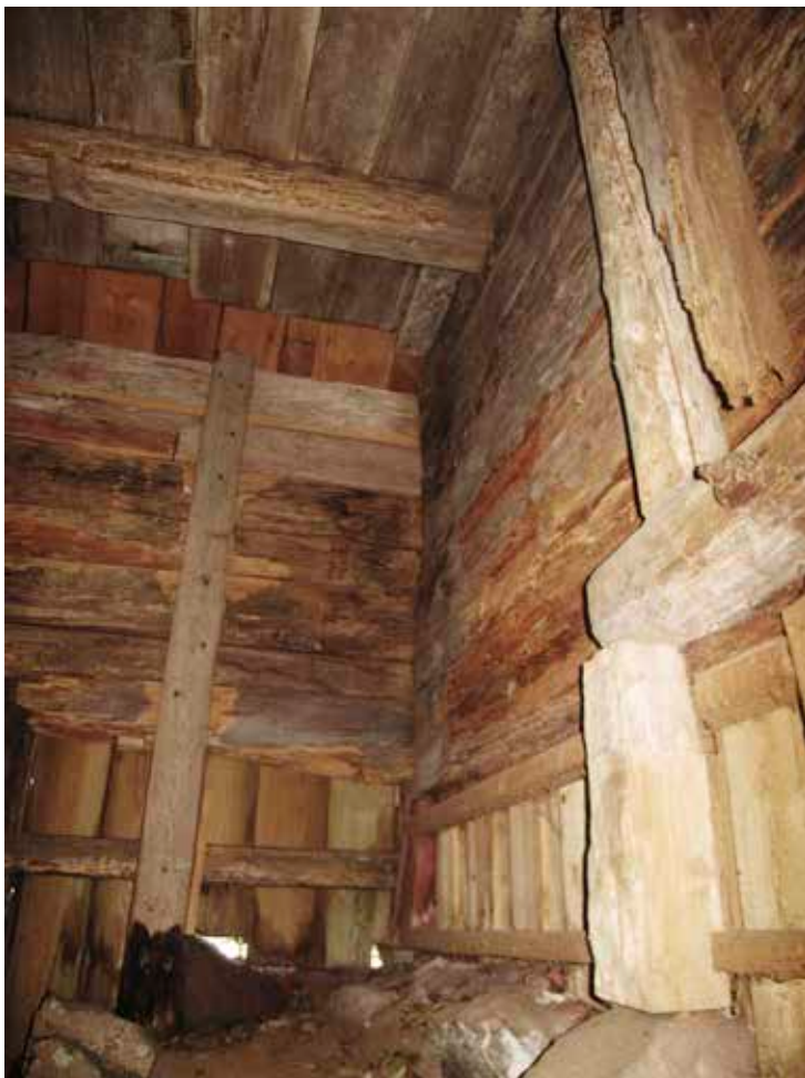
Figur 19. Överbyggnaden innan åtgärd. Lp 201200796.
