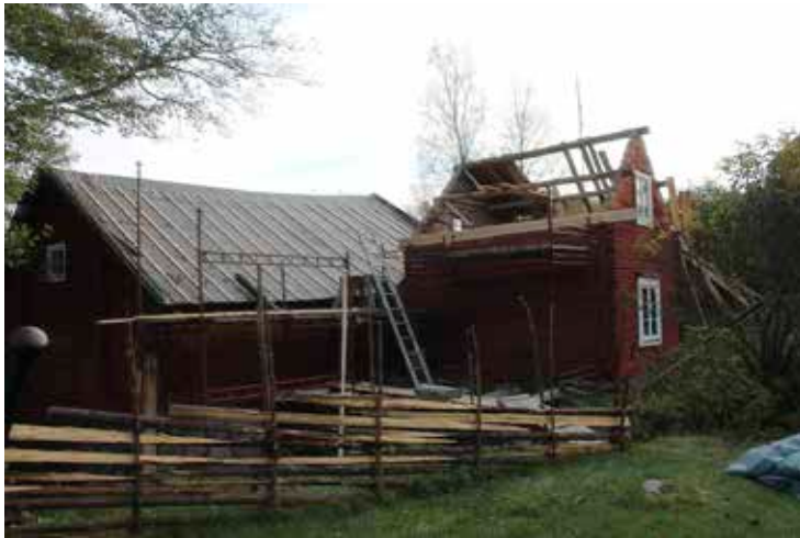
Fig 9. Kvarnkamarens tak under omläggning. Bild från entreprenör.
