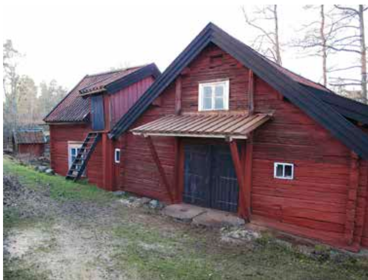
Figur 16. Skärmtaket efter åtgärd. Lp 201200813.
