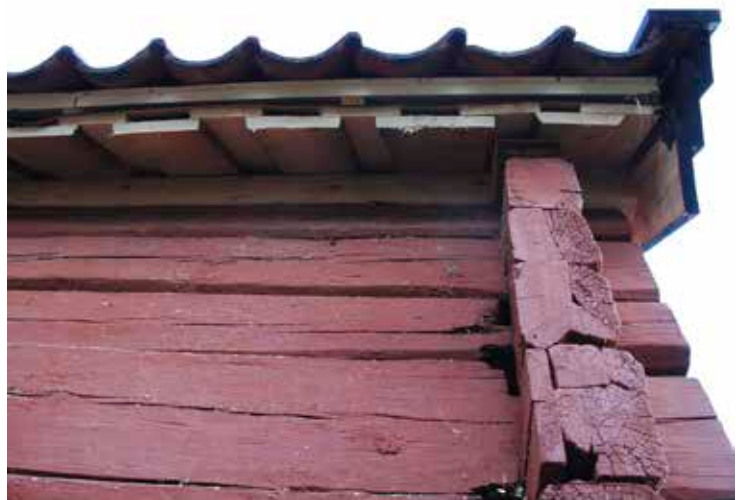
Figur 13. Kvarnkammaren efter åtgärd. Lp 201200825.
