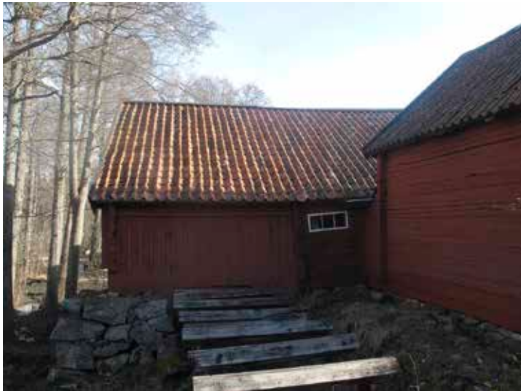
Figur 3. Kvarnbyggnadens tak innan åtgärd. Lp 201200795.
