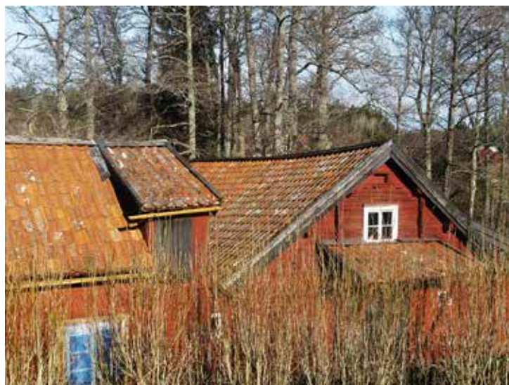
Figur 1. Kvarnbyggnadens tak innan åtgärd. Lp 201200790.
