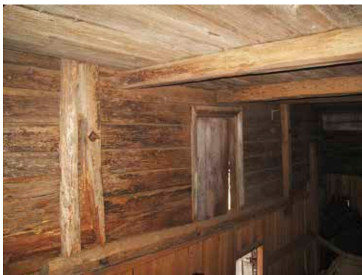
Figur 21. Överbyggnaden innan åtgärd. Lp 201200798.
