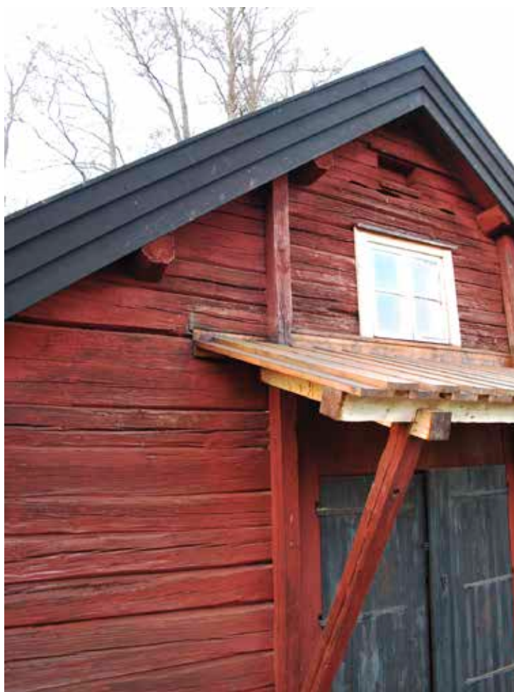
Figur 17. Skärmtaket efter åtgärd. Lp 201200827.
