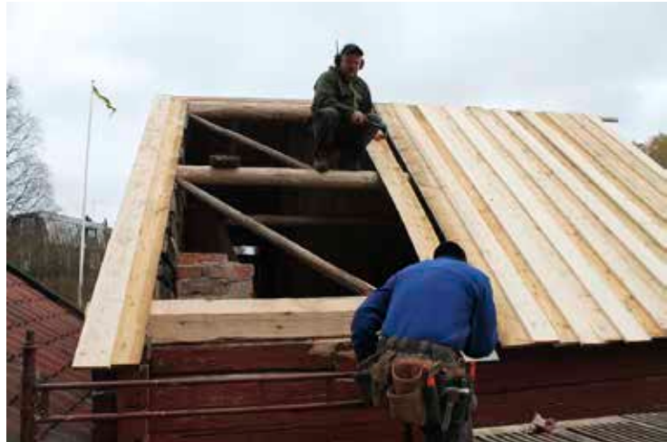
Figur 11. Kvarnkammarens tak under omläggning. Bild från entreprenör.
