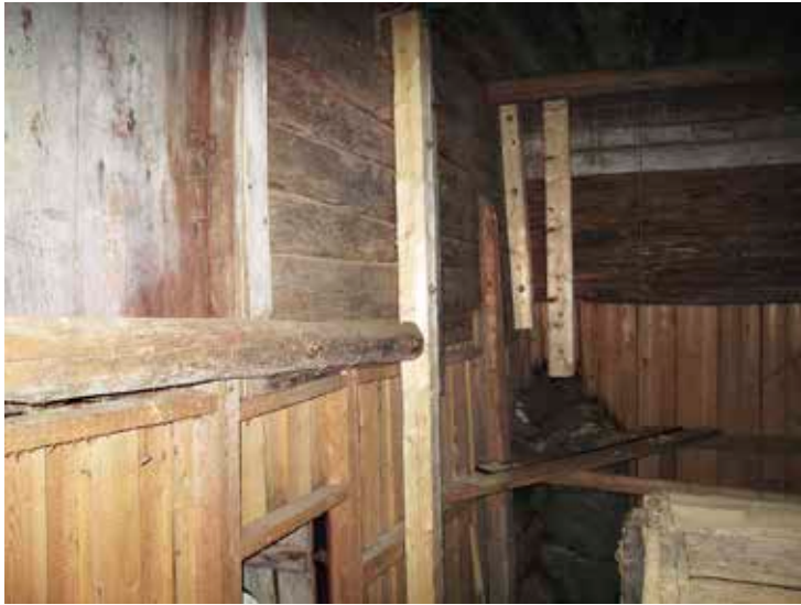
Figur 22. Överbyggnaden efter åtgärd. Lp 201200849.
