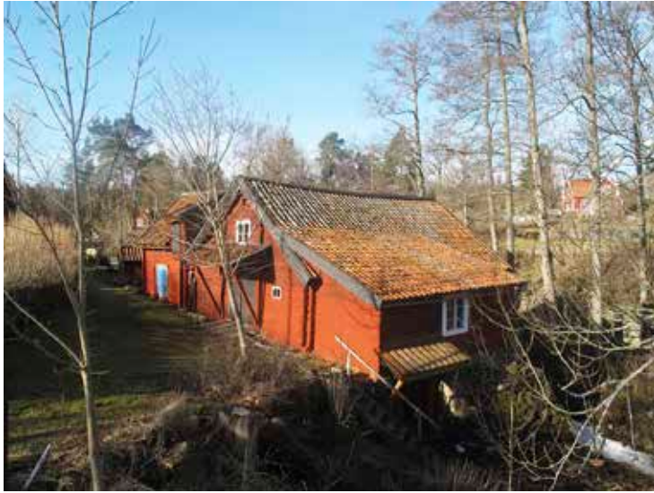
Figur 2. Kvarnbyggnadens tak innan åtgärd. Lp 201200794.
