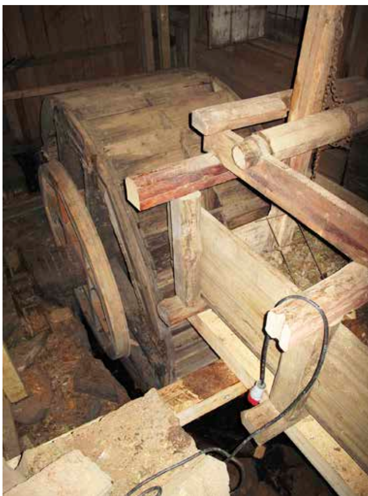
Figur 25. Kvarnrännans nya bjälklag. Lp 201200850.
