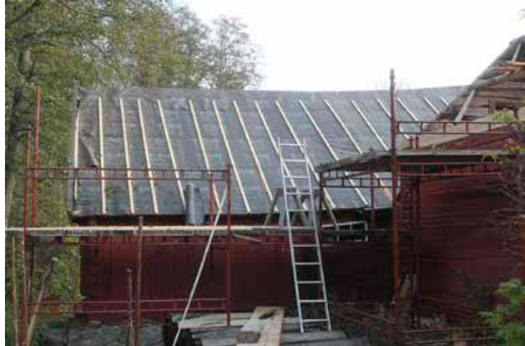
Figur 5. Kvarnbyggnadens tak under omläggning. Bild från entreprenör.
