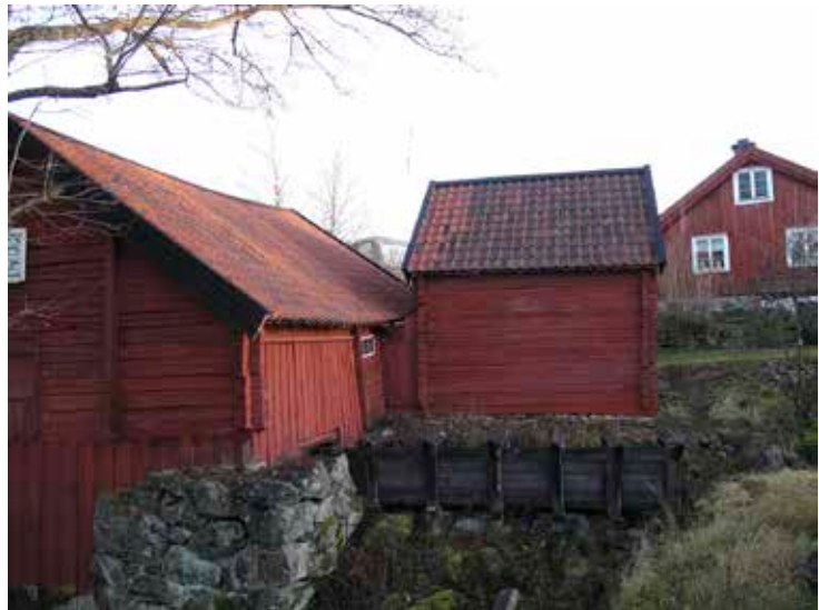
Figur 12. Kvarnkammaren efter åtgärd. Lp 201200820.
