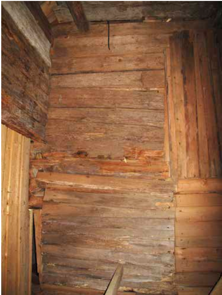
Figur 23. Överbyggnaden innan åtgärd. Lp 201200801.
