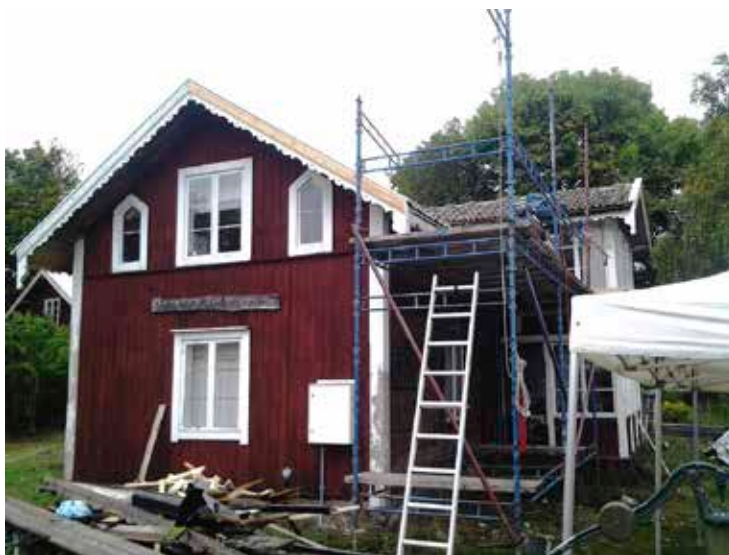
Figur 9. Västra gaveln innan åtgärder. Bild från entreprenören.
