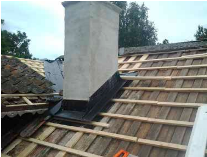
Figur 2. Norra takfallet med ny läkt. Bild från entreprenör.
