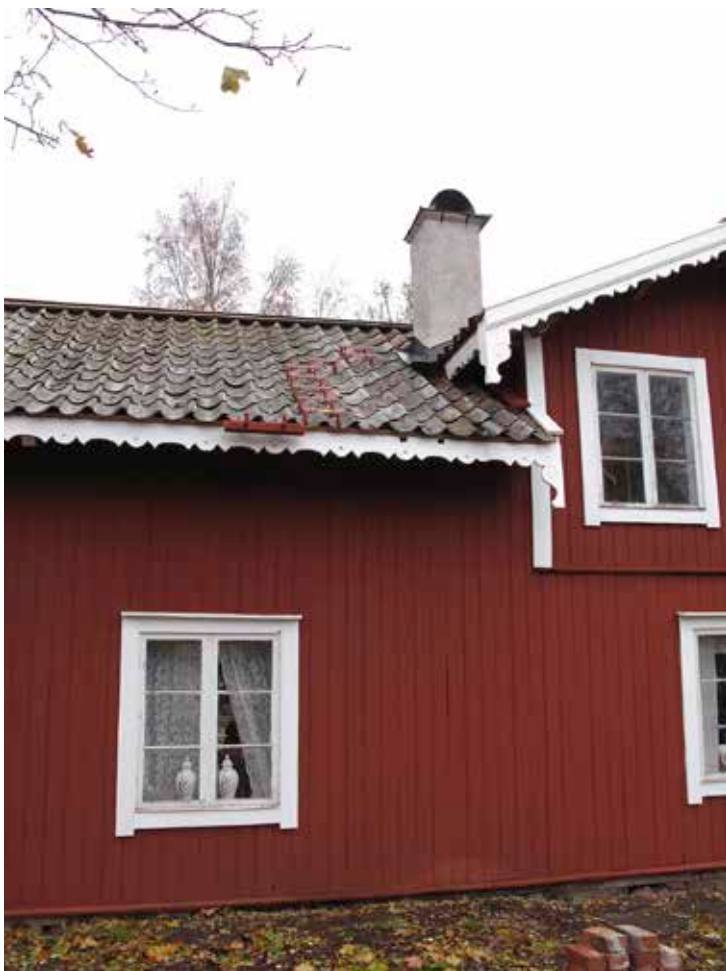
Figur 4. Takstege på norra takfallet. Foto Albin Uller 2012. Lp201200701.
