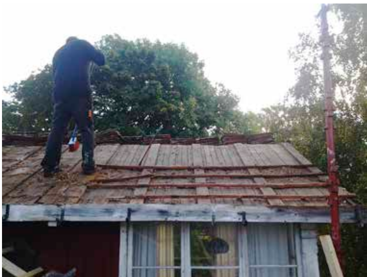
Figur 7. Verandataket efter nedtagning av teglet. Bild från entreprenören.
