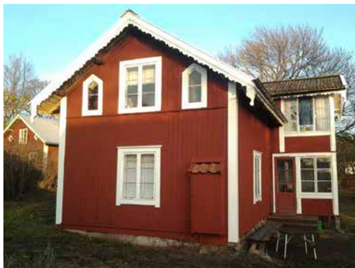
Figur 10. Västra gaveln efter åtgärder. Bild från entreprenören.
