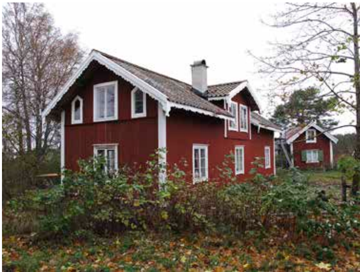
Figur 3. Norra takfallet efter åtgärd. Foto Albin Uller 2012. Lp201200700.
