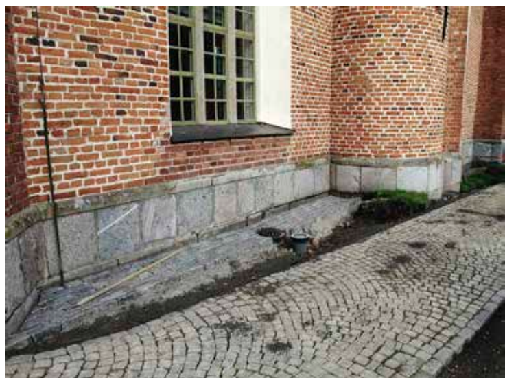
Figur 5. Ränndal samt nylagd smågat- och storgatsten. Foto Albin Uller 2012. Lp 201201016.
