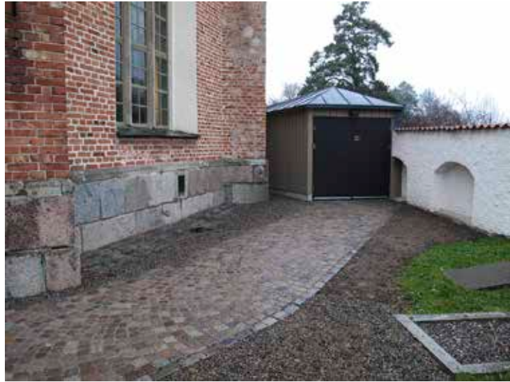
Figur 13. Grusgång efter åtgärd. Foto Albin Uller 2012. Lp 201201035.
