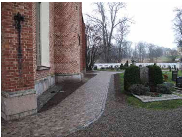
Figur 7. Grusgång efter åtgärd. Foto Albin Uller 2012. Lp 201201026.
