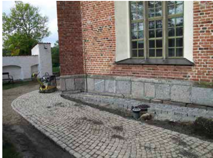
Figur 4. Ränndal samt nylagd smågat- och storgatsten. Foto Albin Uller 2012. Lp 201201013.
