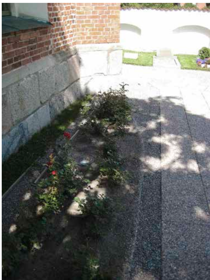
Figur 2. Plantering samt den gamla fasadbelysningen. Foto Anders Scherman AIX Arkitekter.
