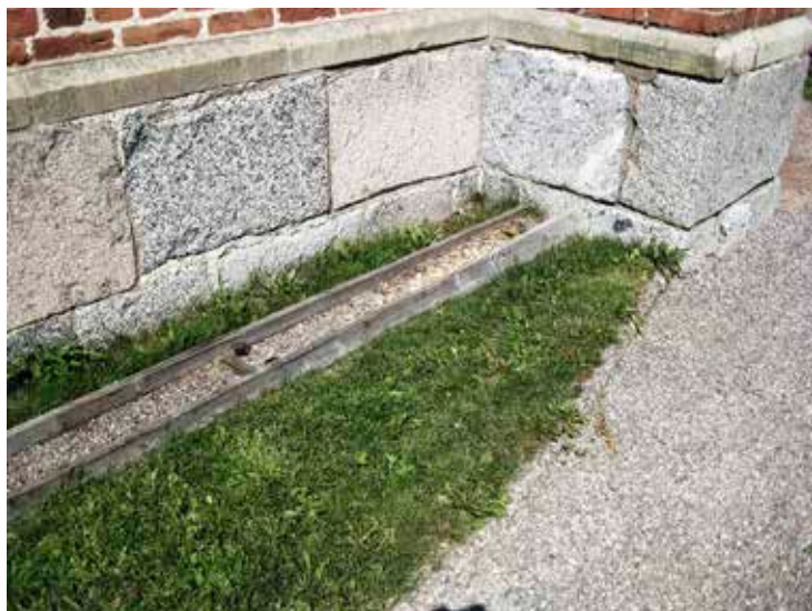
Figur 1. Dränerad grusbädd. Foto Anders Scherman AIX Arkitekter.
