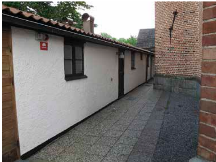
Figur 14. Gång på kyrkans norra sida innan åtgärd. Foto Albin Uller 2012. Lp 201201004.
