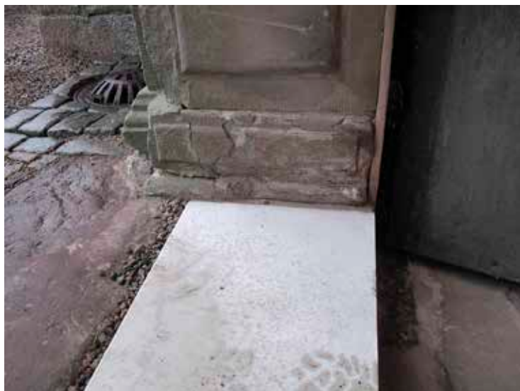
Figur 5. Tröskel efter åtgärd. Foto Albin Uller 2012. Lp 201200948.
