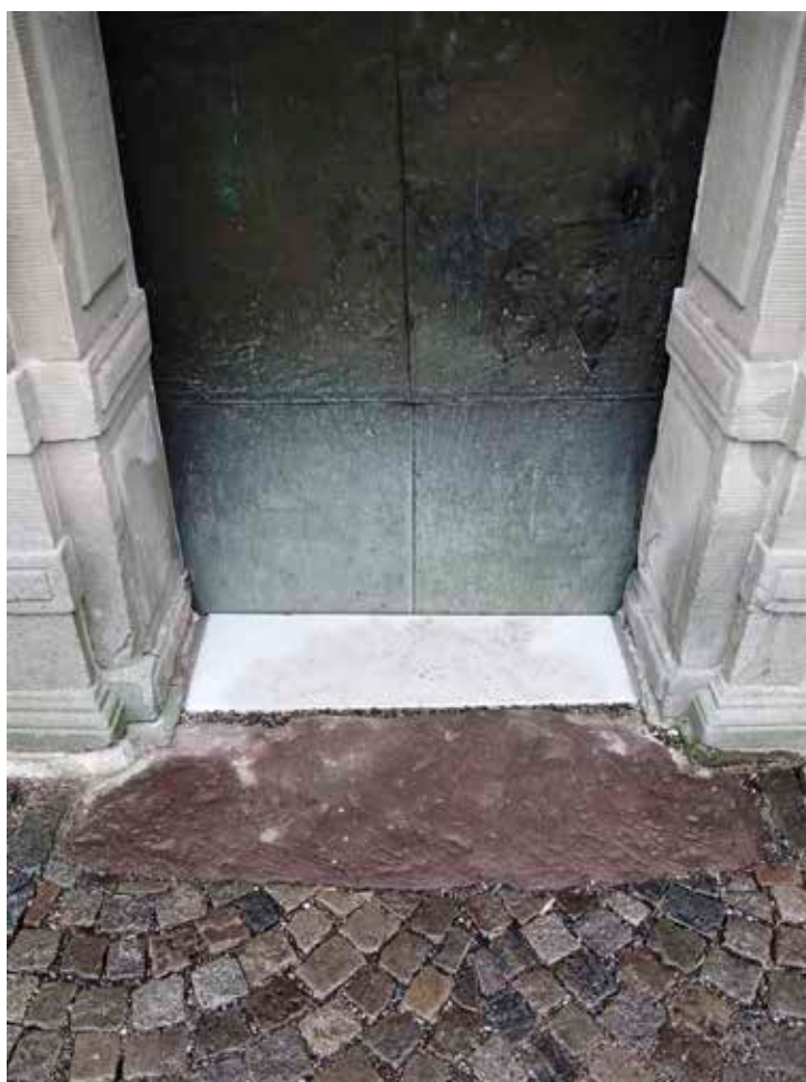
Figur 4. Tröskel och port efter åtgärd. Foto Albin Uller 2012. Lp 201200935.
