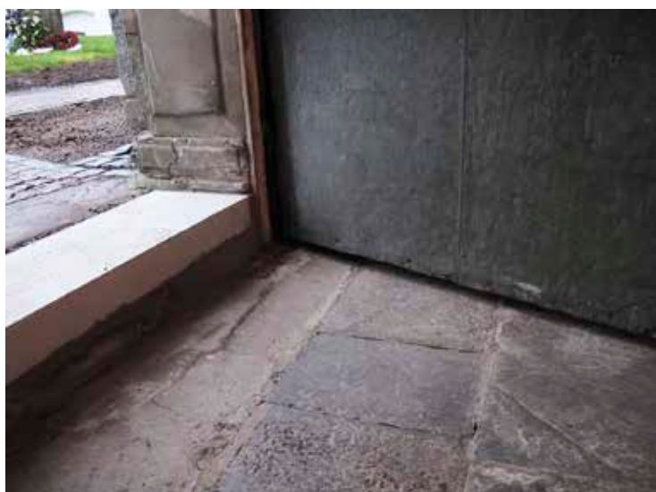
Figur 6. Tröskel och port efter åtgärd. Foto Albin Uller 2012. Lp 201200945.
