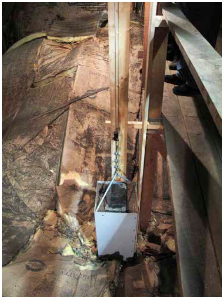
Figur 11. Stålkorgen som fungerar som motvikt. Foto Albin Uller 2012. Lp 201200954.
