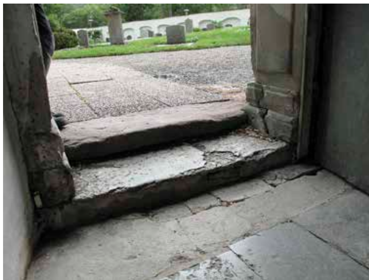
Figur 3. Tröskel och port innan åtgärd. Foto Albin Uller 2012. Lp 201200930.
