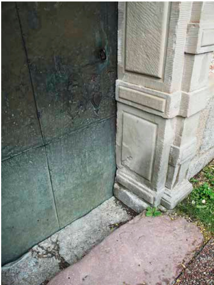
Figur 2. Tröskel och port innan åtgärd. Foto Albin Uller 2012. Lp 201200928.
