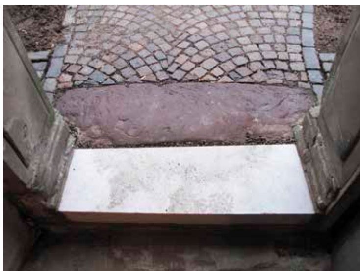
Figur 7. Tröskel efter åtgärd. Foto Albin Uller 2012. Lp 201200950.
