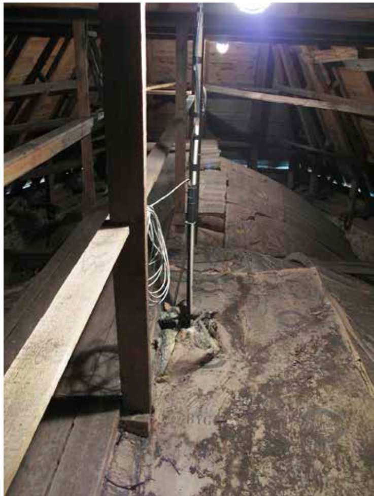
Figur 8. Den tidigare upphängingen och genomförningen i valvet. Foto Albin Uller 2012. Lp 201200933.
