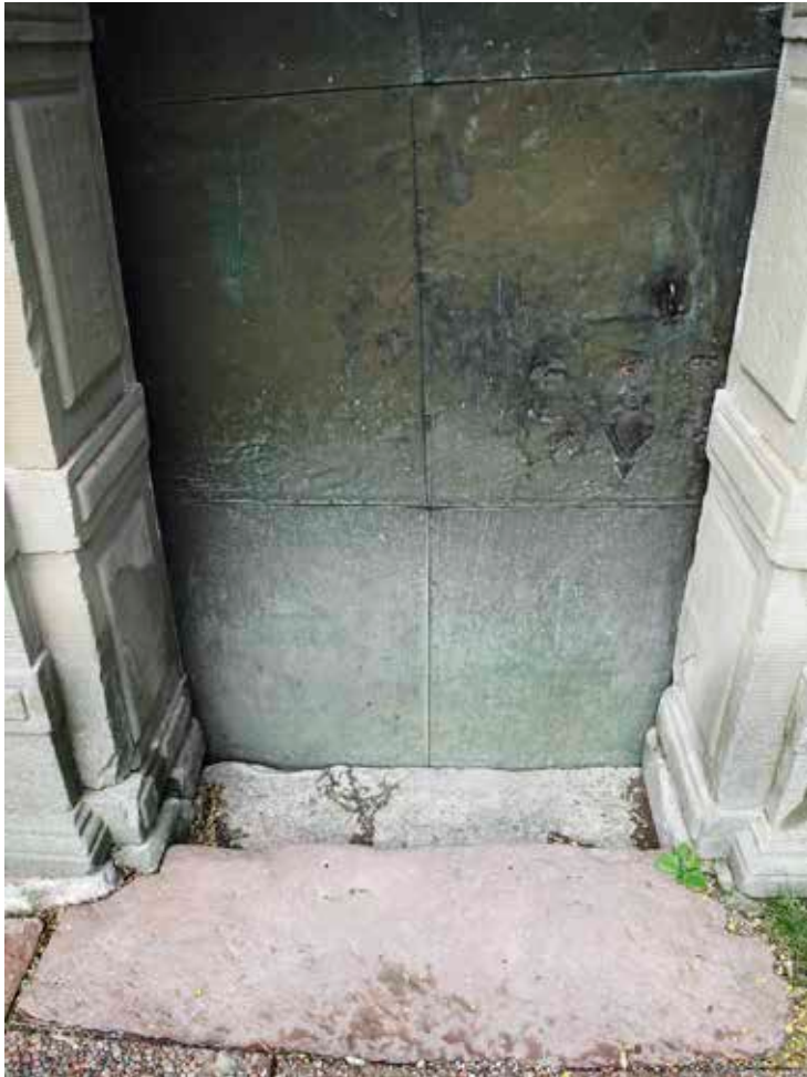
Figur 1. Tröskel och port innan åtgärd. Foto Albin Uller 2012. Lp 201200926.
