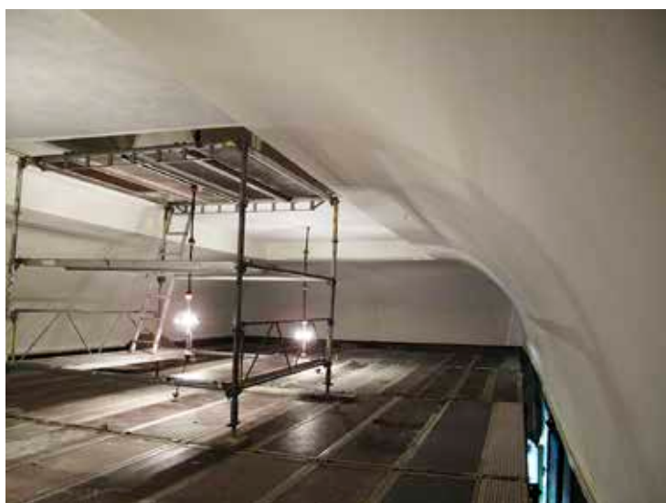
Figur 2. Kyrksalens välvda tak under ommålning. Foto Albin Uller 2012. Lp201200744.
