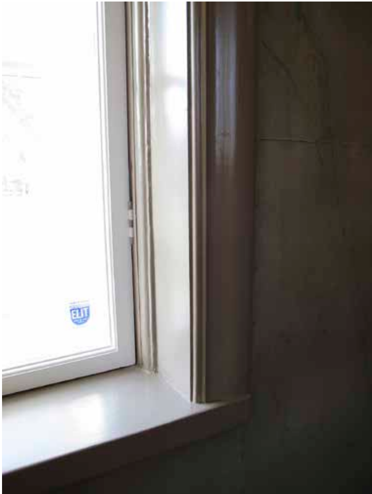
Figur 14. Fönsterfoder efter ommålning. Foto Albin Uller 2012. Lp201200766.
