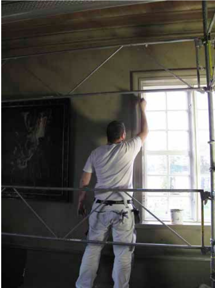
Figur 13. Fönsterfoder under ommålning. Foto Albin Uller 2012. Lp201200738.
