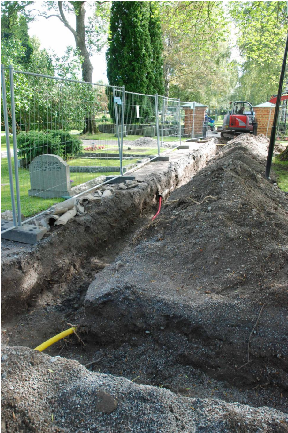
Fig. 5. Schaktets sträckning mot öst, mot bogårdsmuren. Foto Tove Stjärna.
