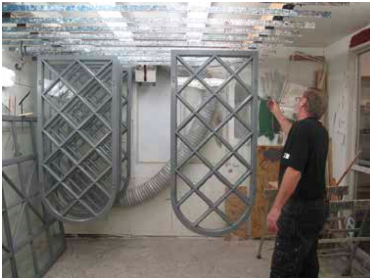
Figur 3. Fönstren ströks med grå linoljefärg vid ett besök i verkstaden på Uppsala Fönsterhantverk. LP_2013_00027. Foto H Bellberg
