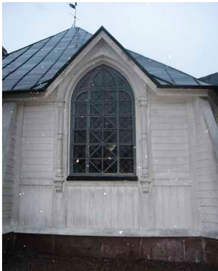
Figur 8. Vid slutbesikningen snöade det juligt, mittkorfönstret restaurerat och återplacerat. LP_2013_00032. Foto H Bellberg
