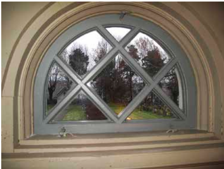
Figur 10. Ett restaurerat fönster i närstudie, invändigt. LP_2013_00034. Foto H Bellberg
