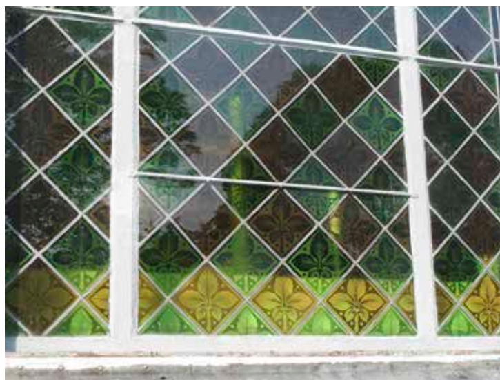
Figur 1. Detalj av mittkorfönstret med de blyinfattade jugendromberna, utvändigt mot öster. LP_2013_00025. Foto H Bellberg
