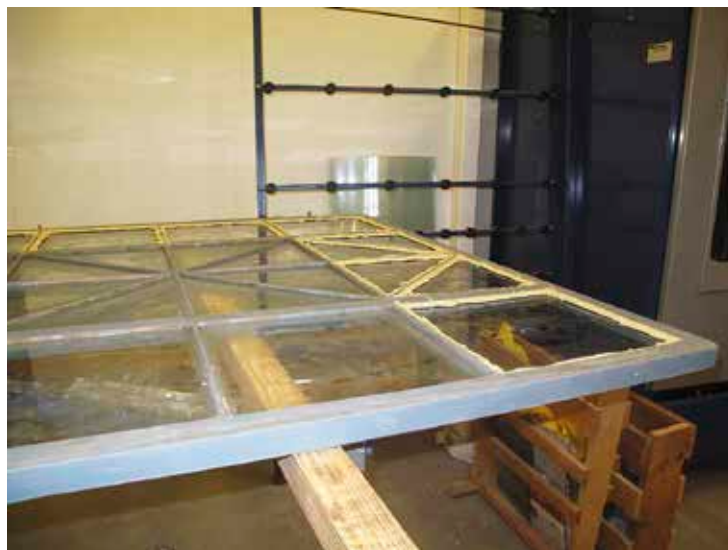
Figur 4. Ett korffönster under skrapning från färgrester och kittlagning med linoljekitt, spruckna glasrutor ersattes med munblåst gammalt glas. LP_2013_00028. Foto H Bellberg
