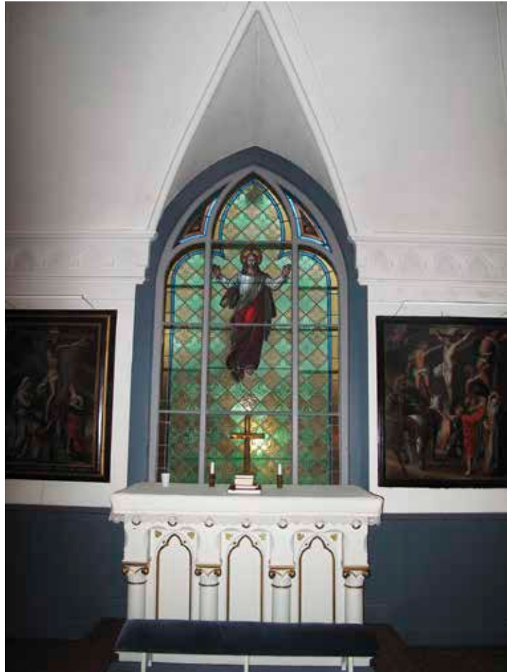
Figur 7. Mittkorfönstret med Kristusbilden och bågarna restaurerade och återplacerade. LP_2013_00031. Foto H Bellberg
