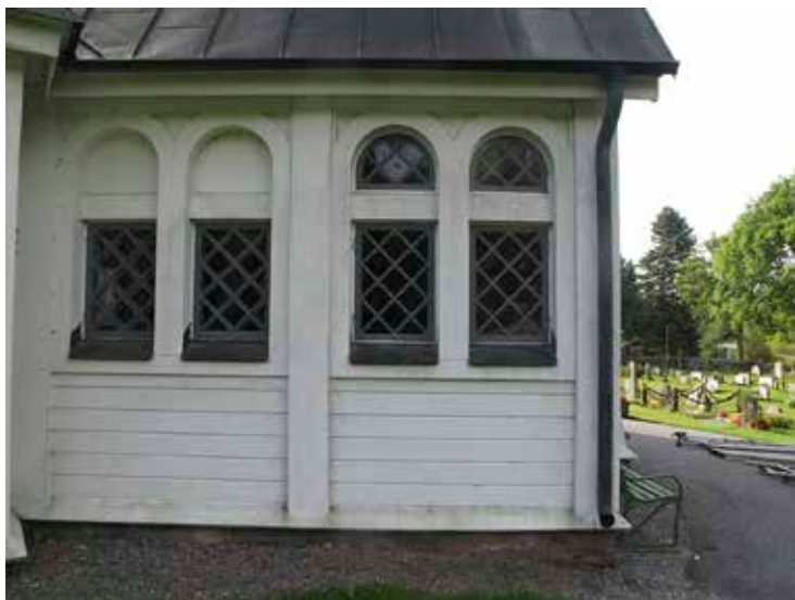
Figur 6. Fönstren mot norr i vapenhuset med en djupgrå kulör efter restaurering. LP_2013_00030. Foto H Bellberg
