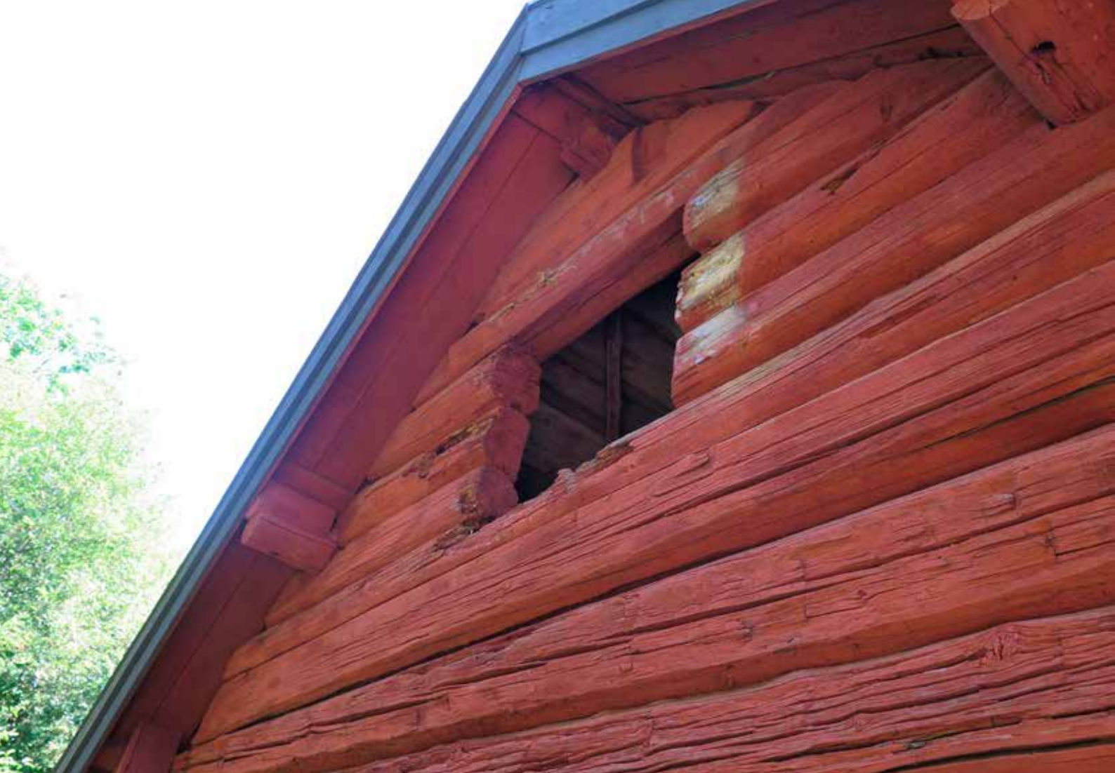
Fig. 6 LP_2014_00130. Öppning i norra väggen som tidigare varit igenspikad med bräder.
