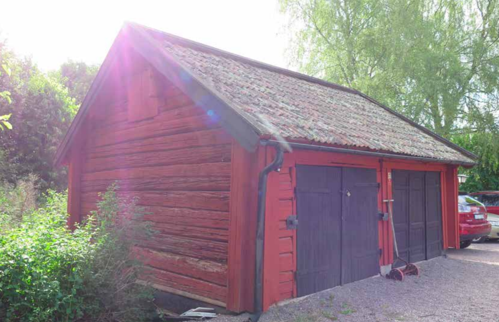
Fig. 4 LP_2014_00109. Vagnslidret fotograferat från nordväst, före genomförda åtgärder.
