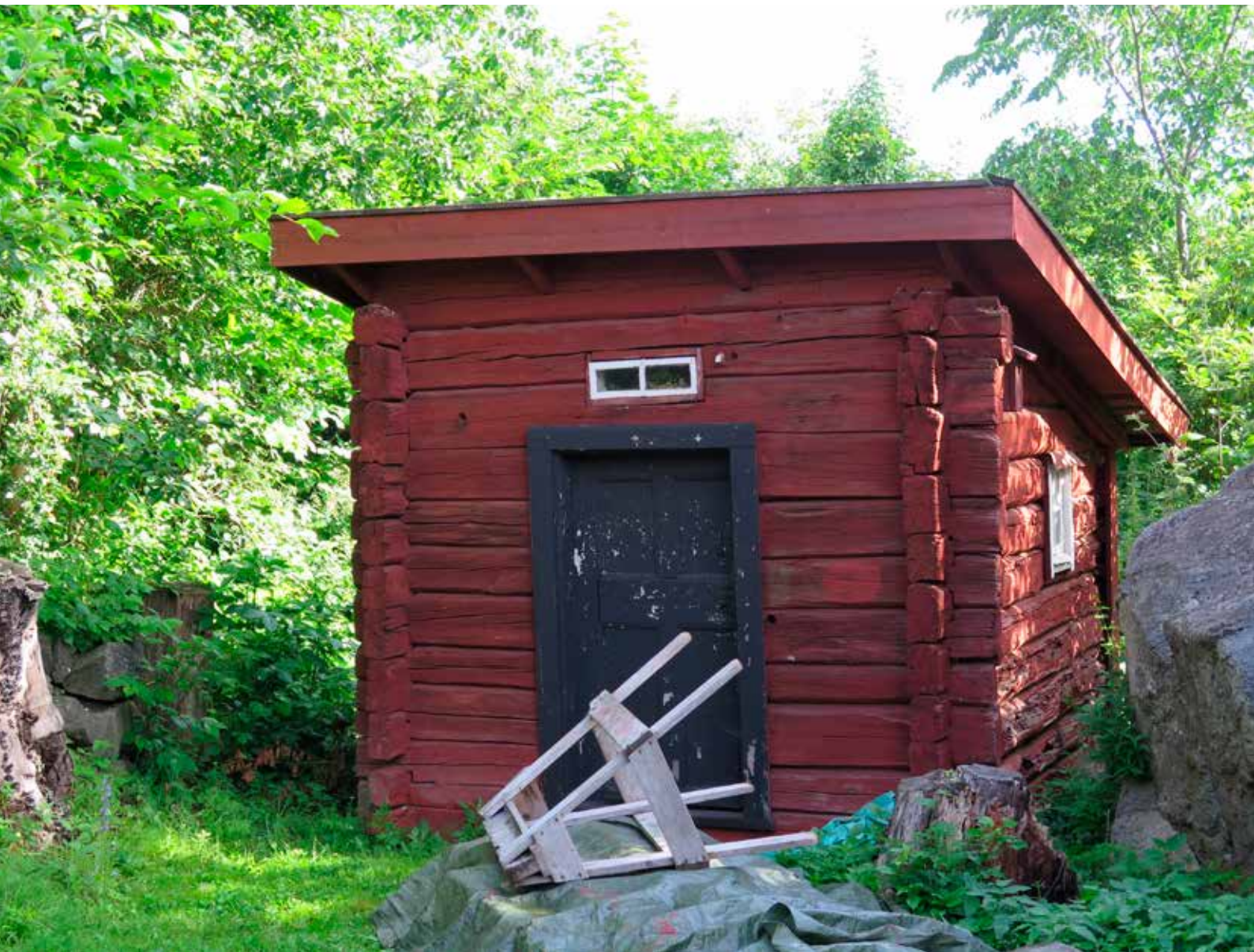
Fig 11. LP_2014_00113. Hemlighuset före genomförda åtgärder.
