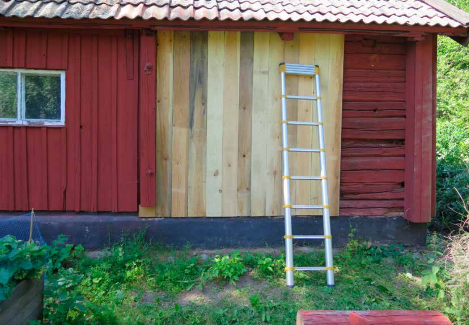
Fig. 8 LP_2014_00132. Vagnslidret under pågående arbete. Panelning av östra väggen.
