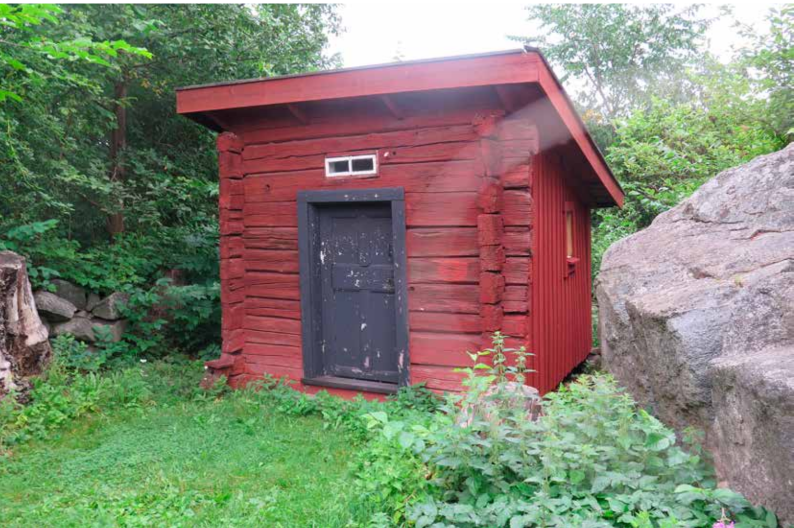
Fig 13. LP_2014_00134. Hemlighuset efter genomförda arbeten. Målning av fönstersnickerier återstod delvis när fotot togs.
