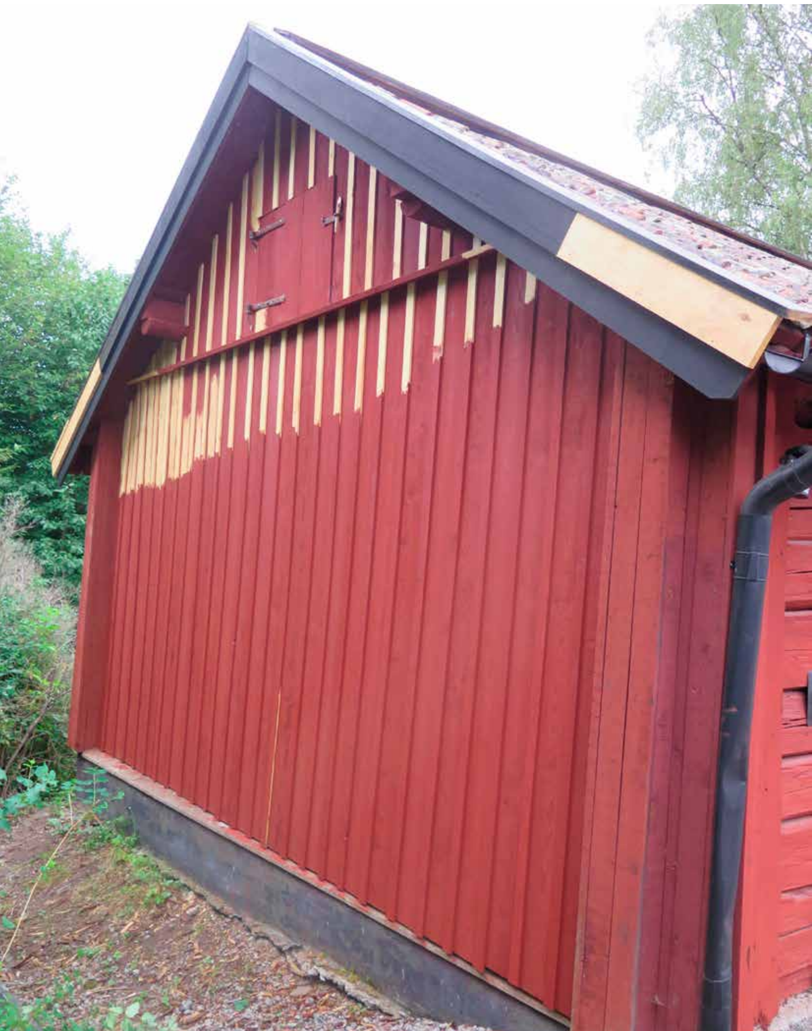
Fig 10. LP_2014_00138. Vagnslidrets norra gavel efter genomförda arbeten: ny panel, delvis nya vindskivor, nya vattbräder och nytillverkad lucka för öppning.
