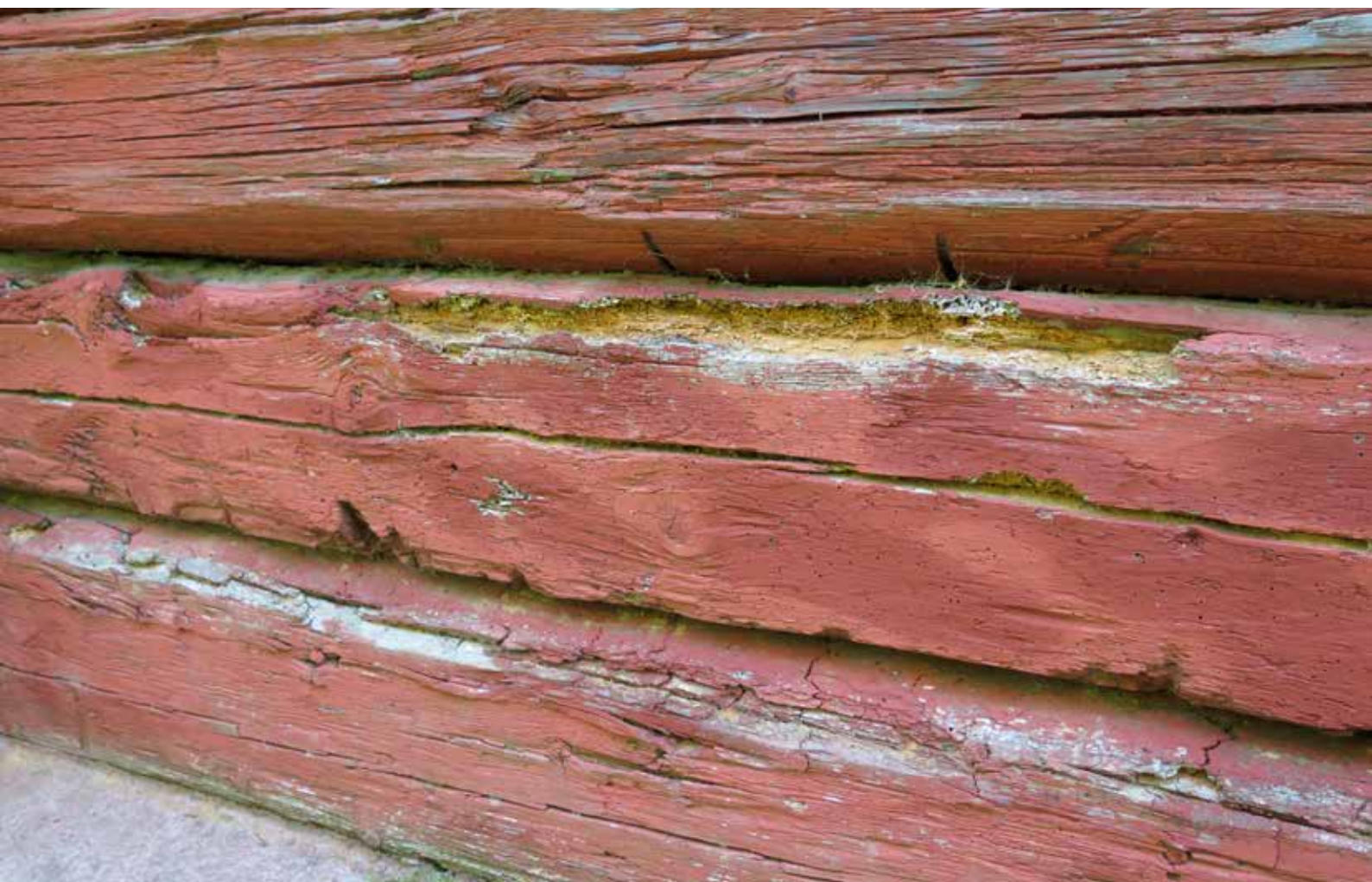
Fig. 5 LP_2014_00129. Detalj från vagnslidrets norra vägg. Delar av väggen ströks med fotogen för att stoppa eventuella pågående insektsangrepp.
