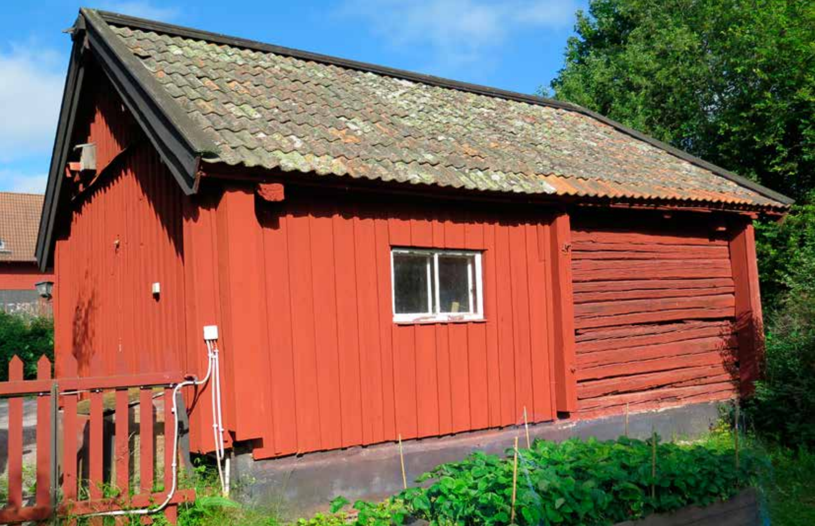
Fig. 2 LP_2014_00107. Vagnslidrets östra långsida före genomförda åtgärder.
