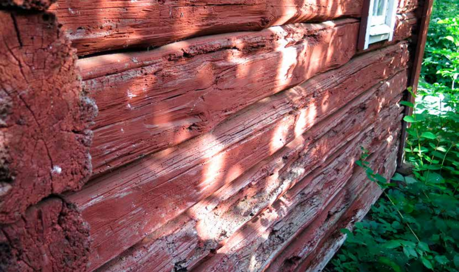
Fig 12. LP_2014_00114. Hemlighusets östra vägg före panelning.
