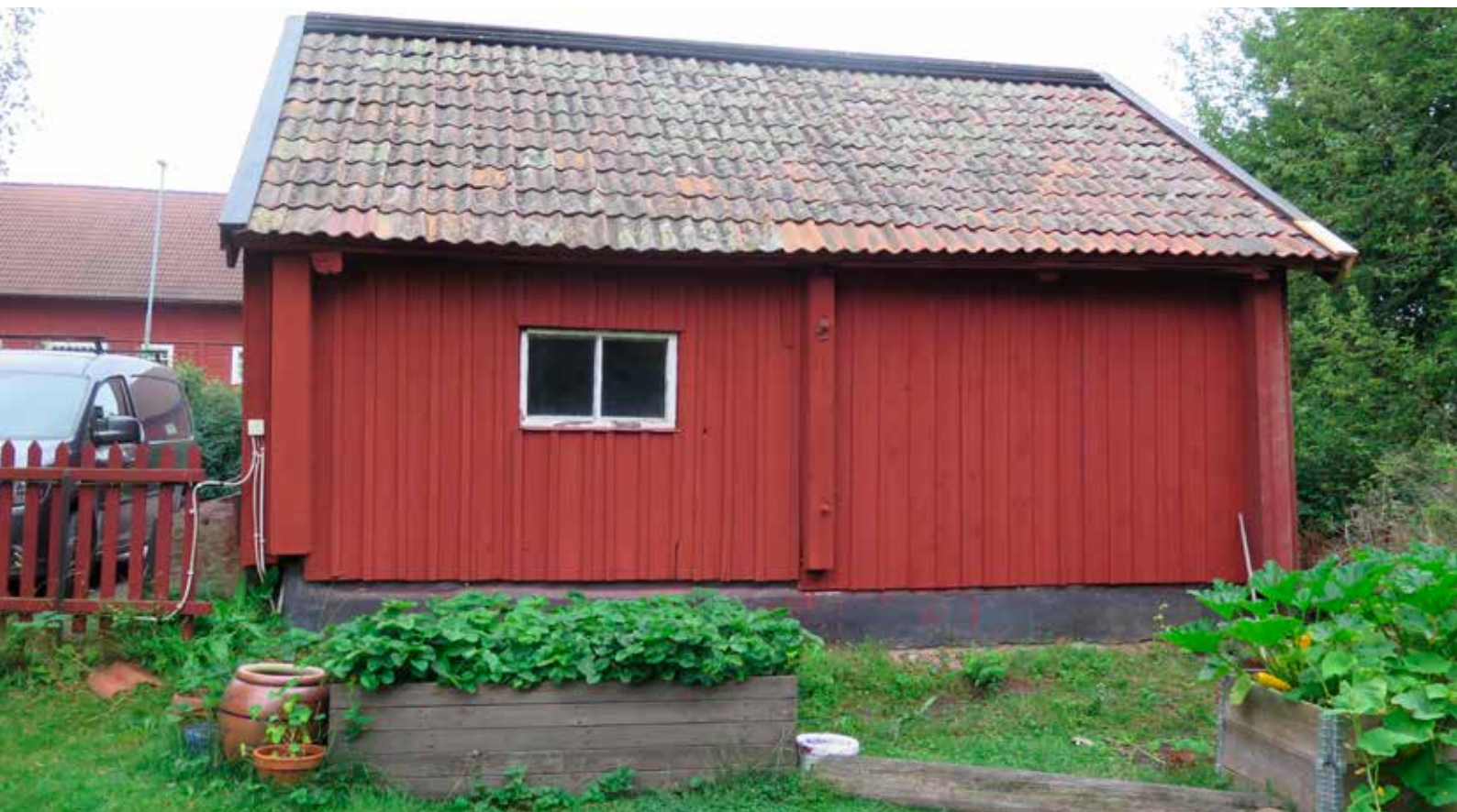
Fig. 9 LP_2014_00135. Vagnslidrets östra vägg efter genomfört arbete.
