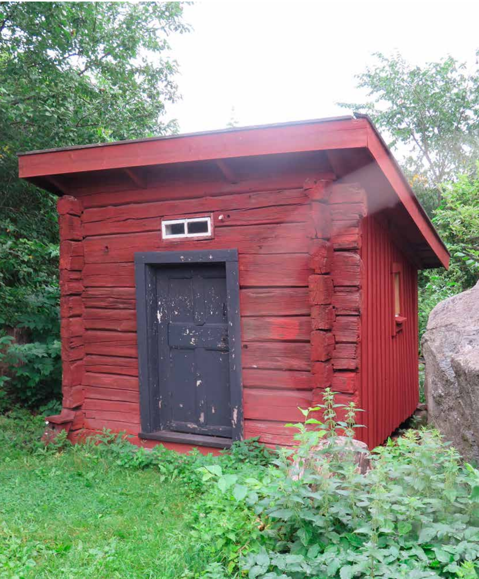
Fig 1. LP_2014_00134 Hemlighuset efter genomförda arbeten. Målning av fönstersnickerier återstod delvis när fotot togs. (Även Fig.13 på sid 14)
