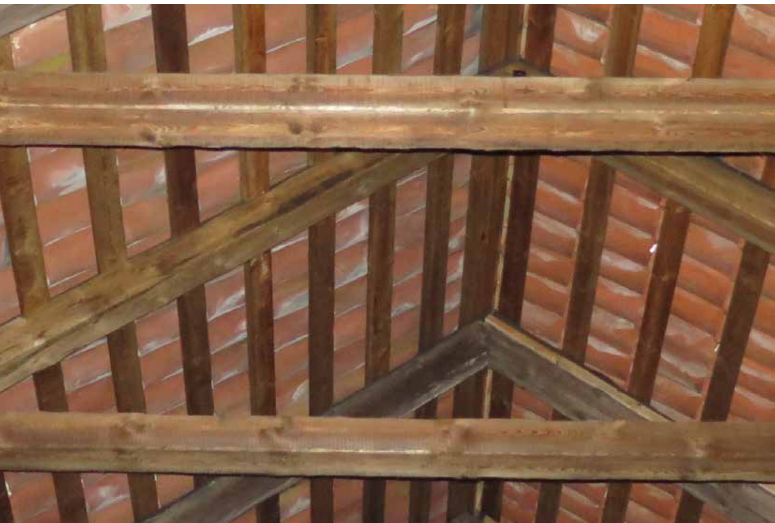
Fig.7. Taket efter genomförda åtgärder. LP_2014_00293.
