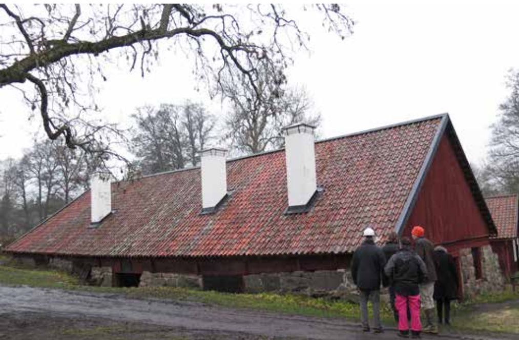
Fig.8. Det södra takfallet efter genomförda arbeten. LP_2014_00294.
