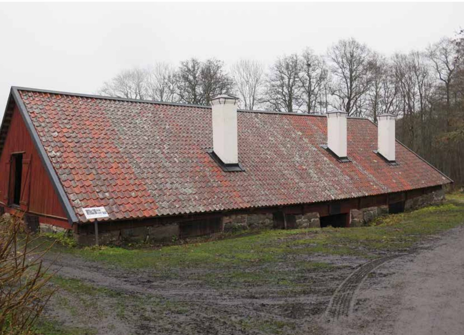
Fig.1. Stora smedjans södra takfall efter genomförda takarbeten. LP_2014_00291.
