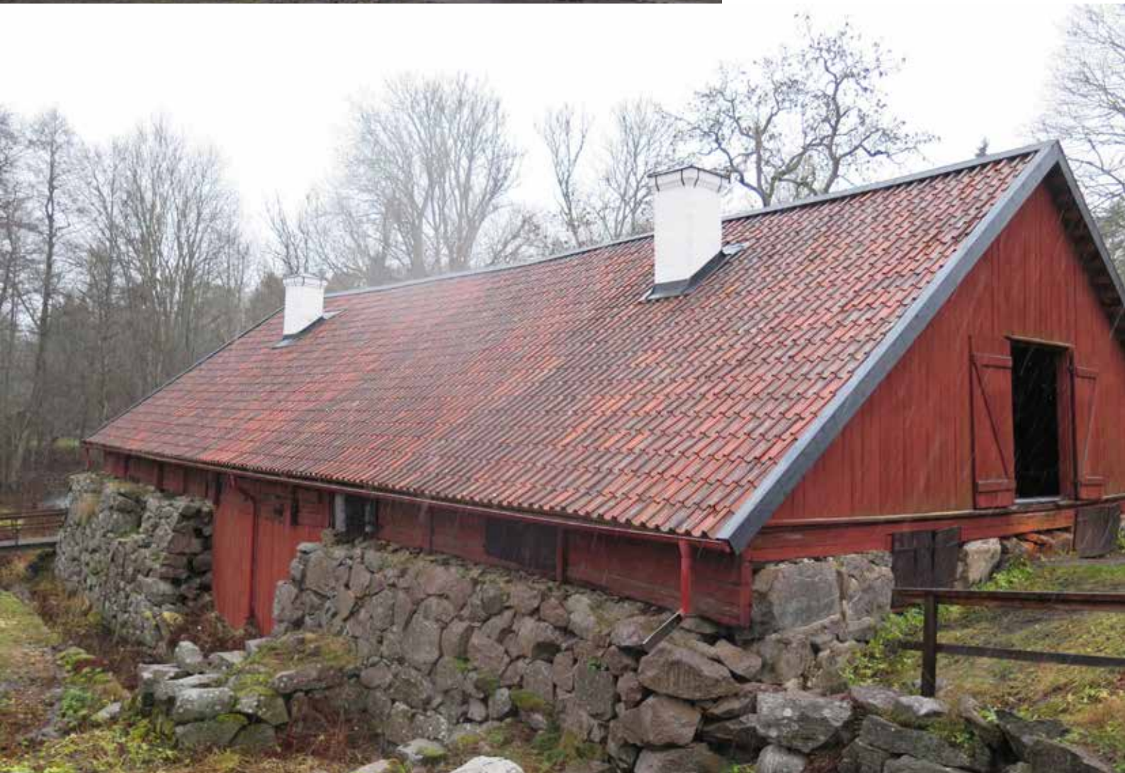
Fig.9. Det norra takfallet efter genomförda arbeten. LP_2014_00295.
