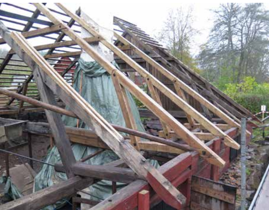
Fig.6. Delar av takstolar har bytts ut till nytillverkade. LP_2014_00292.
