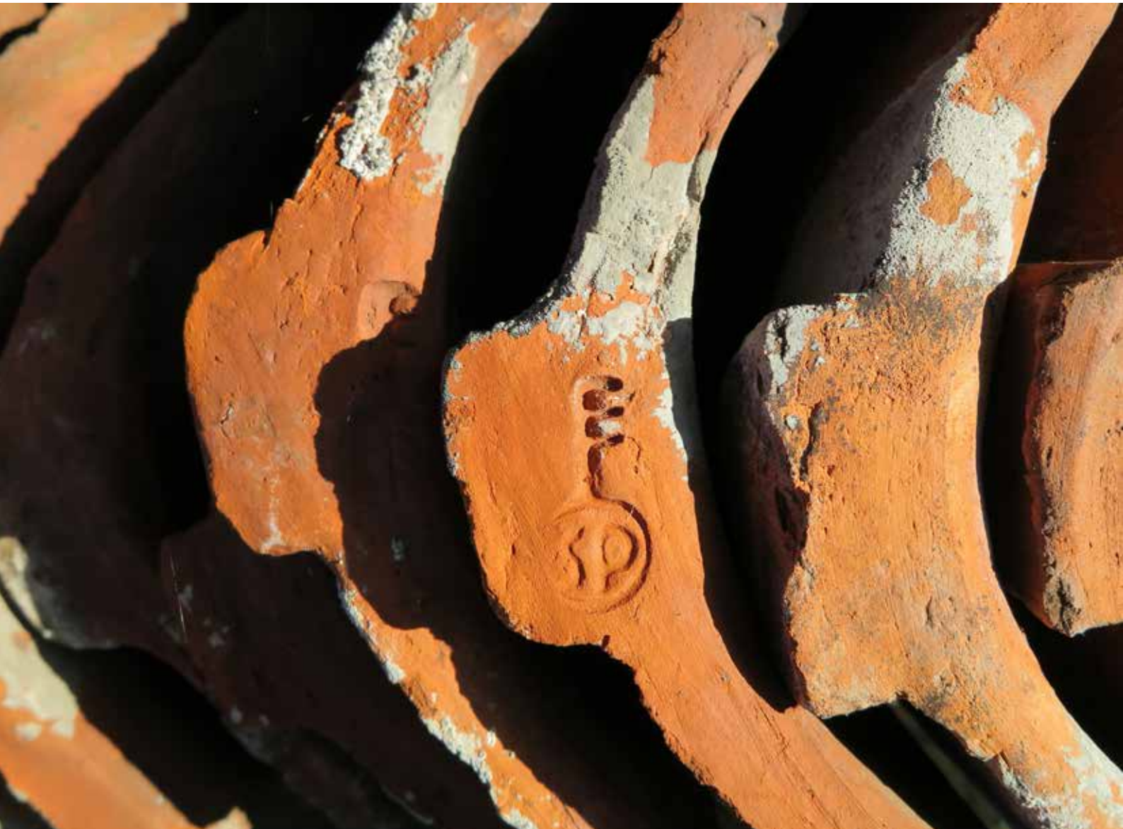
Fig.10. Nedplockade äldre tegelpannor. Här med stämpeln SP, S:t Petri nyckel. LP_2014_00296.
