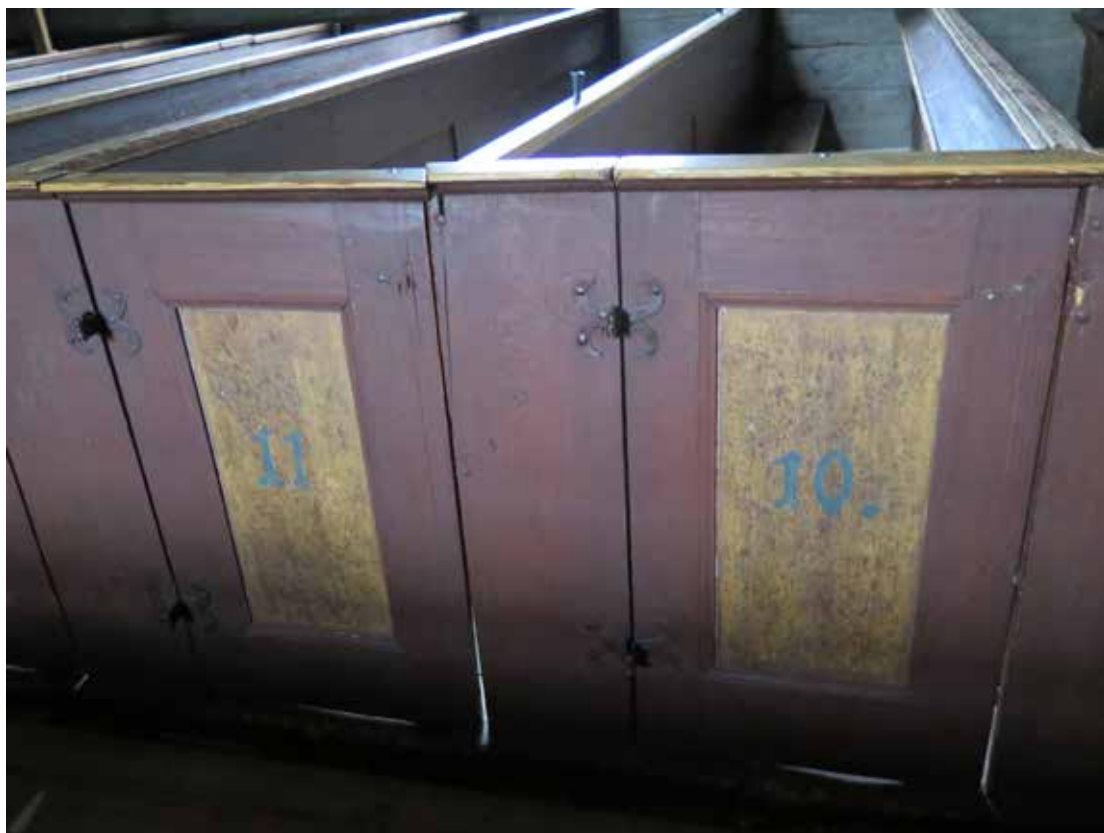
Fig. 21. Bänkarna har en färgsättning i brunt som återställdes vid flytten till Skansen. Lp201400321
