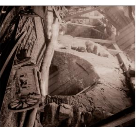
Bilden är tagen på 40-talet ungefär där du står nu. Trots att masugnen varit nedlagd ett bra tag och börjat förfalla får man en ganska bra bild av rådstugan. Du kan bland annat se gjutformarna i sanden framför utslagsbrösten och hur rådstugan var överbyggd med tak. Foto Tekniska museet.
