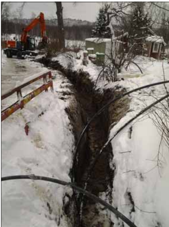
Fig 10. Schaktningsarbete vid delsträcka 5. (bildnr 2012-12-13 14.05.52)
