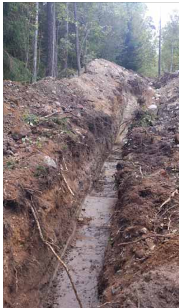
Fig 11. Schaktning vid delsträcka 6, Kaggeholmsvägen. Foto från nordväst.
