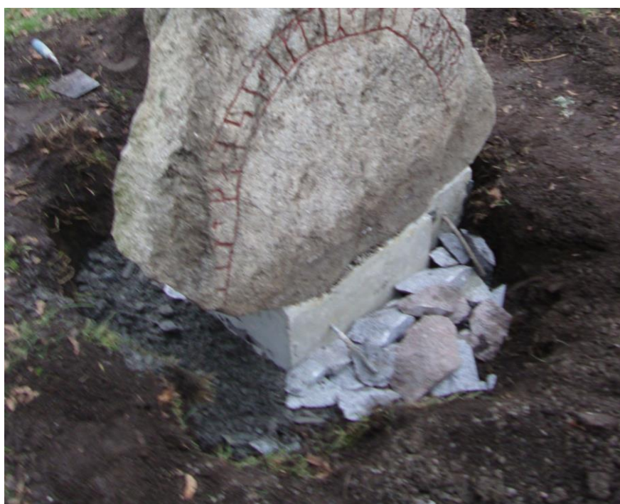
Stenkross lades ut på runstenens framsida. Betong blandades och lades på armering och med mera sten
