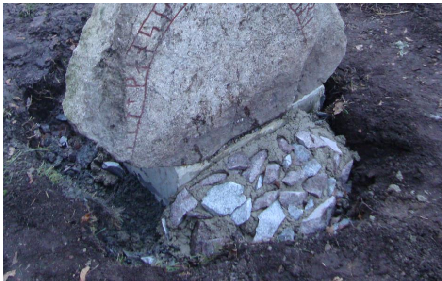
Betong blandades och lades på armering och med mera sten
