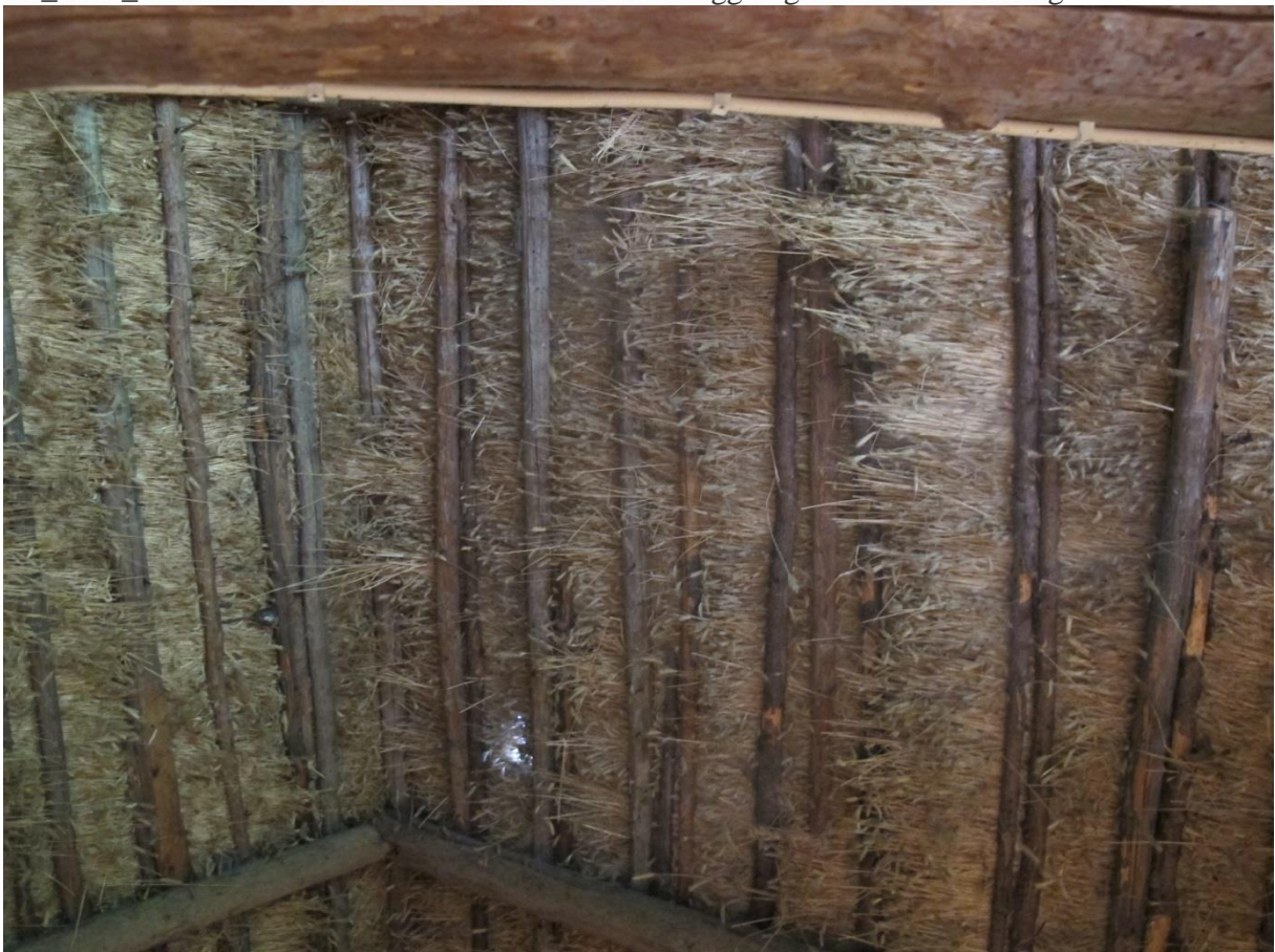
LP_2015_00106. Inifrån syntes hål i det gamla halmtaket. Foto H. Bellberg
