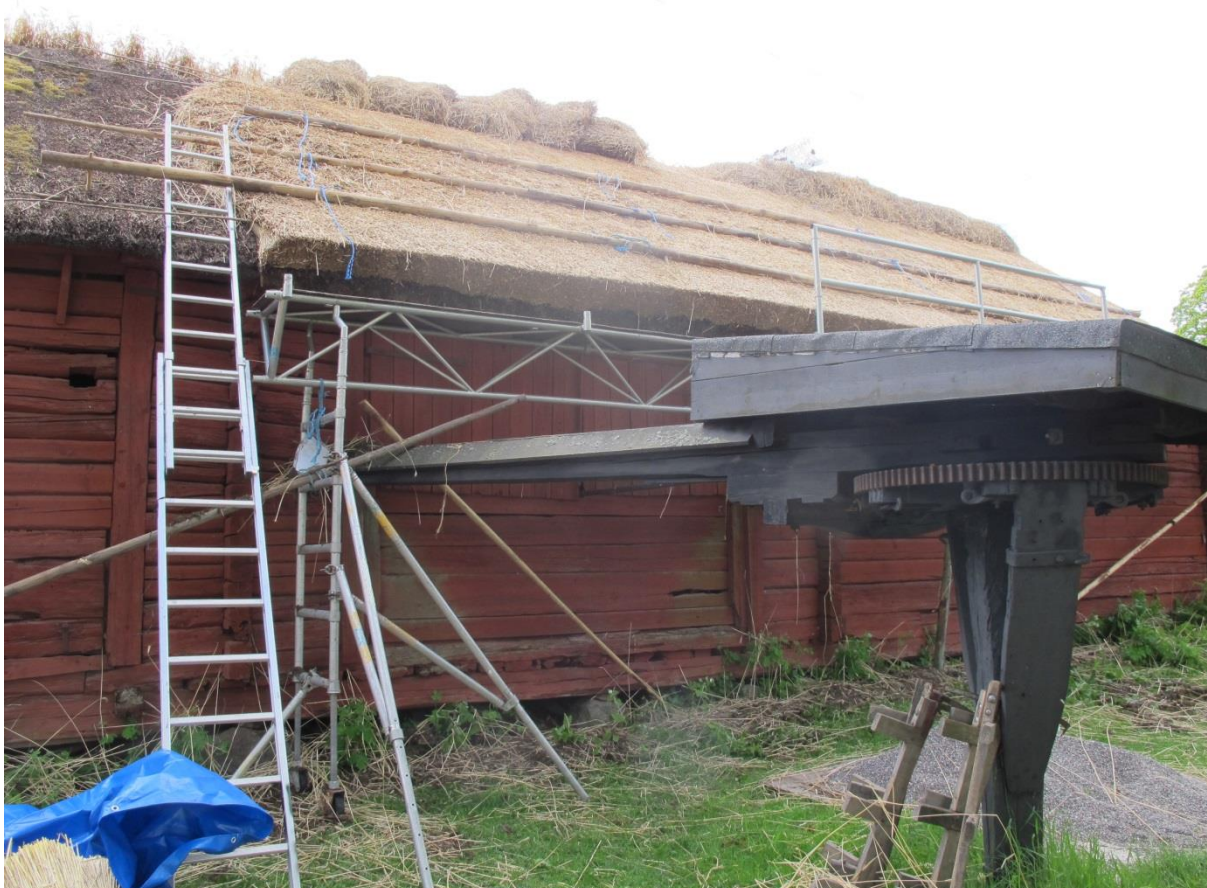
LP_2015_00110. Gamla och nya halmtäckningen. T.v. skymtar hasselkäpparna. Foto H. Bellberg
