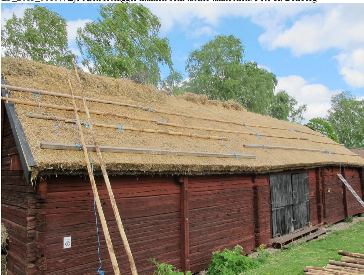
LP_2015_00108. Sydsidans nya halmtäckning. Temporärt ligger vågräta slanor. Foto H. Bellberg
