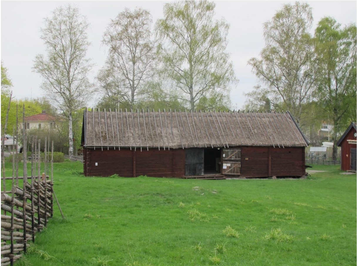
LP_2015_00103. Ytterbylogen sedd från söder före takomläggningen. Foto H. Bellberg
