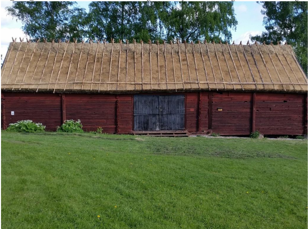
Ytterbylogen efter takomläggningen. Foto Per-Inge Gyllenhammar 2015-05-24
