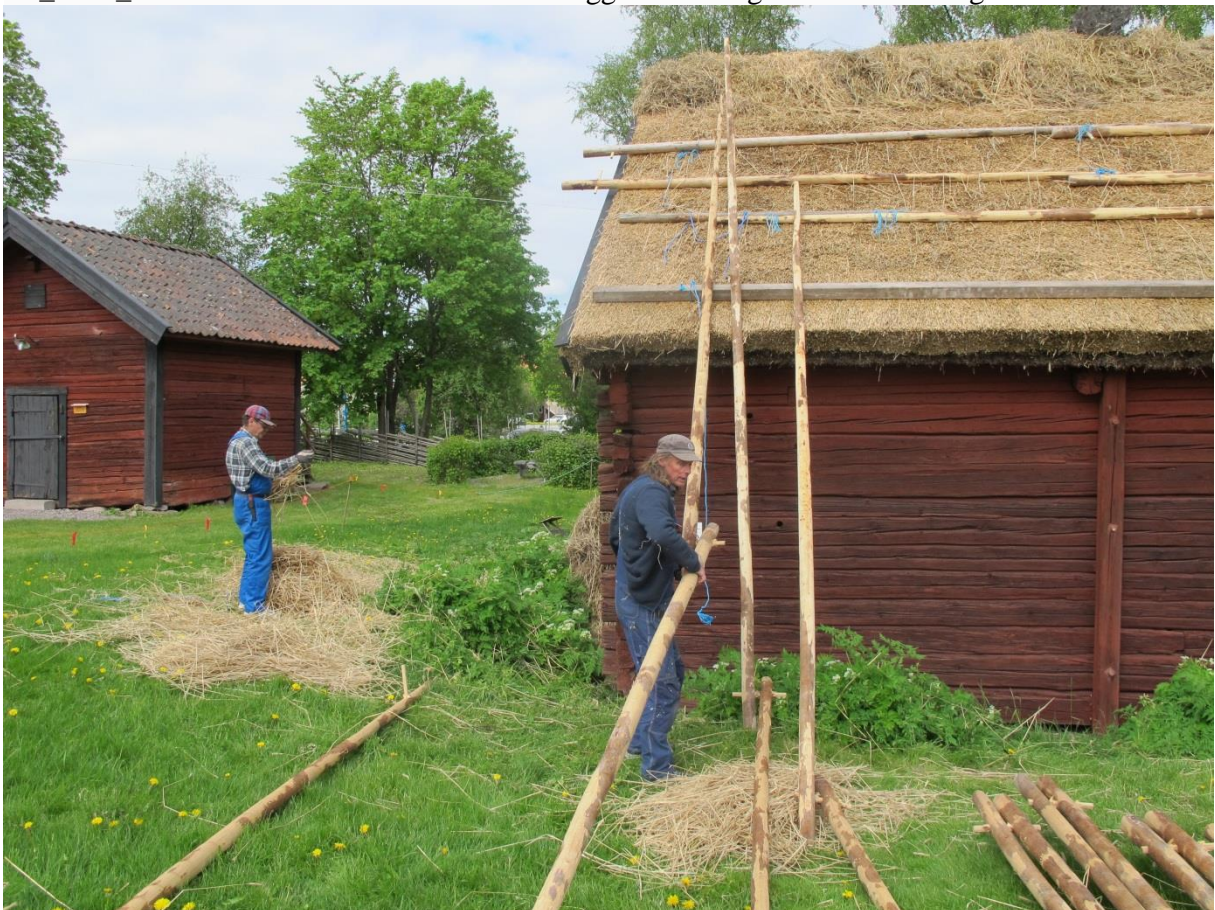
LP_2015_00112. Eje demonstrerar hur hängslanorna senare lyfts på plats. Foto H. Bellberg
