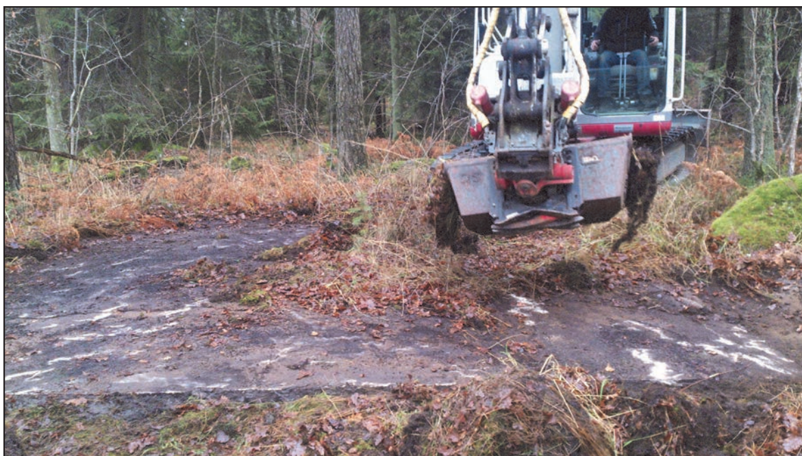
Fig 8. Objekt 16, framtågning av robotplatta.
