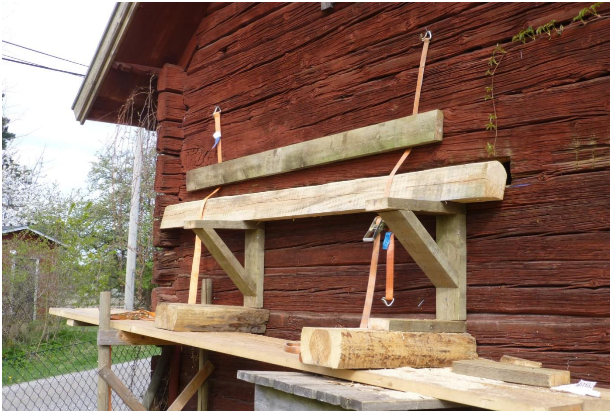
Den nya stocken bearbetades för att få en exakt passform och provades under arbetets gång i urtaget för att slutligen passas och slås in. Foto E. Lagerström
