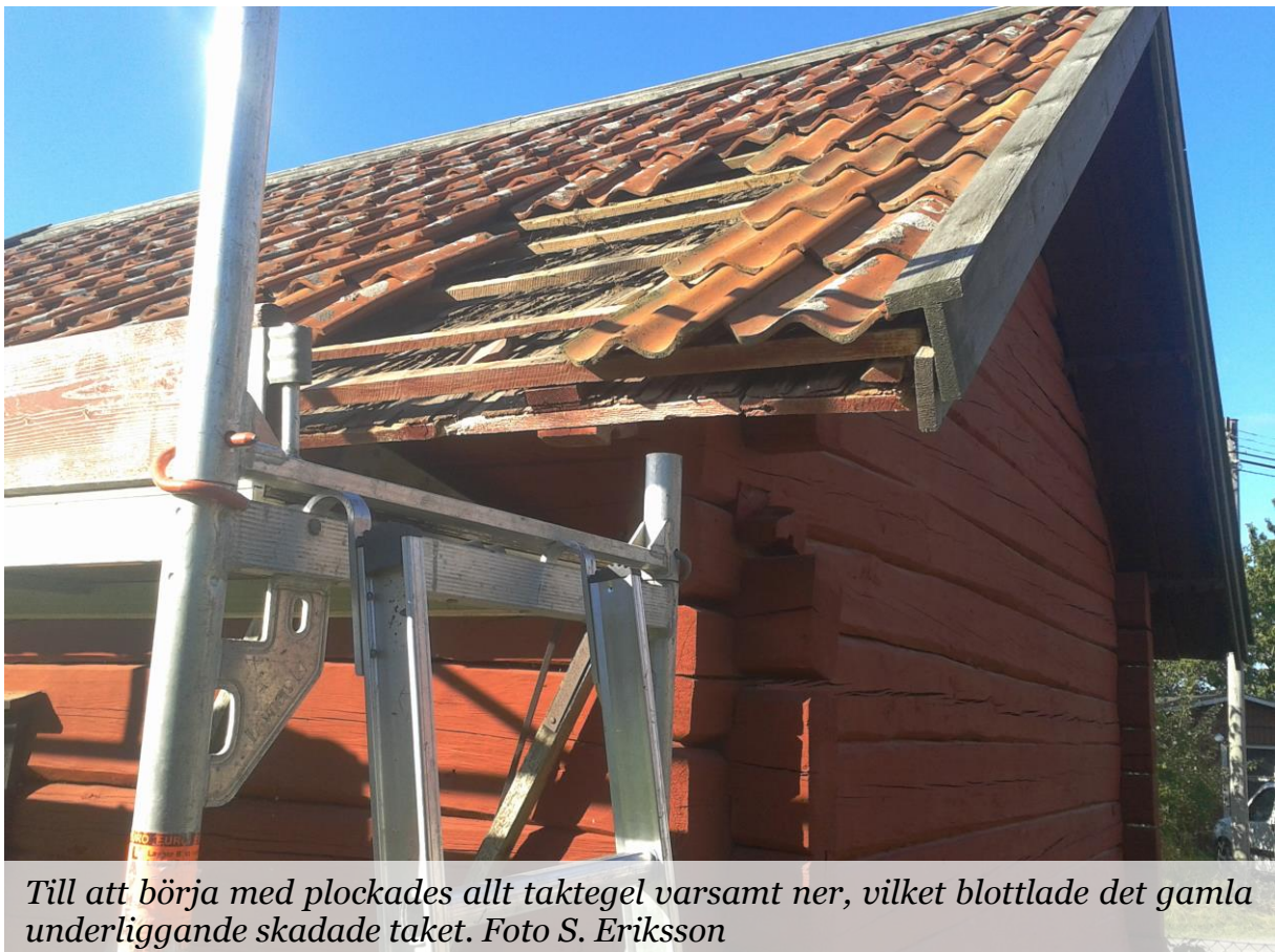
LP_2016_00073. Före omläggningen av taket fanns ett mellanrum mellan vattbrädan/vindskivan och takfallet/takteglet mot nordväst respektive sydost. Det västra takfallet var också aningen buktande. I bild syns det västra takfallet.
