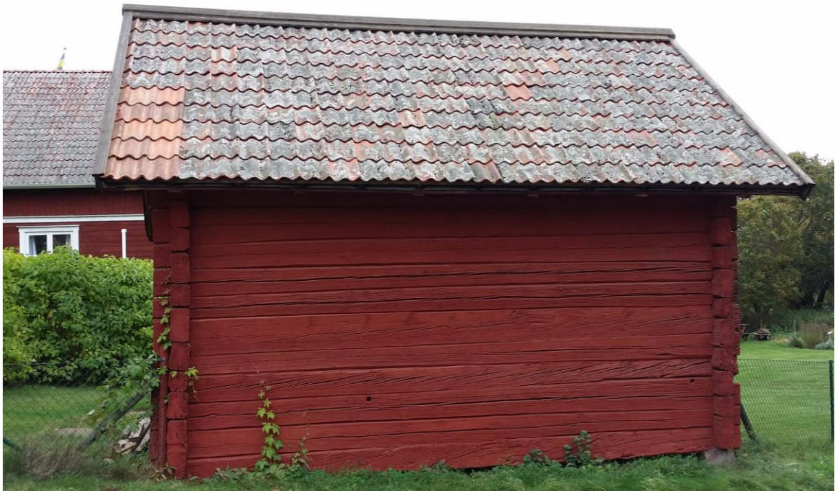
Slutligt resultat. Hembygds museet sett från västsidan. De lite avvikande pannorna ligger i en klunga mot norr. Foto S. Eriksson
