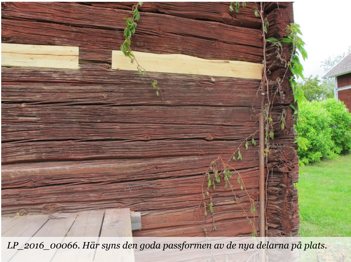
Den nya stocken bearbetades för att få en exakt passform och provades under arbetets gång i urtaget för att slutligen passas och slås in. Foto E. Lagerström
