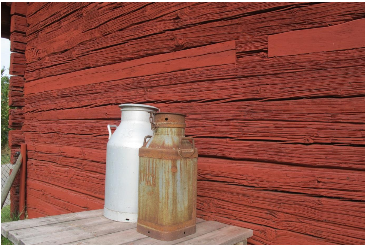
LP_2016_00072. Så småningom kommer den nya stocken att få en mer ådrig karaktär, men redan med ny rödfärg smälte den in mycket väl.
