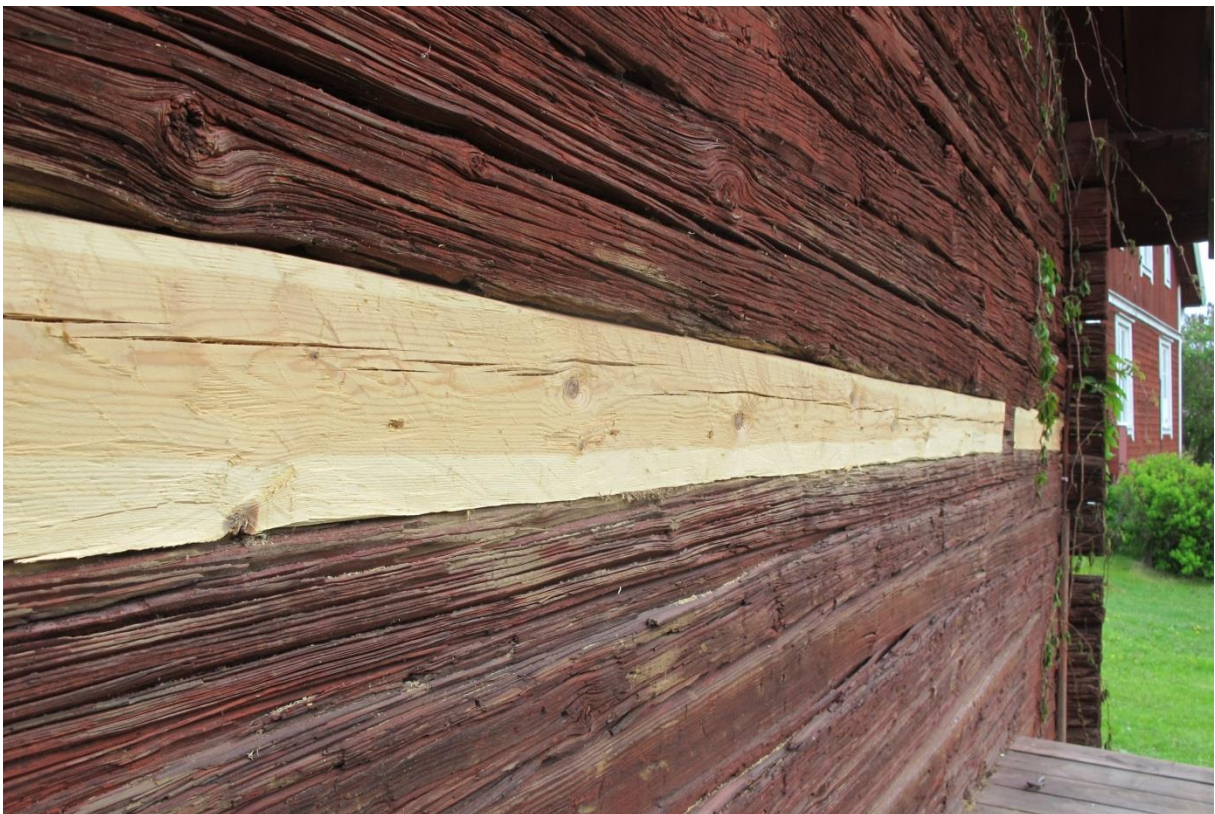
LP_2016_00070. Helhetsintrycket av den nya stocken, sett från väster.
