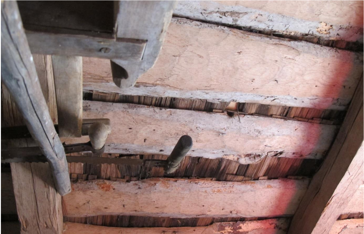
LP_2016_00074. Före takomläggningen föll det ner smuts på inredningen, pga att taket läckte. Spåntäckningen på innertaksbrädorna belades med ny, hel masonit. Här syns taket inifrån efter takomläggningen.
