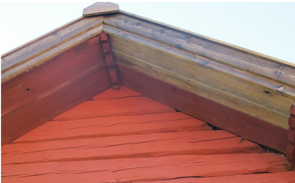
LP_2016_00076. De yttersta brädorna mot nordväst, i takutsprånget i gavelröset, var rötskadade och byttes därför ut mot välliknande. De dubbla vindskivorna nytillverkades och ett nockavslut/ändlock ordnades vid vardera gaveln.
