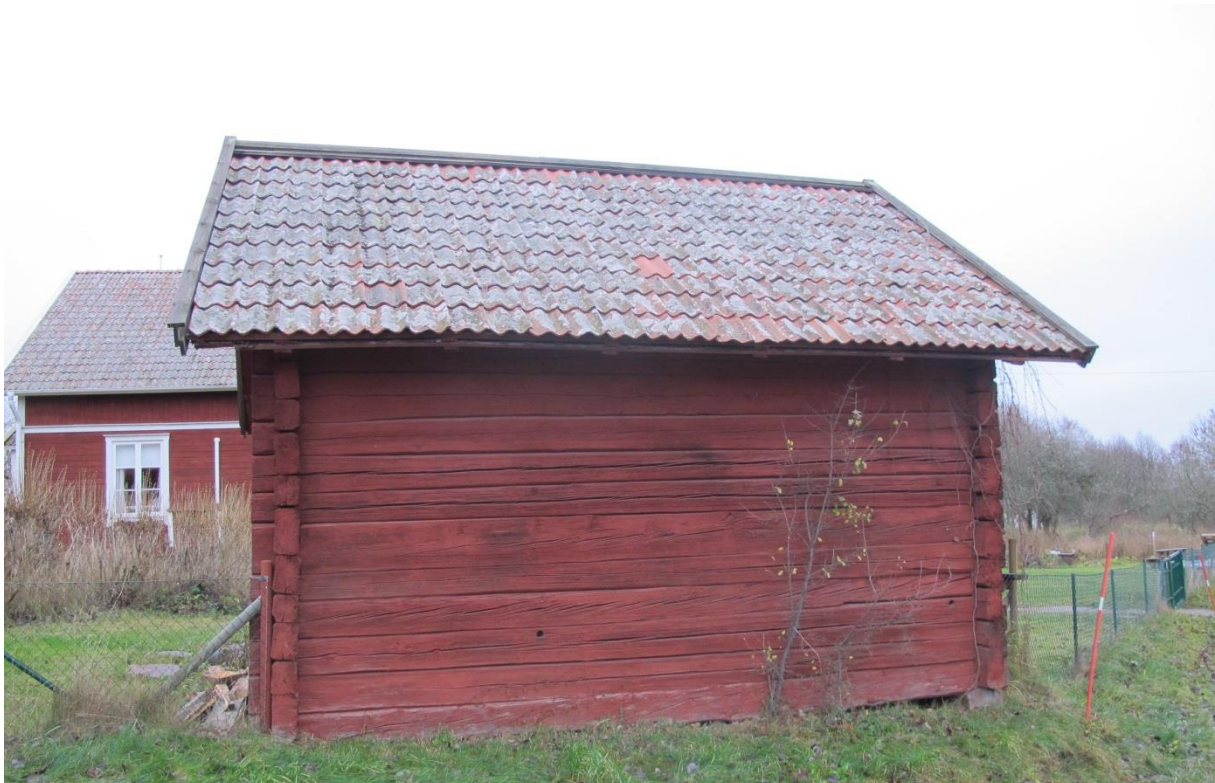
LP_2016_00073. Före omläggningen av taket fanns ett mellanrum mellan vattbrädan/vindskivan och takfallet/takteglet mot nordväst respektive sydost. Det västra takfallet var också aningen buktande. I bild syns det västra takfallet.
