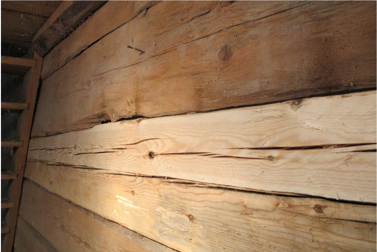
LP_2016_00071. På insida vägg var det ur vissa vinklar knappt synligt att timmerlagningen utförts.
