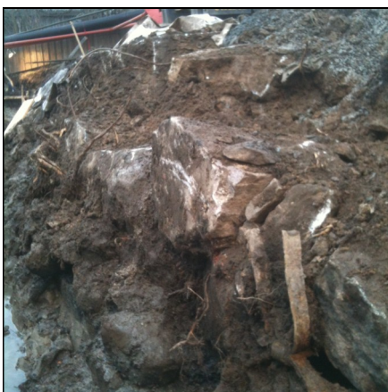
Fig 6. Stenmuren A1. Från öst.
