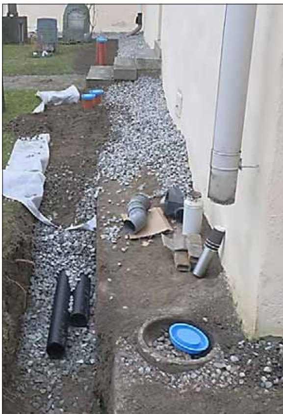
Fig. 9. Bilden visar dubbla dräneringsrör \varnothing 110 mm, lagda ut-med kyrkans södra grundmur. De uppstickande rören i bakgrunden markerar lägen för fyra spolbrunnar som hör till dräneringsledningen. Foto: Lars Andersson.
