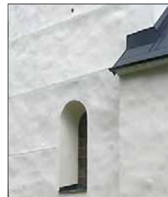
Fig. 4. Kyrkans fasader kalkavfärgades 2007 i ljus ochragul nyans. Foto: Rolf Hammarskiöld
