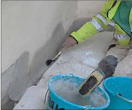
Fig. 13. Pågående putsplåslag den 19 maj 2016. Foto: Rolf Hammarskiöld.
