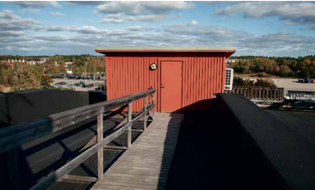
Fig. 21: Uppgång på taket av läktarbyggnaden för att komma till tävlingsledningens bod, ldng 0172.
