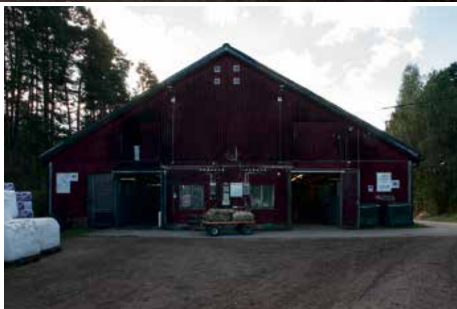
Fig. 31: Nedre bilden. Stall uppfört 1966, Idng 0091.
