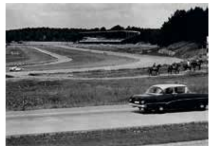
Fig. 3: Här syns anläggningen och läktarbyggnaden från den dåvarande vägen till Norrtälje. Notera att det fortfarande är vänstertrafik vid till fället. Fotograf Einar Andersson.
