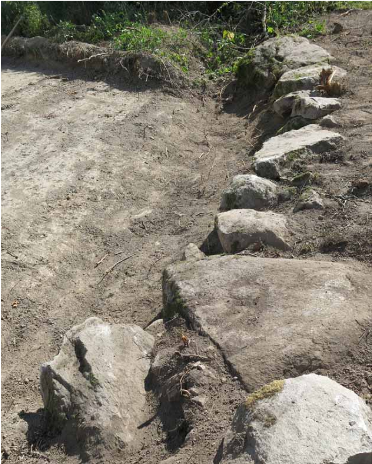
Fig 3. Framrensad stensatt kant på den äldre vägen. Foto från norr.
