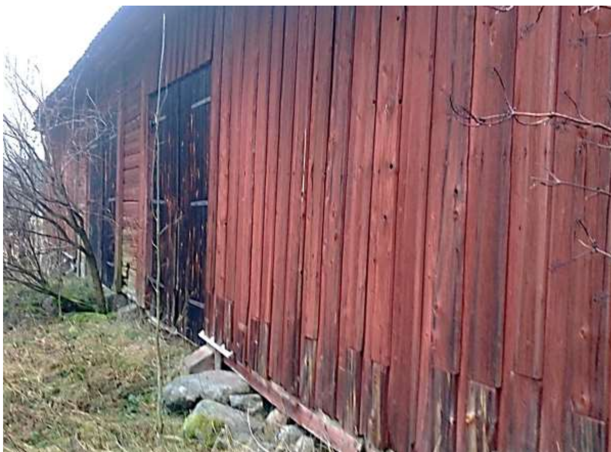
Logens östra långsida är timrad närmast kring ingångarna. Omgivande vägg har stolprest stomme. Foto Rolf Hammarskiöld, Stockholms läns museum
