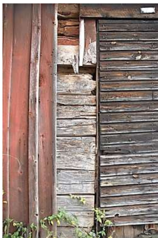
Timret på södra gaveln är delvis skadat, delvis bra. Foto Rolf Hammarskiöld, Stockholms läns museum
