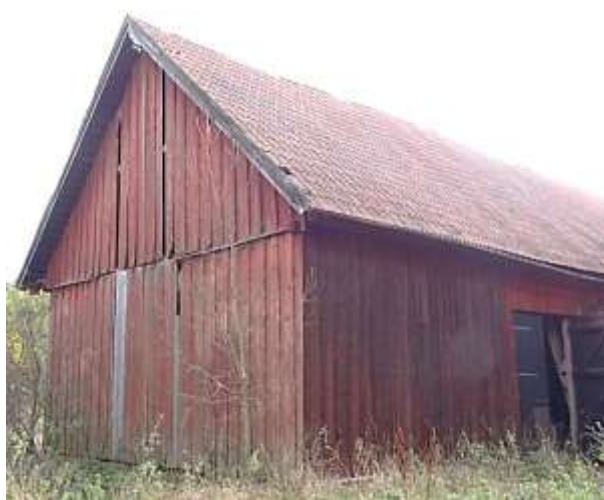
Logen utgör ekonomibyggnadens hela östra länga. På bilden ovan ses norra gaveln och del av västra långsidan, som vetter in mot ett gårdsrum. Fasaderna består av okantad lockpanel. Vindskivorna är tjärade. Foto Rolf Hammarskiöld, Stockholms läns museum
