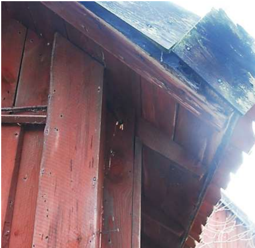
Höns- och svinhusets takfot. Foto Rolf Hammarskiöld, Stockholms läns museum
