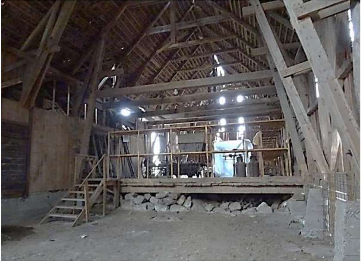
Logens interiör, foto mot norr. Foto Rolf Hammarskiöld, Stockholms läns museum
