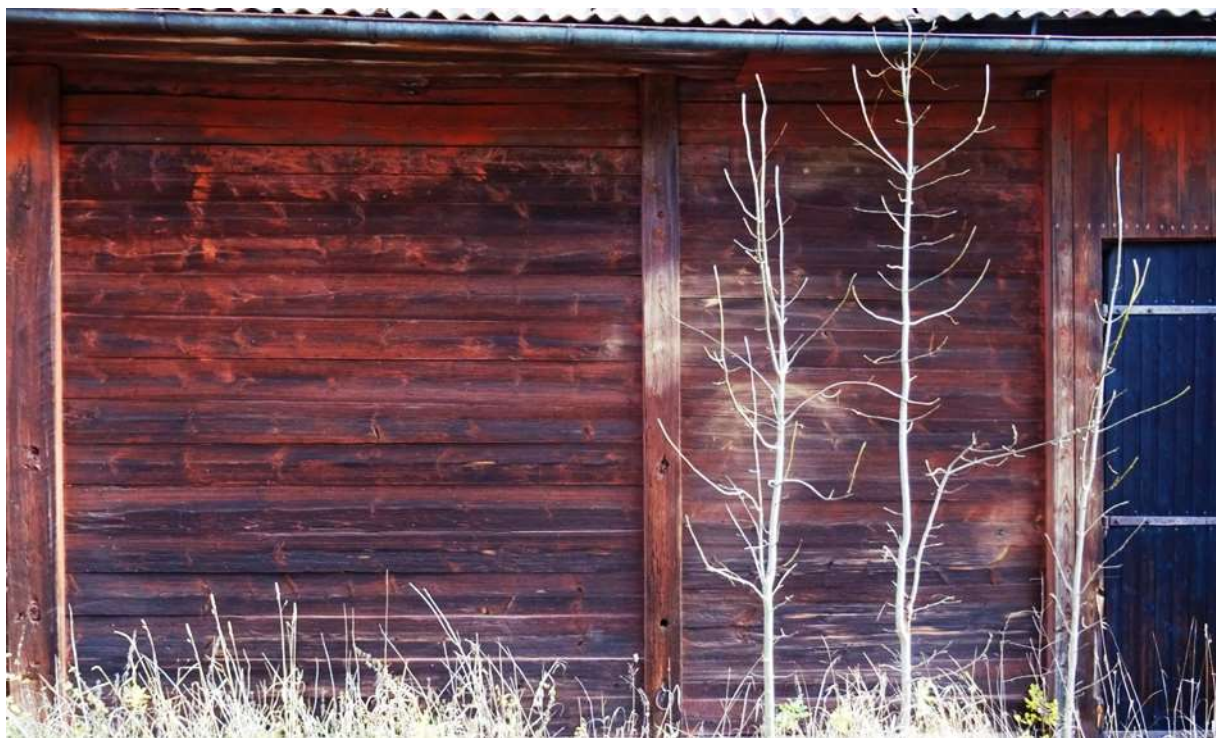
Närbild av spannmålsbodens västra fasad. Foto Johannes Kruusi, KVM forum
