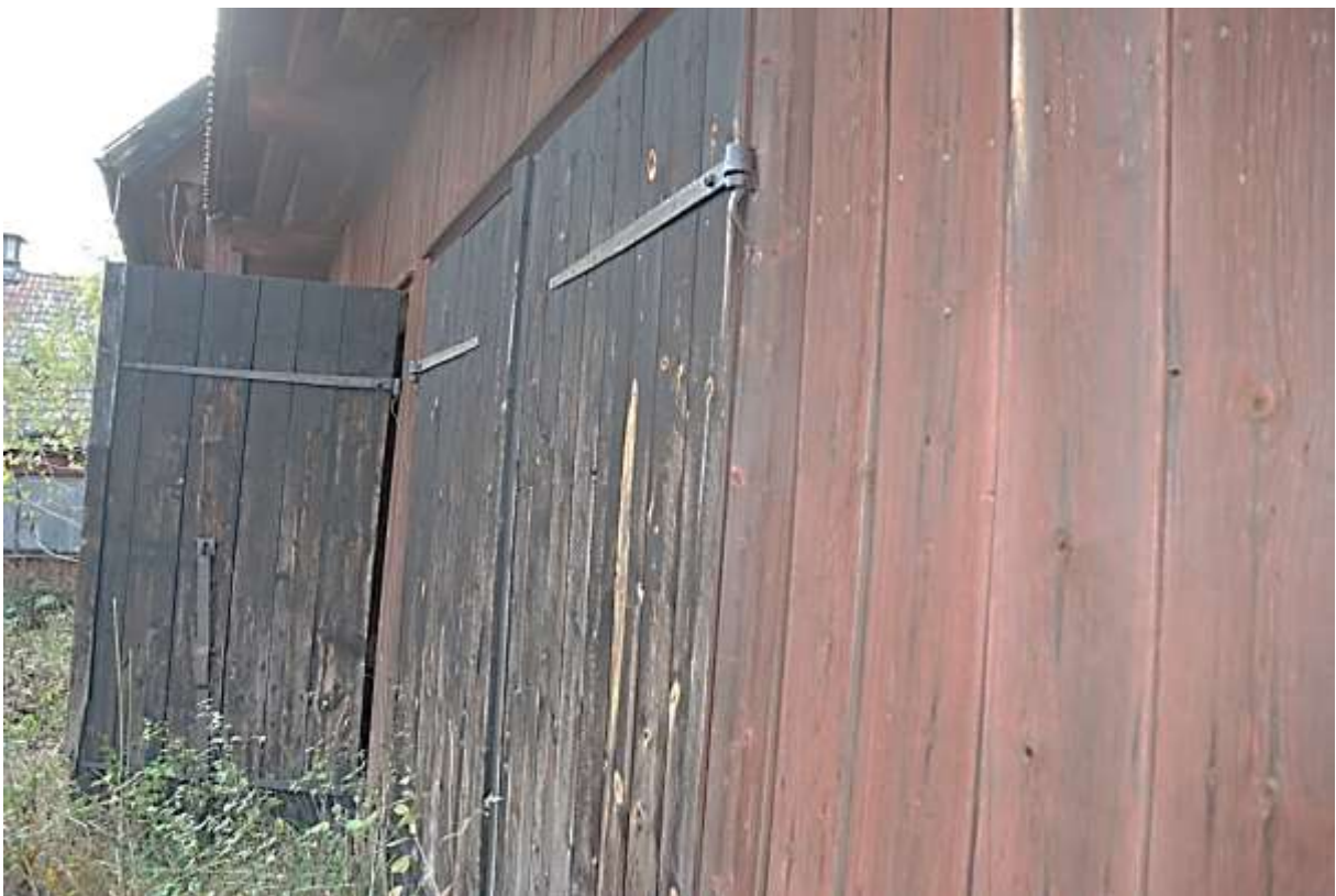
Dörrarna på vagnsbodens östra sida/gårdssidan. Foto Rolf Hammarskiöld, Stockholms läns museum
