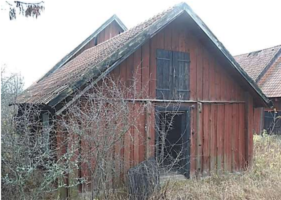
Höns- och svinhusets östra långsida och norra gavel. Foto Rolf Hammarskiöld, Stockholms läns museum
