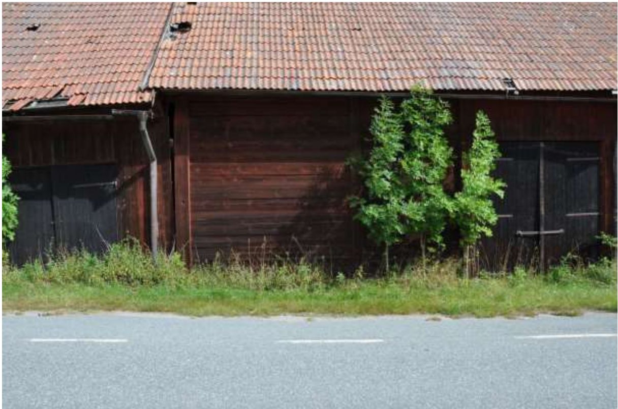
Spannmålsbodens västra fasad vetter mot Lillsvedsvägen. Foto Ingela Andersson, Fortifikationsverket
