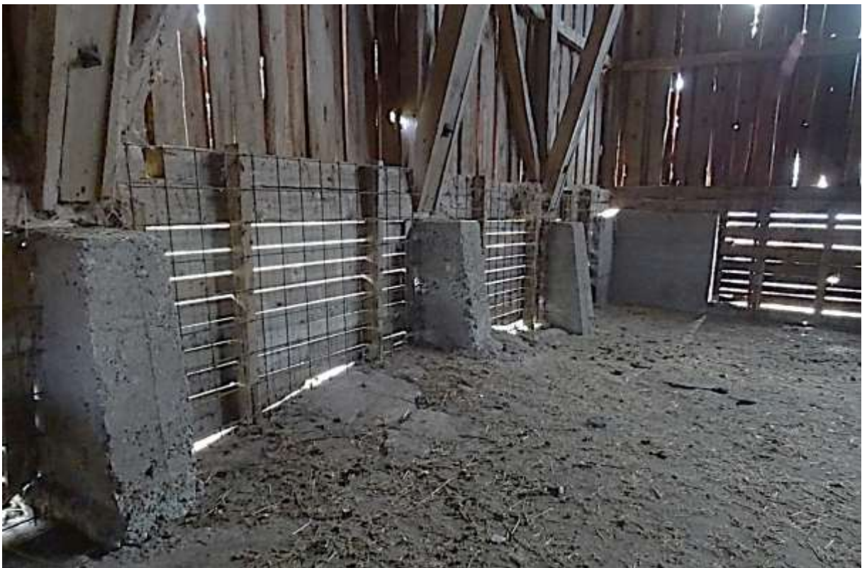
Logens grundläggning i sydost. Foto Rolf Hammarskiöld, Stockholms läns museum
