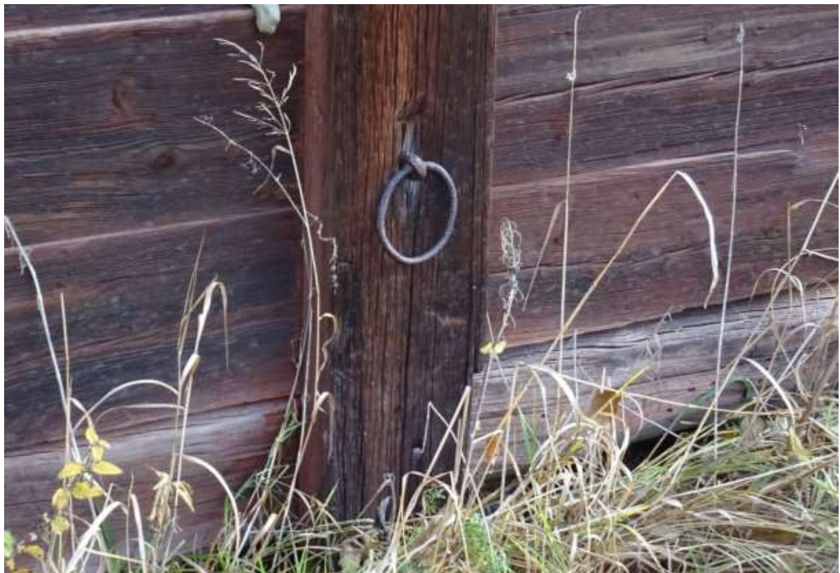
Yttervägg och syllstock på spannmålsbodens västra sida. I förgrunden är en smidd ring för seldon. Foto Johannes Kruusi, KMV forum.
