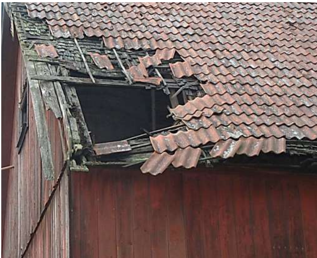
Logens yttertak har rasat in i nordvästra hörnet. Foto Rolf Hammarskiöld, Stockholms läns museum.
