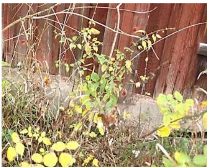
På höns- och svinhusets grundmur har jord vallats upp. Foto Rolf Hammarskiöld, Stockholms läns
