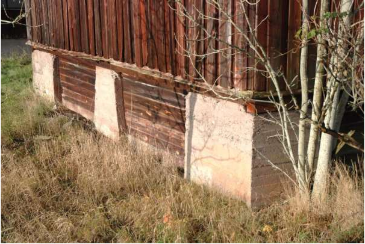
Södra loggavelns grundläggning. Foto Rolf Hammarskiöld, Stockholms läns museum
