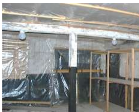
Stallet i sydväst fick tak och väggar inklädda med plast omkring 1980, då mobiliseringsförråd inrättades. Foto Rolf Hammarskiöld, Stockholms läns museum
