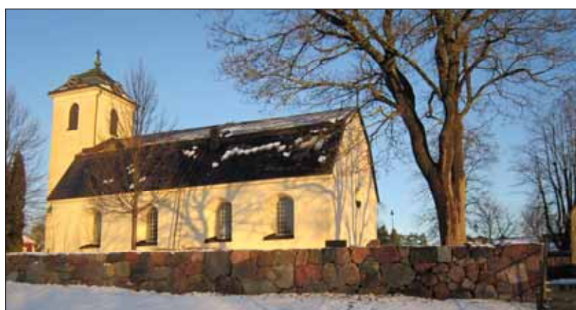
Fig. 13. Kyrkogårdsmuren vid slutbesiktning 2016-12-14.
