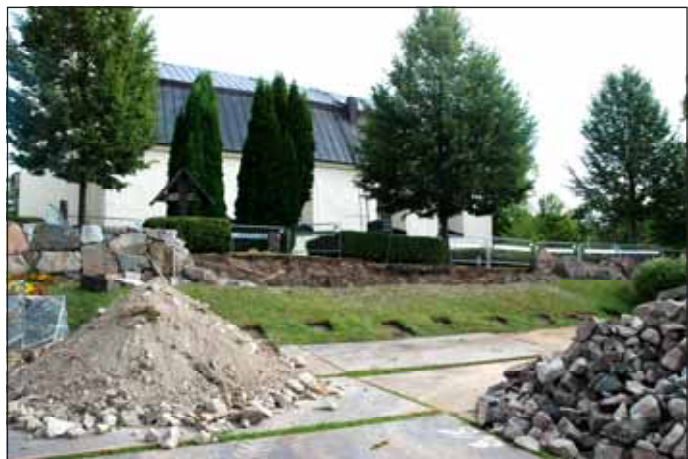
Fig 4. Foto efter byggtidens två första veckor, 2016-08-25.
