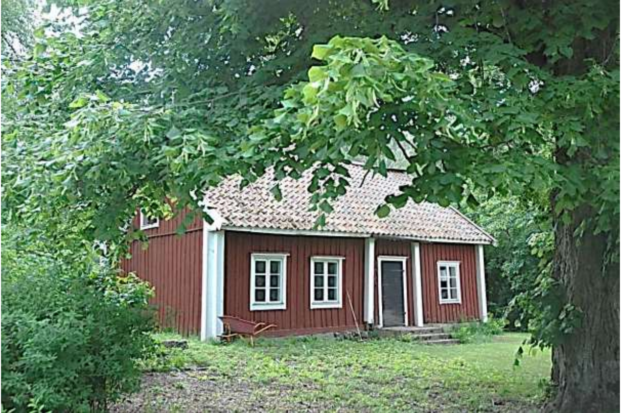
Norränge gårds bagarstuga fotograferades 2016-06-11, vid startmötet inför årets reparationsarbeten.
