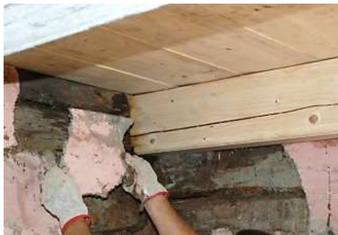
Större stycken med gammal lerklining som lossnat gick att återuppsätta. Fotot togs 2016-09-13.
