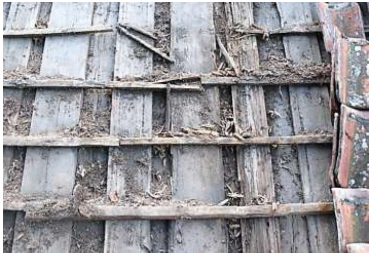
Yttertakets panel, en okantad 1½" lockpanel, var generellt i god kondition. Mitt i norra takfallet förekom dock rötskador.
