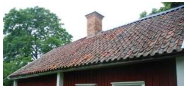
Södra takfallet omlades sommaren 2014.
