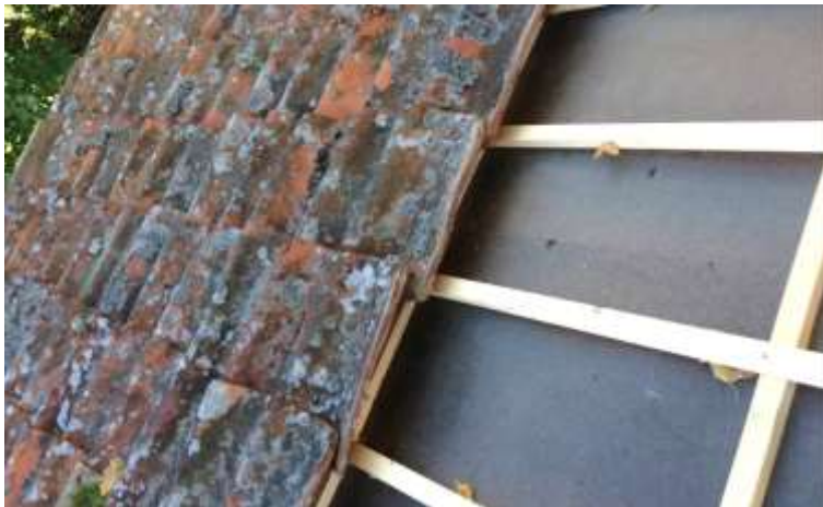
Yttertakets panel, en okantad 1½" lockpanel, var generellt i god kondition. Mitt i norra takfallet förekom dock rötskador.
