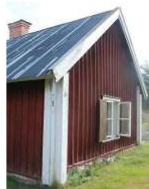
Södra gaveln och sydvästra knuten. Fotot togs 2016-07-28.
