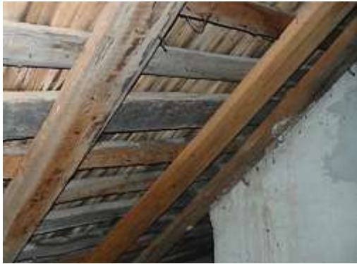
Yttertaket har av glespanel och hyvlade spån, som underlag för den yttre plåttäckningen.
