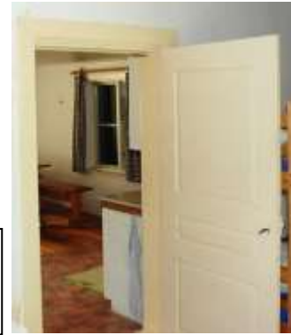
Dörren mellan kammare och kök är sannolikt ursprunglig. Fotot togs 2016-07-28
