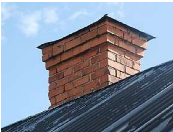
Skorstenen är murad med stortegel och utkragad.
