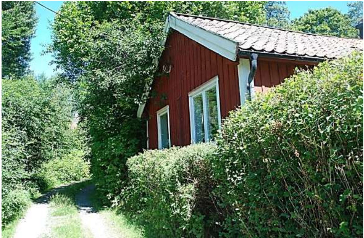
Tätt intill manbyggnadens västra gavel passerar Skvaltkvarnsbacken, tidigare en del av landsvägen som förband Stockholm med Bergslagen. Fotot togs 2016-07-07.
