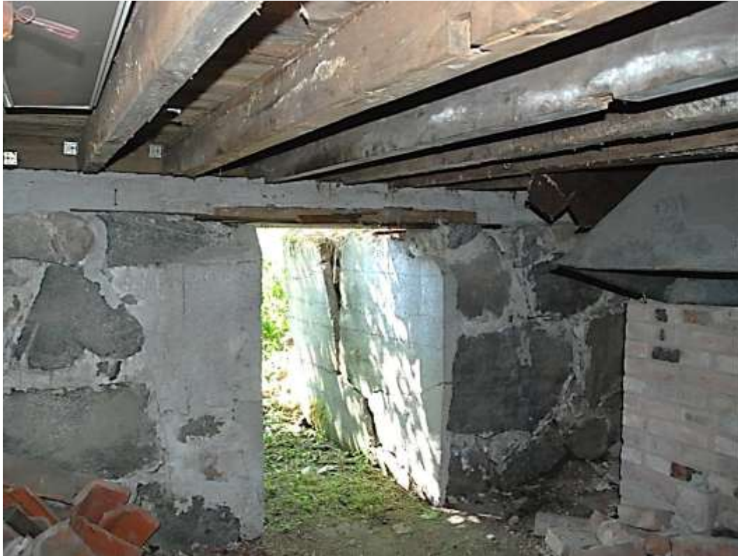
Källaren har mer än metertjocka murar av gråsten. Foto togs 2016-07-05
