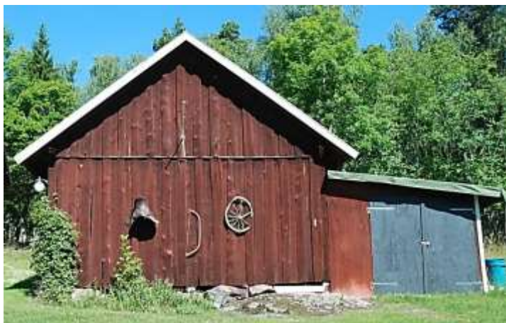
Vagnslidrets södra gavel 2016-07-06
