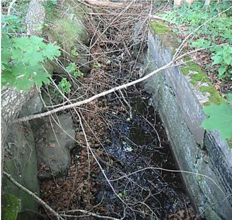
Betonggjuten kanalränna i Aspvik 2016-07-05
