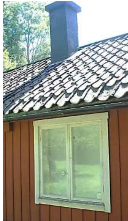
Del av manbyggnadens norra sida 2016-07-06
