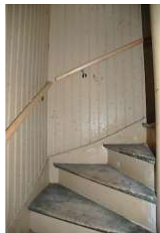
Trappan till övervåningen
