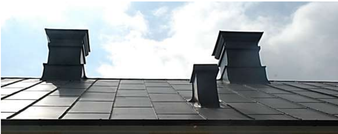
Stationshusets norra takfall, fotograferat 2016-07-28.
