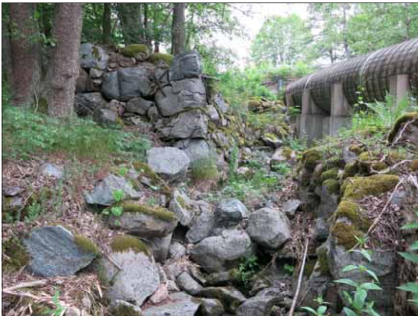
Fig 6. Mur A327 var sammanbyggd med vattenrännan. Foto från syd-ost. (LP201700001)
