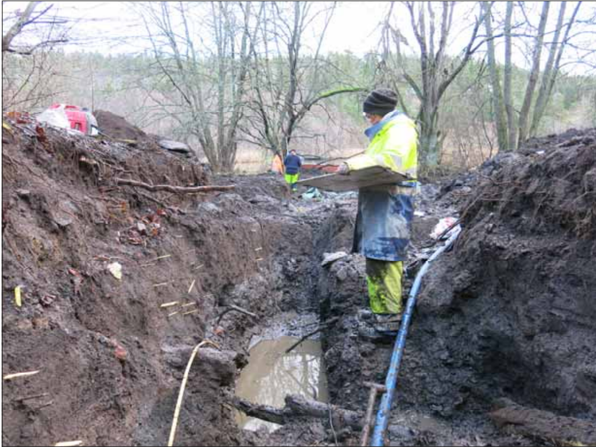
Fig. 29. Sektionsritning av den norra schaktväggen. Foto från väster. (LP201700012)
