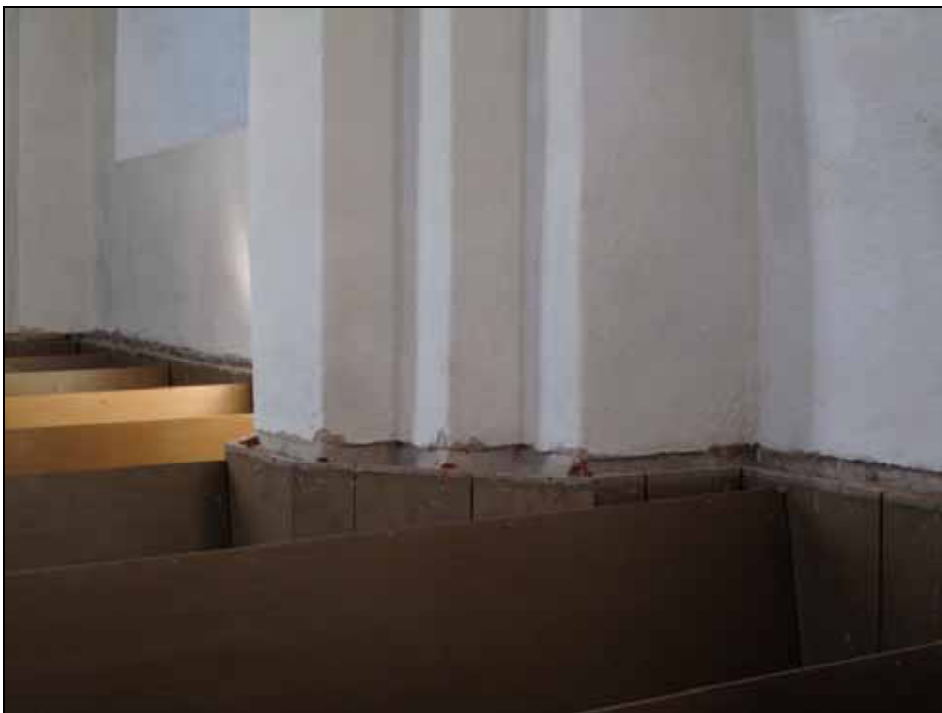
Elledningar lades dolda bakom väggens bröstning. Foto: Cecilia Pantzar.
