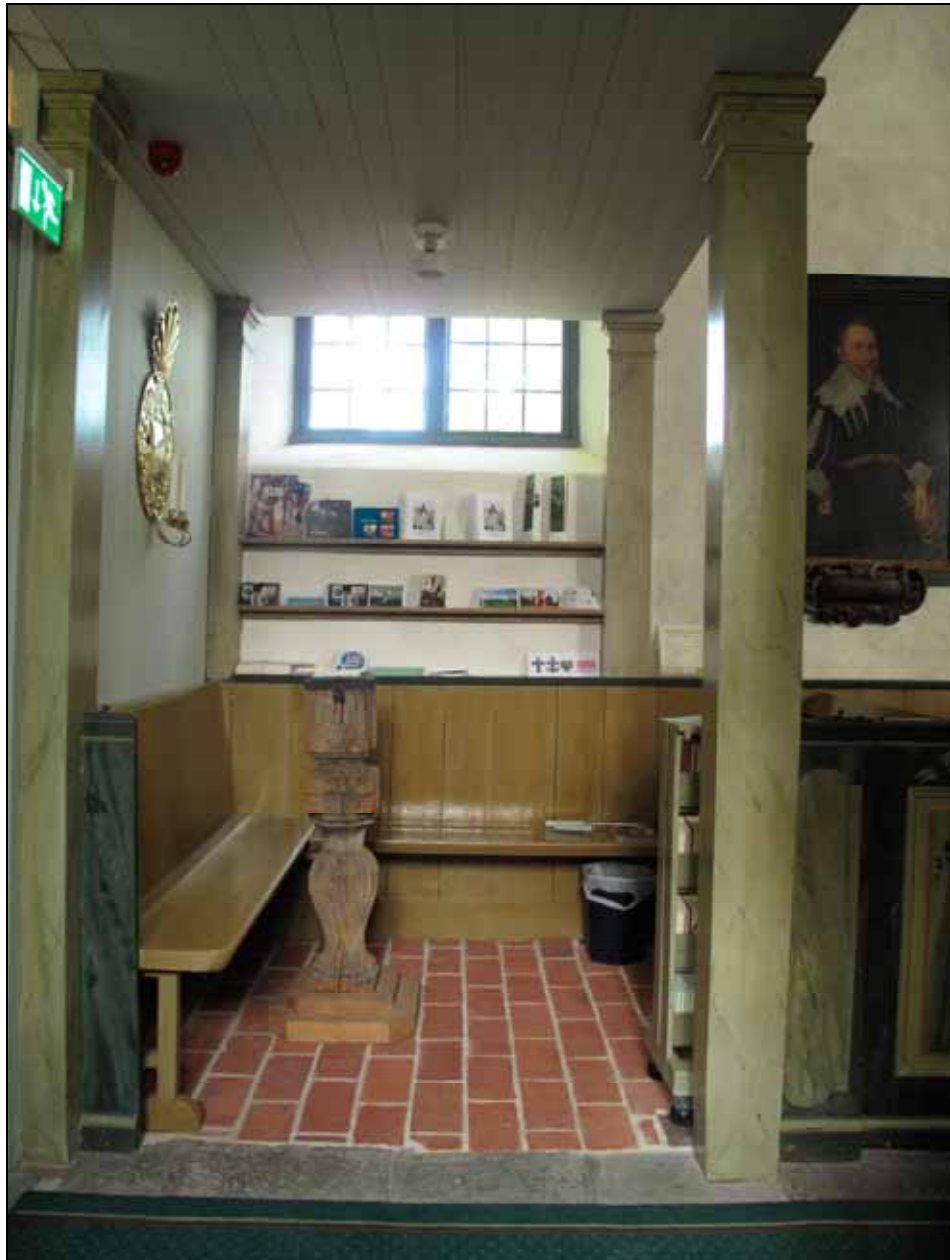
Långhusets norra bänkkvarter där de bakre bänkraderna tog bort. Nytt tegelgolv lades och bänkar byggdes. Foto: Lisa Sundström.
