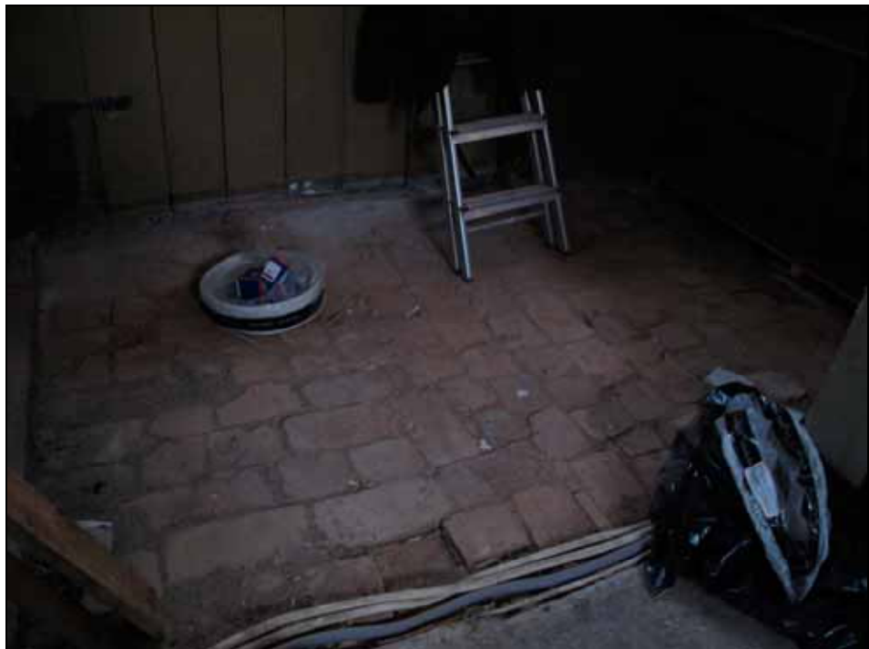
Äldre tegelgolv som tidigare var dolt under bänkkvarterets trägolv. Ersattes med nytt tegelgolv. Vy under läktarens norra sida. Foto: Cecilia Pantzar.
