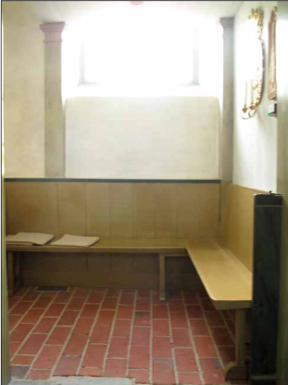
Långhusets södra bänkkvarter där de bakre bänkraderna tog bort. Nytt tegelgolv lades och bänkar byggdes. Foto: Lisa Sundström.
