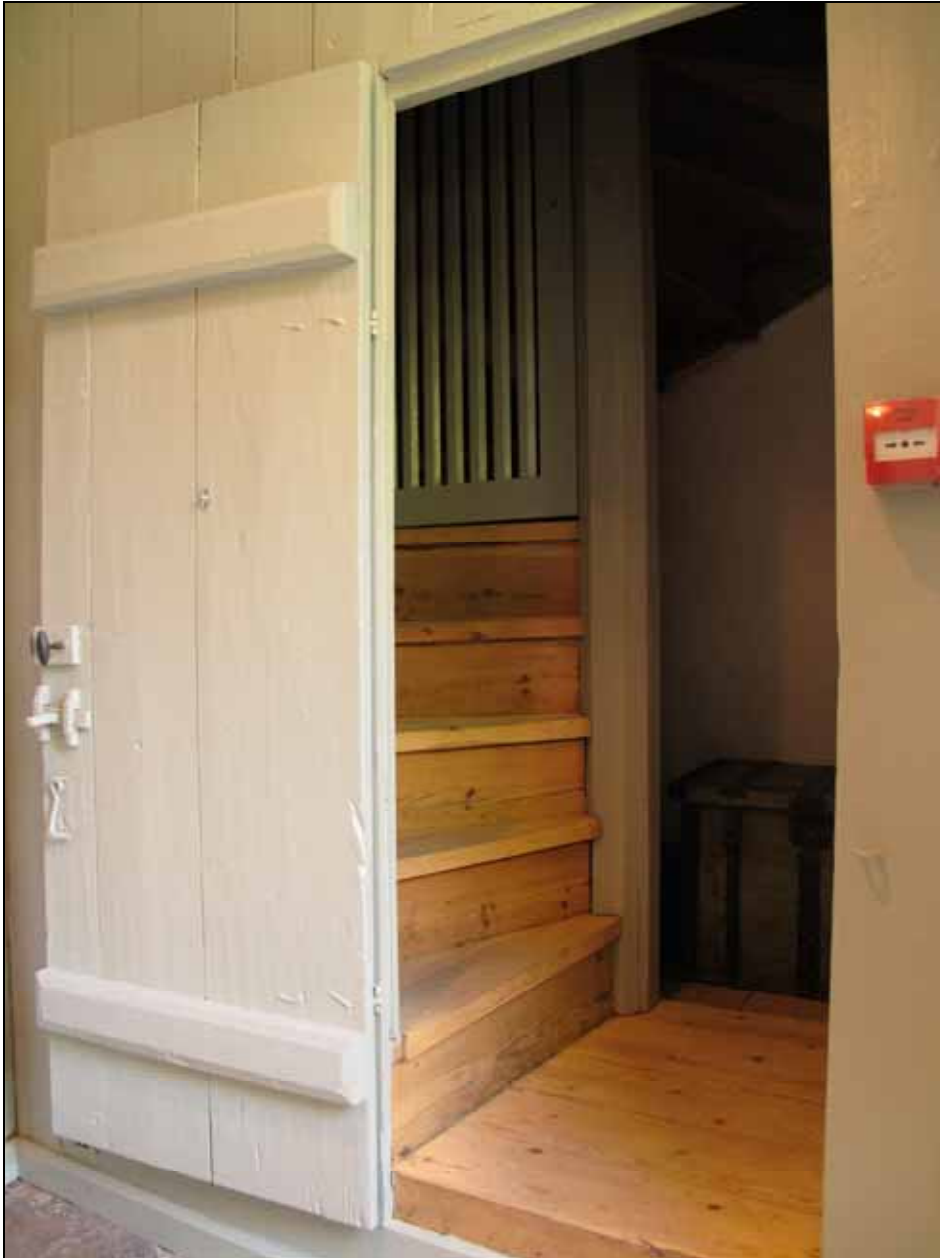
I vapenhuset ordnades dörren till läktaren i permanent uppställt läge. Grind tillverkades till trappan samt stegen slipades. Foto: Lisa Sundström.
