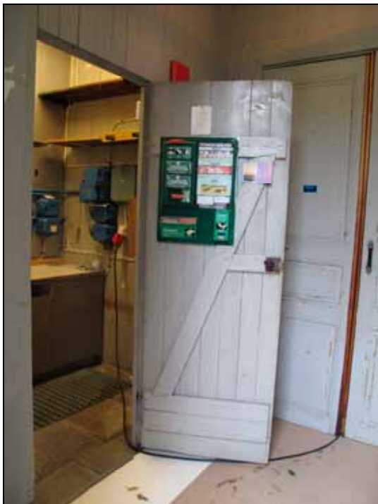
Tornets bottenvåning mot norr med utrymme för el och vaktmästeri före renovering. Foto: Cecilia Pantzar.
