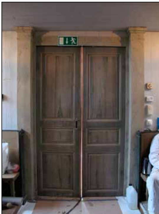
Pardörr mellan kyrkorum och tornets bottenvåning före renovering. Foto: Cecilia Pantzar.
