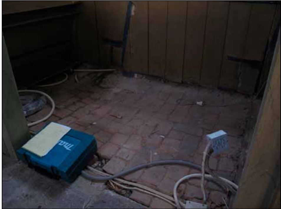
Äldre tegelgolv som tidigare var dolt under bänkkvarterets trägolv. Ersattes med nytt tegelgolv. Vy under läktarens södra sida. Foto: Cecilia Pantzar.
