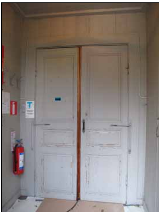
Pardörr från tornets bottenvåning till kyrkorummet före renovering. Foto: Cecilia Pantzar.
