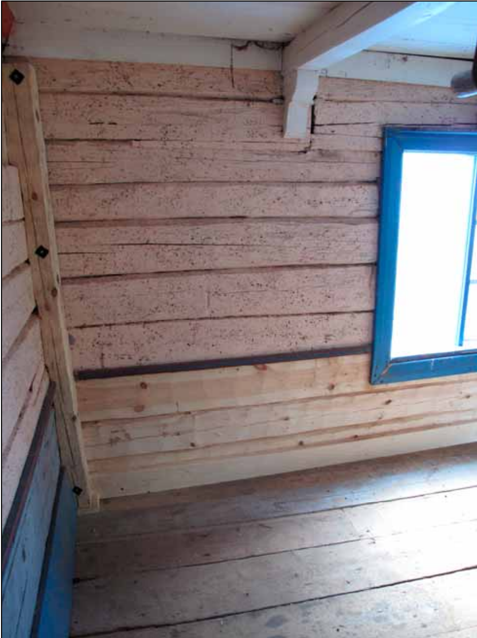
Följaren i det östra hörnet samt de tre nya varven på gårdssidan inifrån kammaren. Lp20111006.
