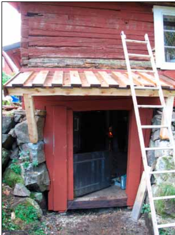
Det nya skärmtaket med falor samt ny tröskel och stolpe. Lp20111008.
