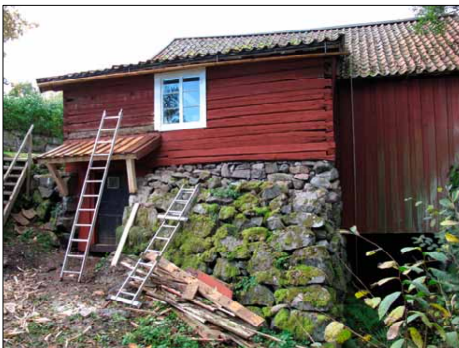
Grundmuren efter komplettering med ny sten. Lp20111005.
