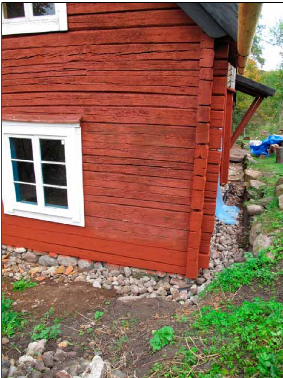
Sydvästra gaveln efter lagning av timmerstommen samt med betongrännan bortbilad. Lp20111004.
