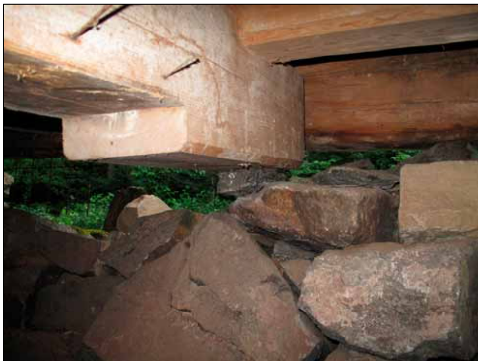
Bärlina på grundmuren invändigt innan komplettering. Lp20110999.
