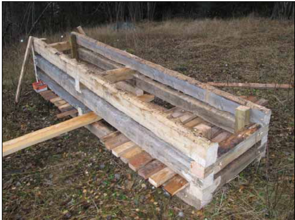
Ny stenkista under tillverkning. Foto: Niss Maria Legars, Stockholms läns museum, bildnr: lp20100137.
