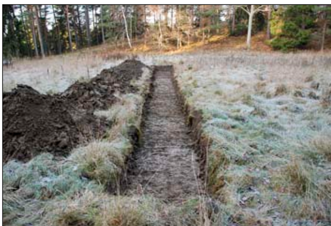
Fig 6. Schakt nr 1 vid objekt nr 8. Foto C. Petersson, Lp nr 20111391.
