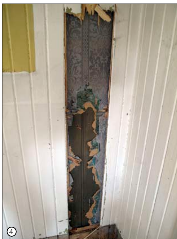
1: 1800-tals fönsterhakar i Enkelstugan/Torpet. Foto H Bellberg, bildnr LP201200064. 2: Fönsterhakar från 1900-talets början mot mittposten i gavelfönster på vinden i Enkelstugan/Torpet Foto H Bellberg, bildnr LP201200065. 3: Enkelstugan/Torpet sett från nordväst. Foto H Bellberg, bildnr LP201200067. 4: Bakomliggande breda pärlspånt i Enkelstugan/Torpet var vanlig på 1850-1860-tal. Foto H Bellberg, bildnr LP201200066.
