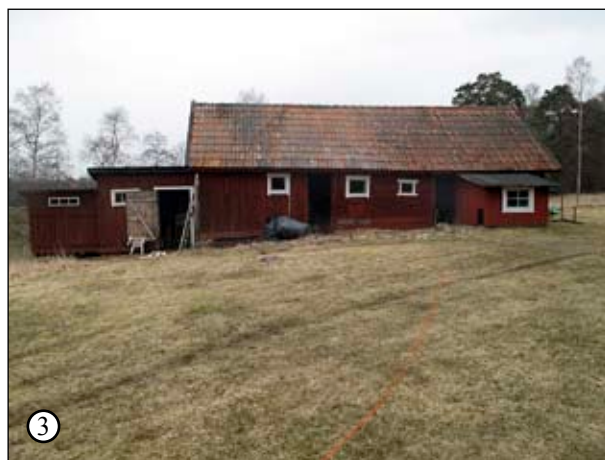
1: Handsmidda bandgångjärn på dörr på Stallängans sydsida. Foto H Bellberg, bildnr LP201200058. 2: Synligt dragjärn mot norr i bjälklag mot vinden i Stallängan. Foto H Bellberg, bildnr LP201200059. 3: Stallängan sedd från söder. Foto H Bellberg, bildnr LP201200060.
