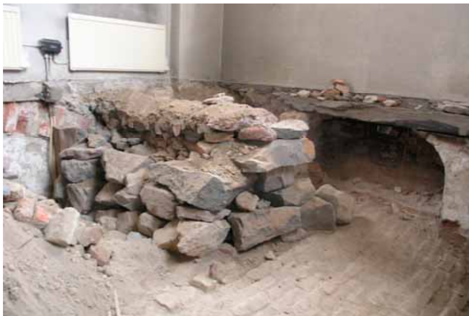
Sydöstra hörnet före nedplockning med en yttre löst travad kallmur och en inre tegelmur som var sekundär i förhållande till tunnvalvet. Lp 20110242.
