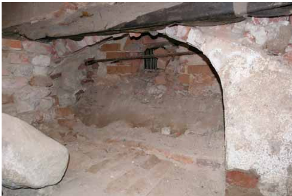
Södra murens omfattning som tolkats vara samtida med det kryssvälvda gravkoret. Till höger syns putsad väggyta som följer det rivna valvets rundning. Lp20110211.
