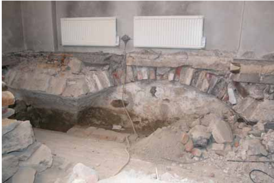
Västväggen med det rivna kryssvalvets sydvästra anfang och den rivna sköldbågen som finns bevarad som en bågformig kontur med stående tegel. Väggytan nedan bågen har bevarade kvastade putsskikt från tiden som gravrum. Lp20110212.
