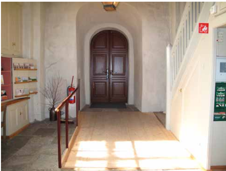
Vapenhusets västra del efter renovering med ny ramp och ny inredning. Lp2011189.
