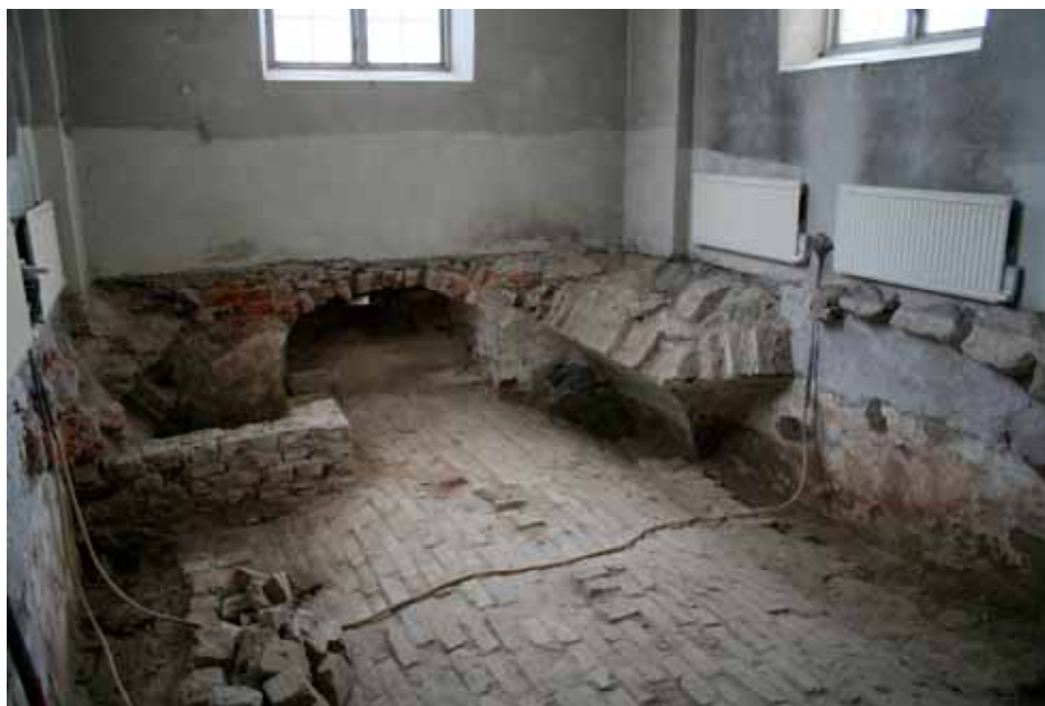
Tunnvalvet löper i nordsydlig riktning. Lp20110201.
