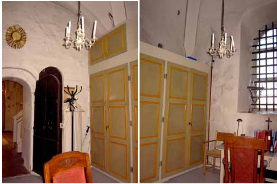
Sakristian före renovering med heltäckningsmatta och skåpinredning utmed västväggen. Lp20110224 och lp20110226.
