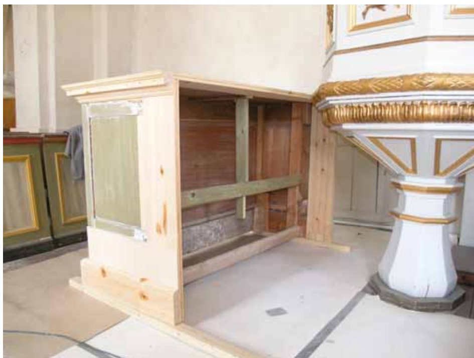
Altaret med ny sockel och utökad bakdel. Även det övre listverket reparerades. Lp 20110220.
