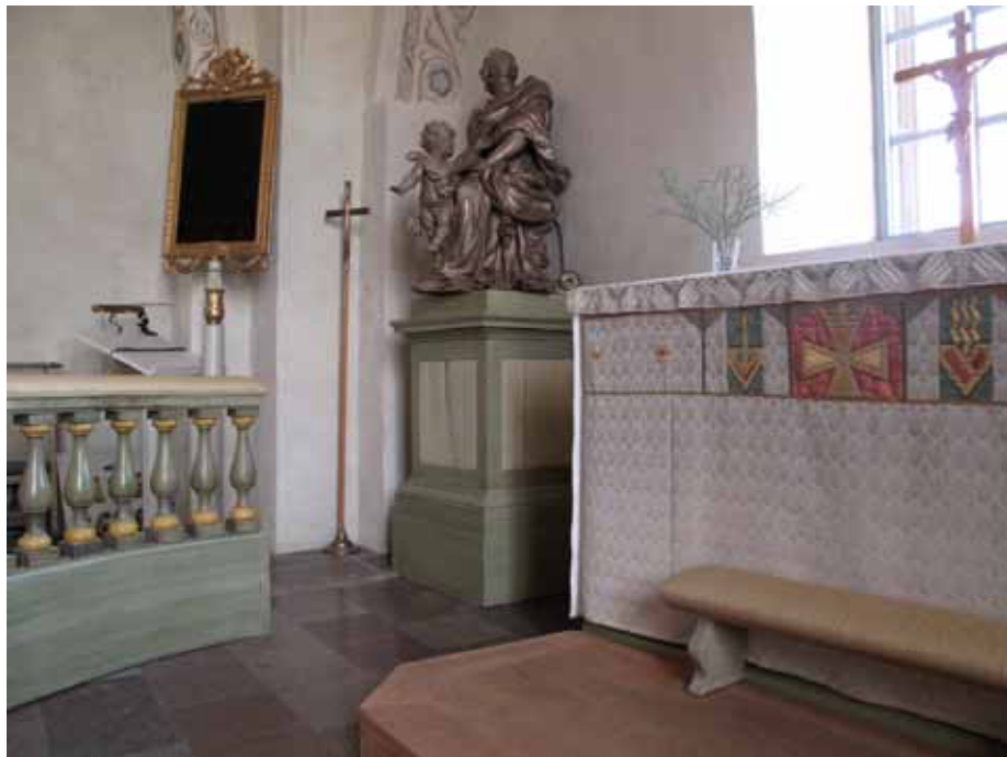
Golvytan bakom altarringen belades med kalksten i varierande fägskala från grå till röd. Ett nytt podium placerades framför altaret. Lp20110181.
