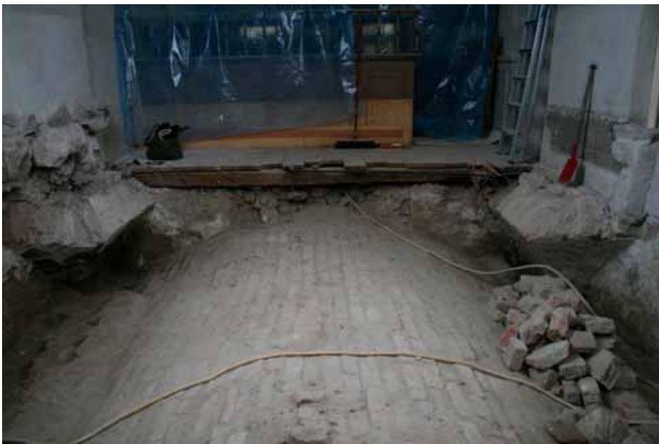
Tunnvalvet från söder. I rummets nordvästra och östra hörn syns två bevarade anfang från det rivna kryssvalvet. Mellan anfangen kan skönjas smygen av en i överdelen nedriven omfattning. Lp20110199.
