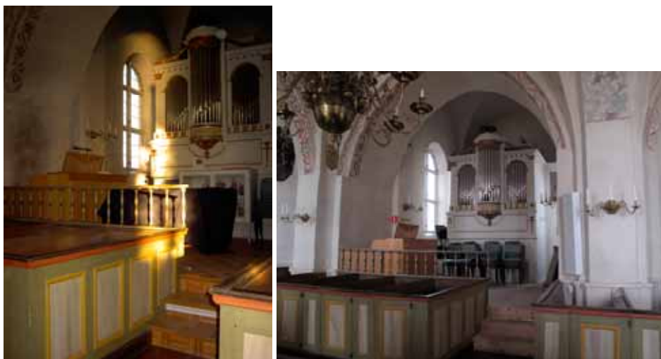
Orgelkoret före och efter renovering. Det nya trägolvet lades ovan befintligt golv. Lp20110232 och lp 20110177.
