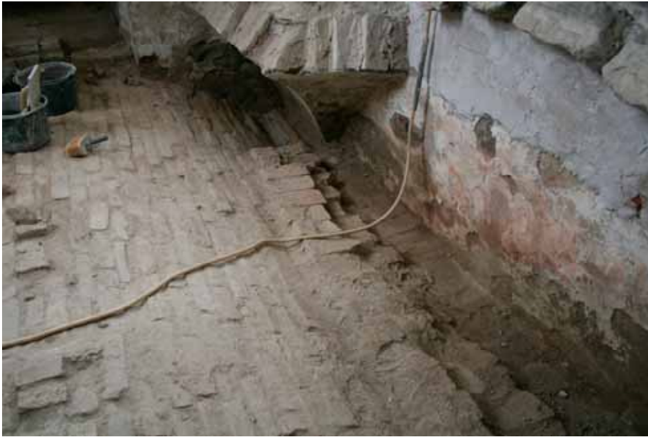
Tunnvalvets anslutning till västvæggen, vy från nordöst. Lp20110204.
