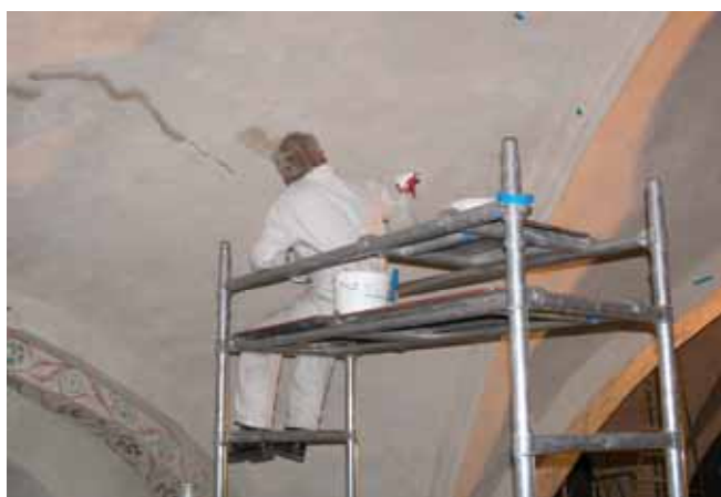
Puttsprickor lagades och tonades in. På bilden arbetar konservator Thomas Wängelin. Lp20110214.
