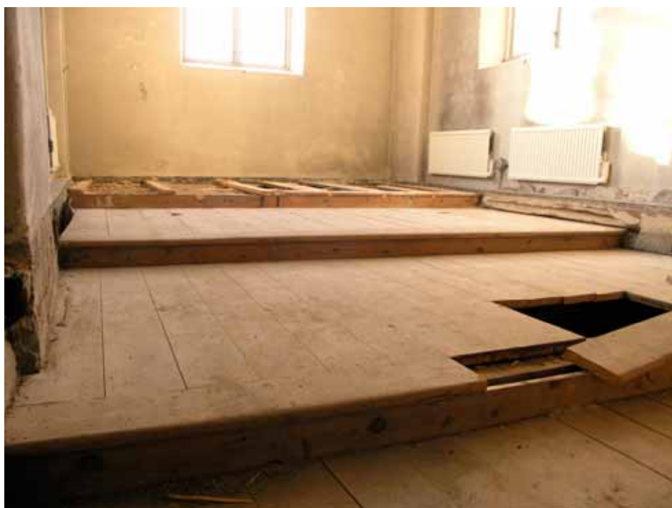
Brädgolvet från 1881 fanns till stor del bevarat under det jämnhöga befintliga trägolvet. Lp20110207.
