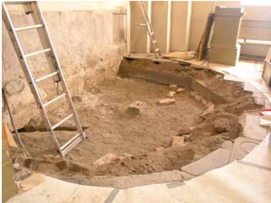
Altarringens trägolv och underliggande regelverk togs bort. Lp20110217.
