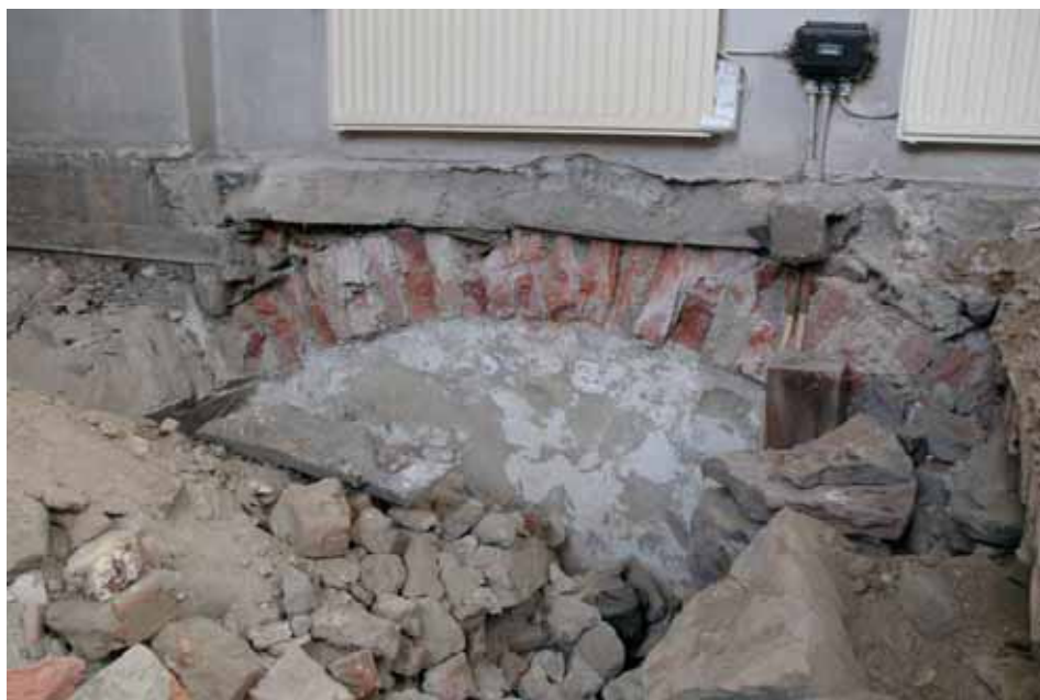
Östväggen med bevarad kontur av kryssvalvets tegelmurade sköldbåge . På väggytan nedan finns bevarade putsskikt från tiden som kryssvälvt gravrum. Lp20110213.
