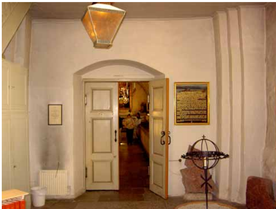
Vapenhusets östra del före renovering. Lp20110136.
