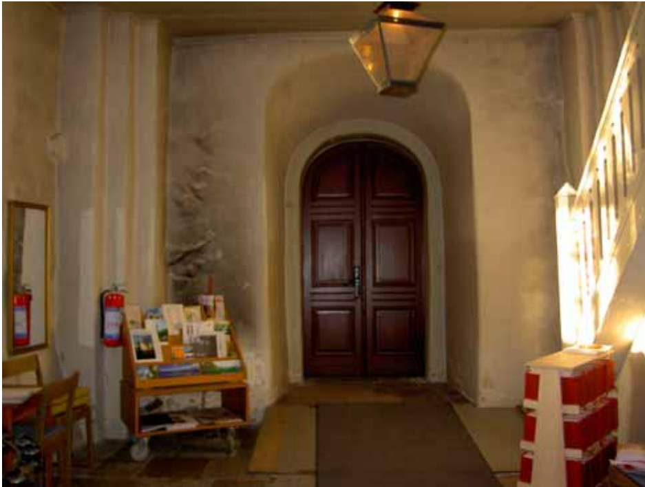
Vapenhusets västra del före renovering. Lp20110235.
