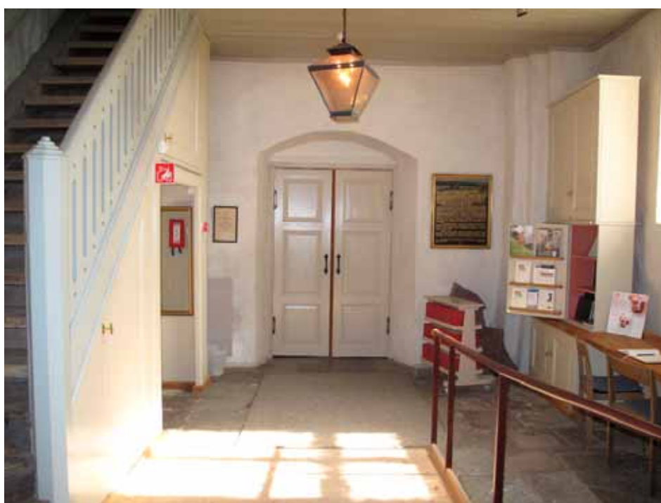
Vapenhusets östra del efter renovering med ny ramp och tillhörande räcke samt ny inredning. Lp20110190.
