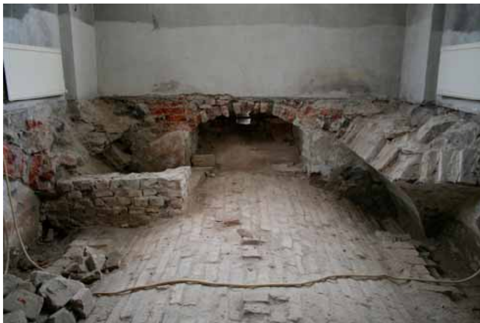
Södra gravkoret med framgrävt tunnvalv. I fonden syns sydmurens igensatta öppning och till höger anfanget efter ett rivet kryssvalv. Till vänster syns ett muravsnitt som troligtvis tillkommit som fundament för det äldsta trägolvet. Lp20110200.
