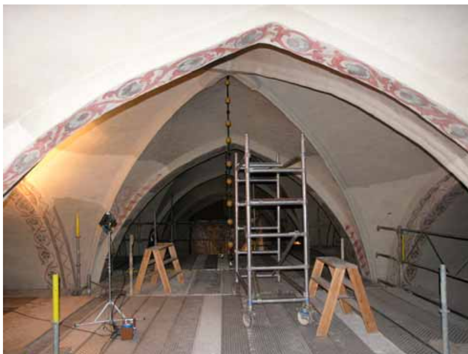
Långhusets mittvalv under rengöring. Rengjorda ytor framträder som ljusare fält. Lp20110206.
