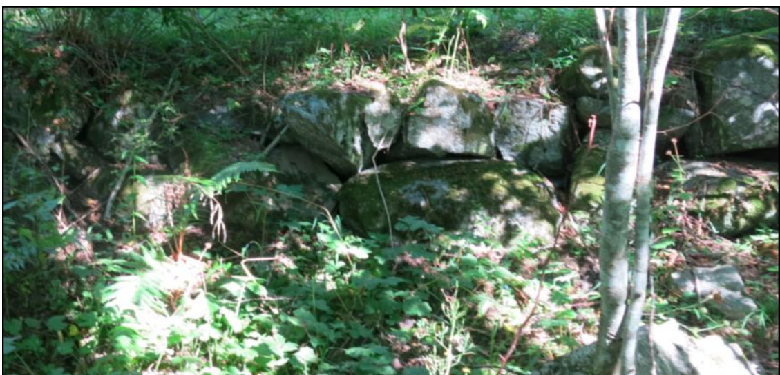
Fig.8. Vägbanken A139. Foto från söder.
