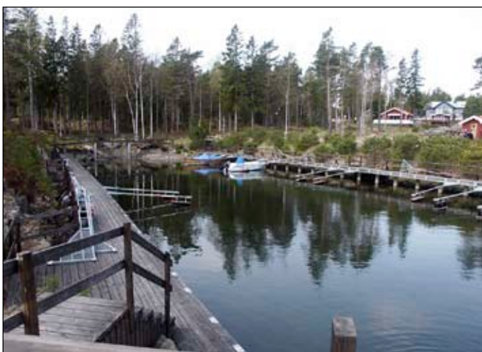
Fig 14. Det moderna Mälby hamn med en framsprängd och muddrad bassäng. Foto: M. Boije.
