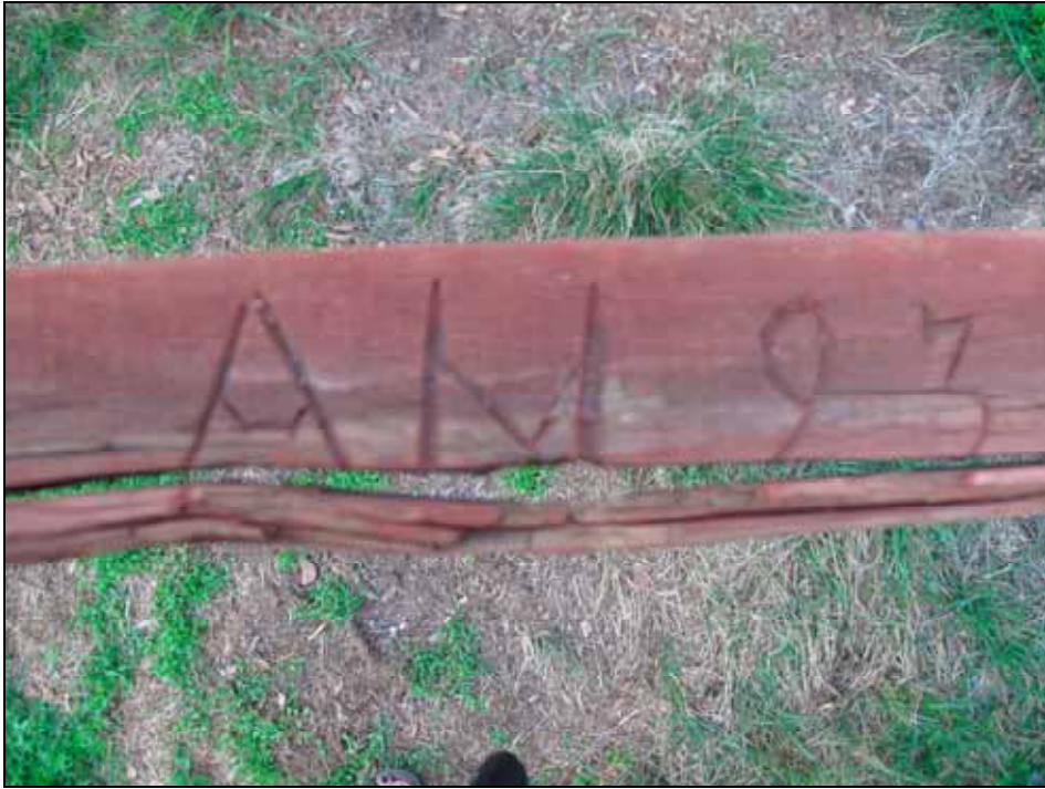
Ett av husets panelbrädor hade inskriptionen AM 93.
