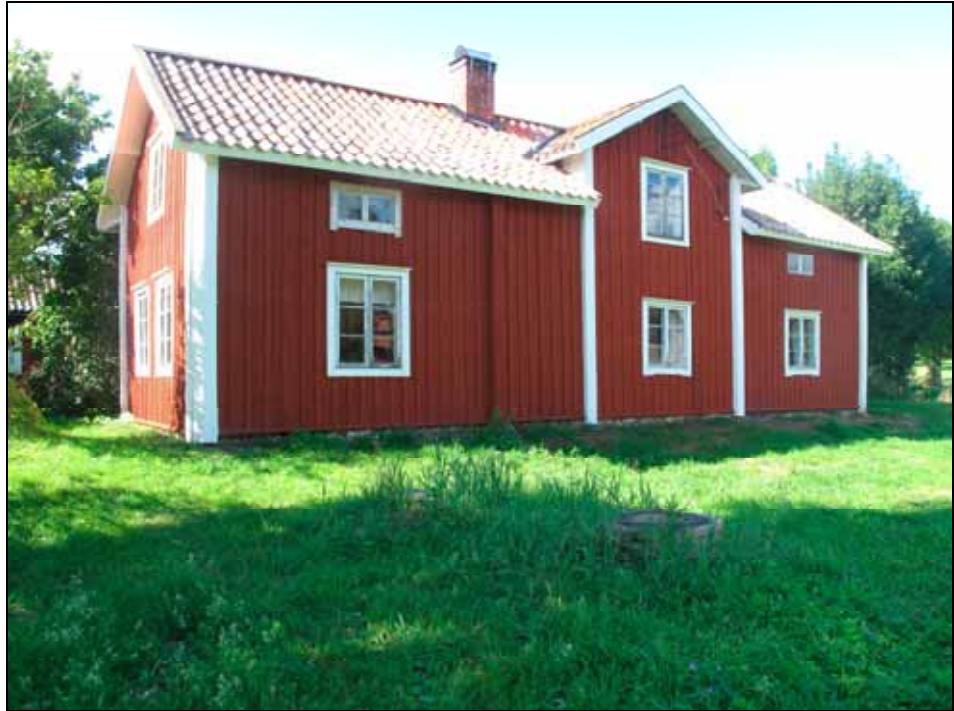
Hagas redargård efter renovering. Fasader åt söder och öster.
