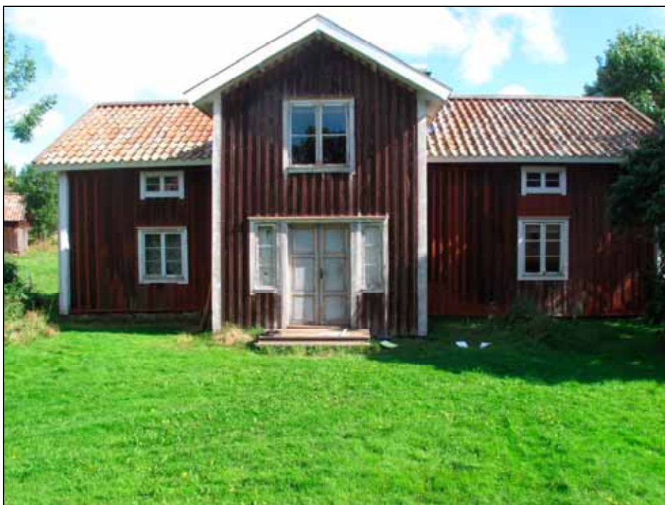
Hagas redargård efter renovering. Fasad åt väst med tillbyggd farstukvist.
