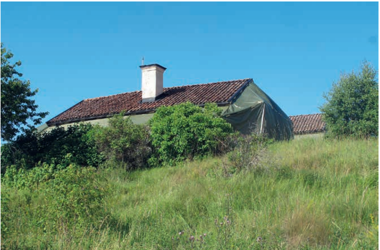
LP 201300560. Stugorna inplastade inför kalkputsningen, foto H. Bellberg 2013
