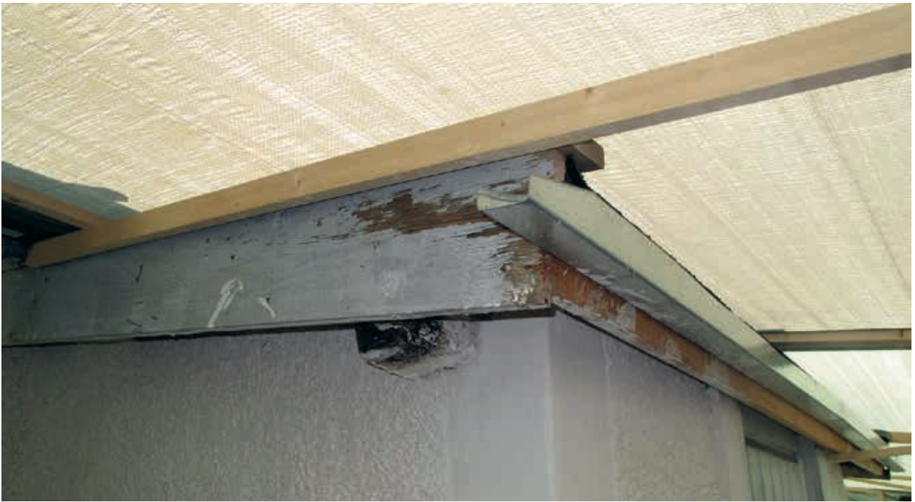
LP 201300561. Förstuga med hänggränna tillverkad 2012, foto H. Bellberg 2013
