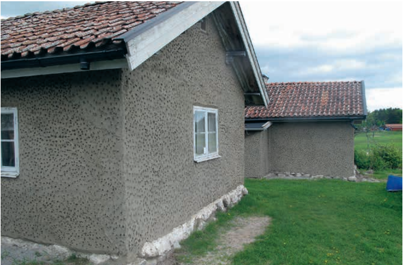
LP 201300559. Stugorna när lerkliningen är utförd, foto H. Bellberg 2013
