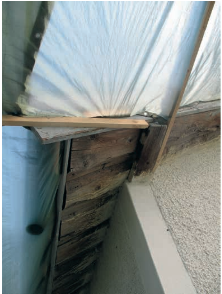
LP 201300568. Kalkspill på råspontsbrädorna efter restaureringen, foto H. Bellberg 2013
