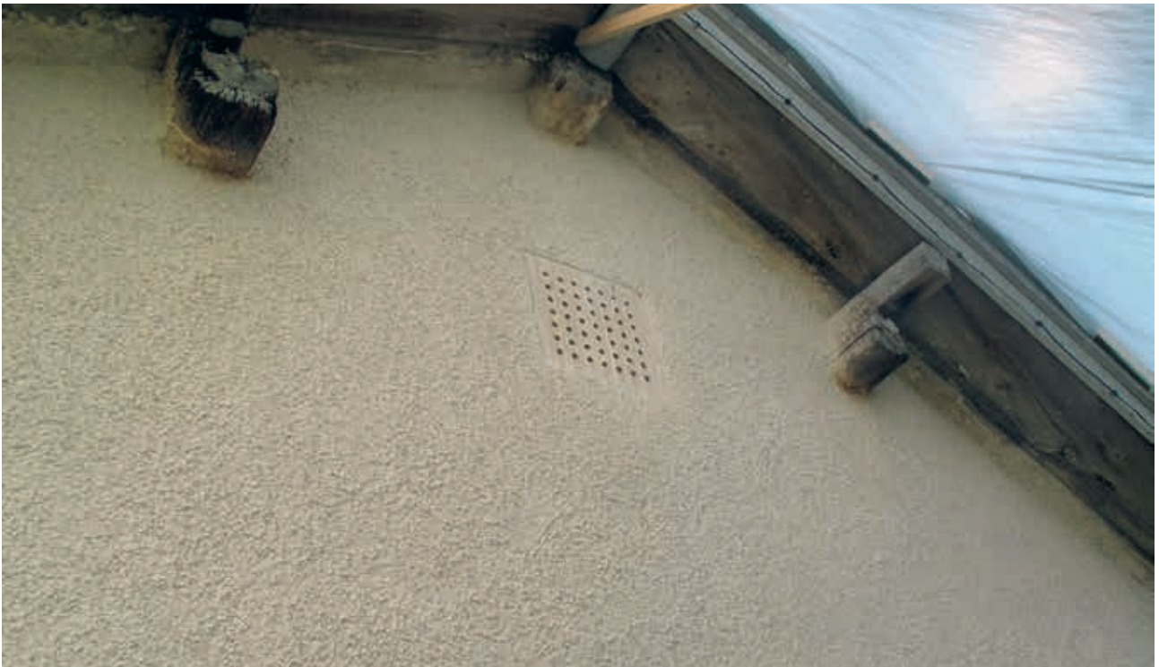
LP 201300565. Nytillverkad träventil, foto H. Bellberg 2013
