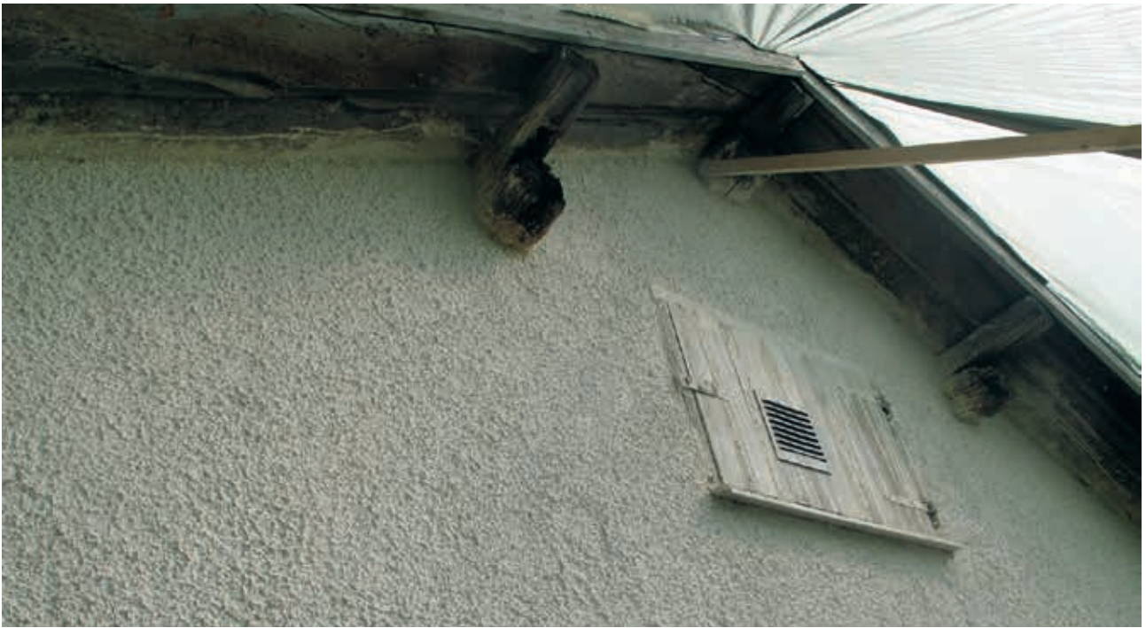
LP 201300562. Den nya spritputsens i mötet med taksprånget, foto H. Bellberg 2013
