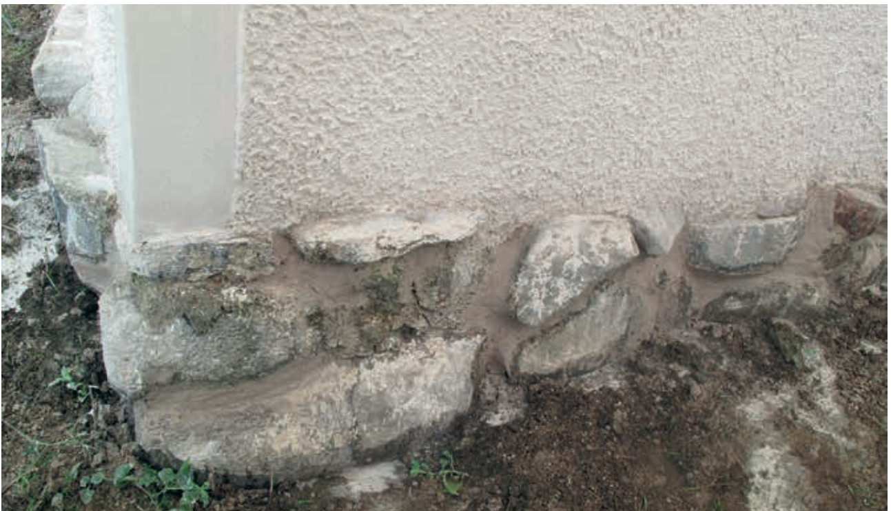
LP_2013_00566 Grunden efter restaureringen, foto H. Bellberg 2013
