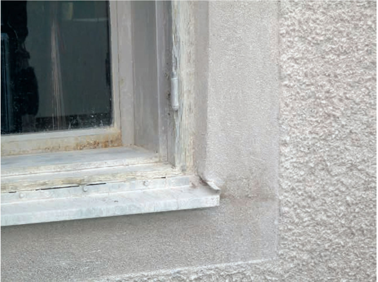
LP 201300564. Detalj av möte mellan fönsterbleckplåt och slätputs, foto H. Bellberg 2013
