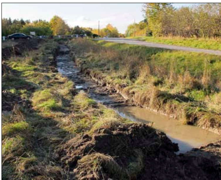
Fig 4. Schakt vid det fyndförande området vid p-platsen vid korset Kaggeholmsvägen-Helgövägen. Schakten vattenfylldes snabbt efter schaktningen, vilket försvårade undersökningen.
