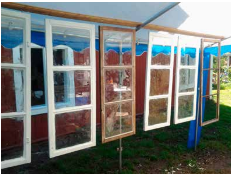
Fig.7. Fönster under renovering. Bild från entreprenör. Bild 3.
