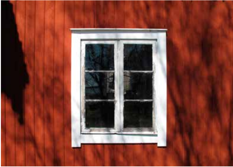
Fig.5. Fönster till salen innan renovering. Foto Albin Uller 2012. Lp201300498.
