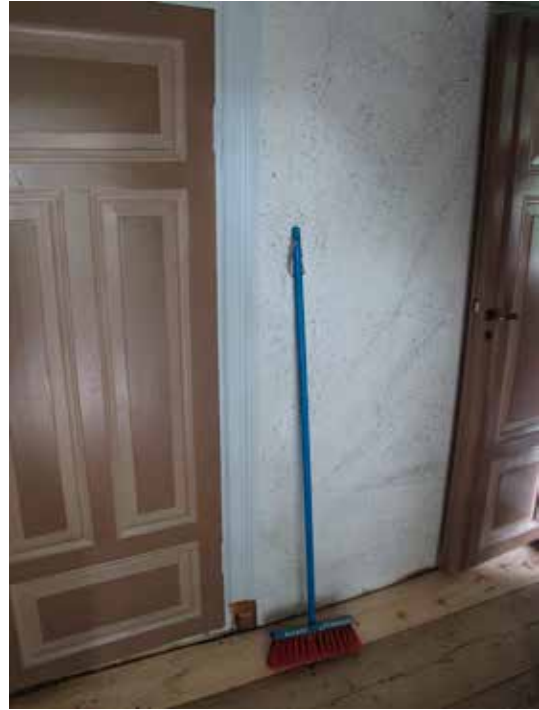
Fig.13. Hallen med stänkmålad lumpapp samt dörrarnas nya färgsättning. Foto Albin Uller 2013. Lp201300523.
