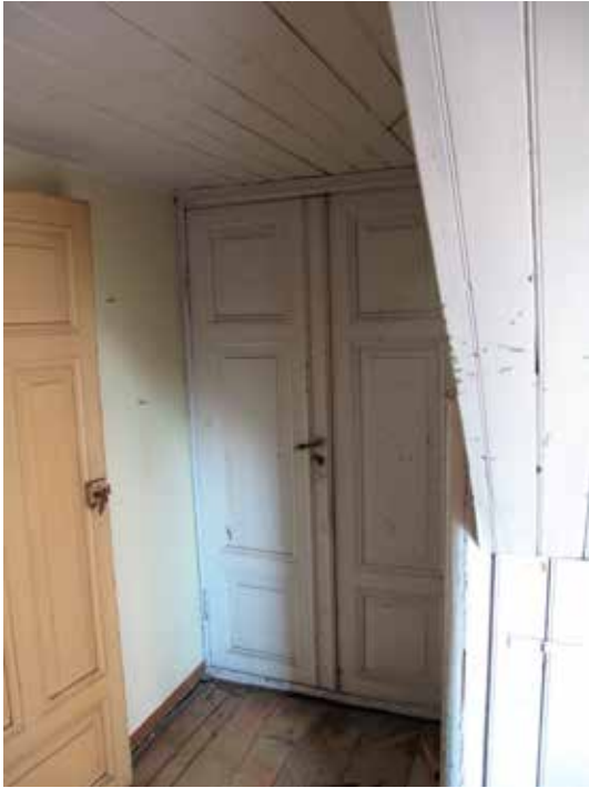
Fig.12. Hallen med masonitskivor och dörrar med befintlig färgsättning. Foto Albin Uller 2012. Lp201300492.
