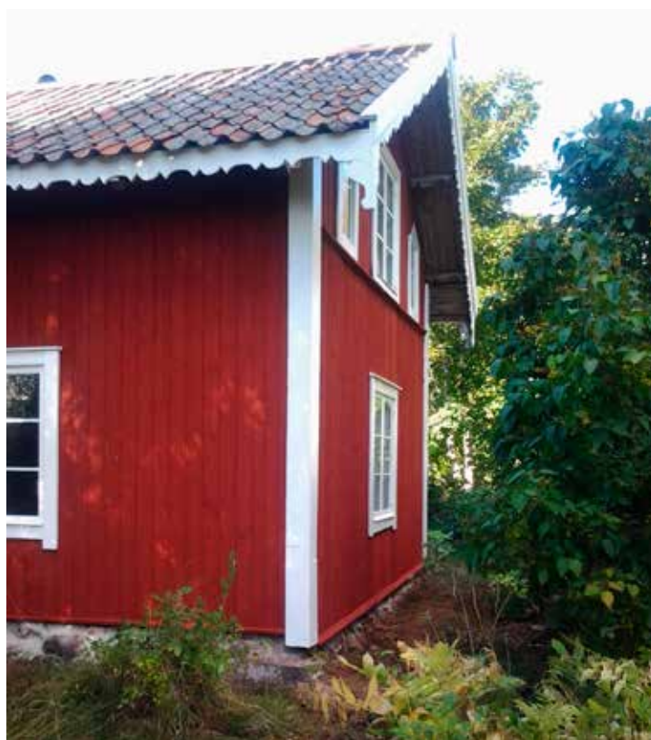
Fig 4. Östra gaveln efter avslutad renovering. Bild från entreprenör. Bild 1.
