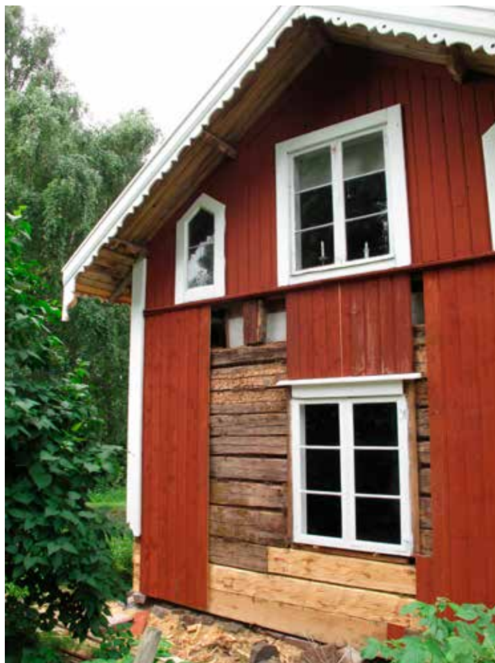
Fig 3. Östra gaveln under renoveringen. Foto Albin Uller 2013. Lp201300535.
