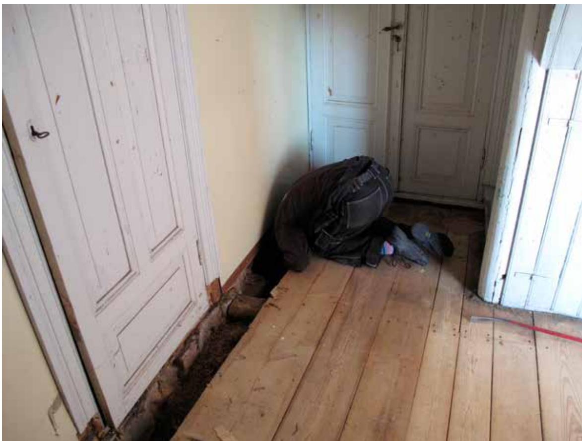
Fig.11. Golvet och bjälklaget inspekteras. Foto Albin Uller 2013. Lp201300508.
