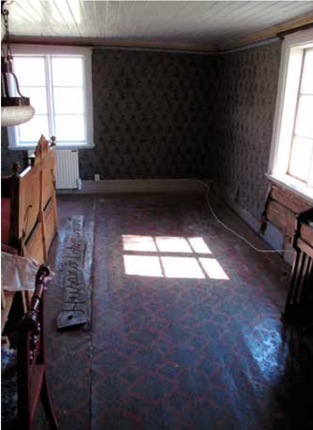
Fig.8. Salen med tapet och linoleummattan innan renoveringen. Foto Albin Uller 2012. Lp201300481.
