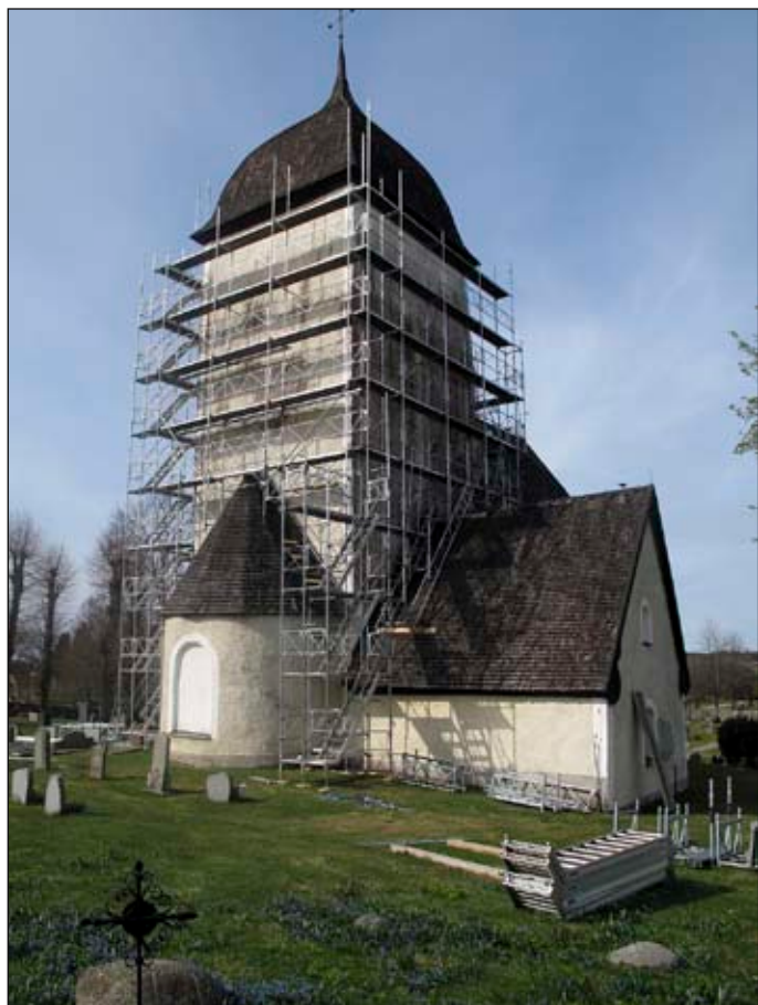
Fig 1. Husby-Ärlinghundra kyrka under renovering. Tornets fasader var kraftigt missfärgade av rödalger.
