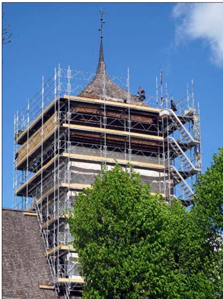
Fig 6. Torntaket på Husby-Ärlinghundra kyrka under omläggning.
