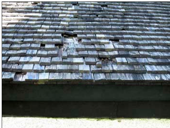
Fig 2. Spånen var i dåligt skick och taket var i behov av omläggning.
