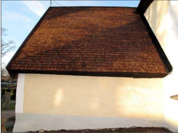
Fig 4. Samtliga spån på vapenhusets takfall åt öster ersattes med nya och rännalsplåten ersattes av en ny mindre plåt.
