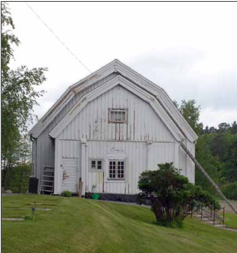
Långhusets och sakristians östgavlar under renovering. Sakristian är tillbyggd i norr och söder utanför knutlådorna och påbyggd en våning under 1930-talet. Marken sluttar mot norr och Kolström. Bildnr: lp20100176, 2009
