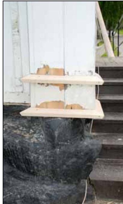
Nya trälister utförda efter de gamla. Bildnr: lp20100183
