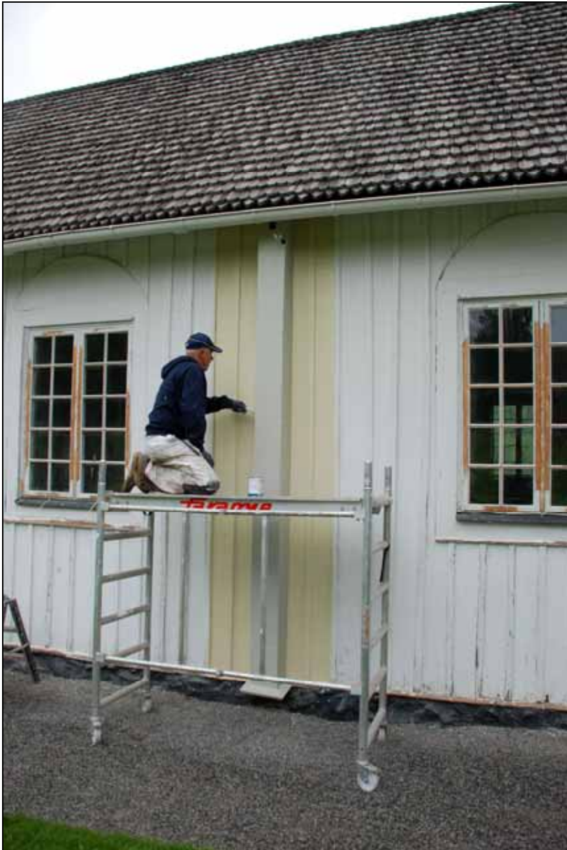
Uppstrykning av provyta för färgsättning av fasaden. Bildnr: lp20100181
