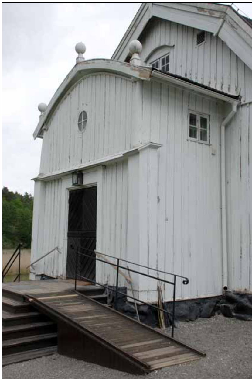
Vapenhuset och långhusets västgavel före renovering. Allt är målat i samma vita nyans. Endast kyrkporten avviker med tjärad panel. Den tresidiga trappan med ramp mot söder. Handledare i trä av äldre modell fäst i fasaden samt räcke av svartmålat smide. Hängrännor och stuprör av galvplåt målade i samma kulör som fasaden. Stuprör med knäckta hörn. Klot av plåt kröner halvkolonner av trä på vapenhusets gavel. Bildnr: lp20100177, 2009
