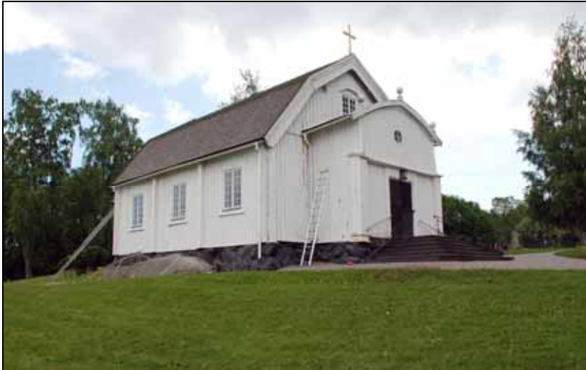
Kyrkan mot norr och väster före renovering. Bildnr: lp20100175, 2009
