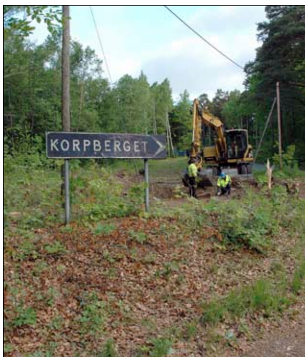
Fig 3. Påbörjad schaktning vid Korpberget. Foto G Werthwein, SSM bildnr lp20100168.
