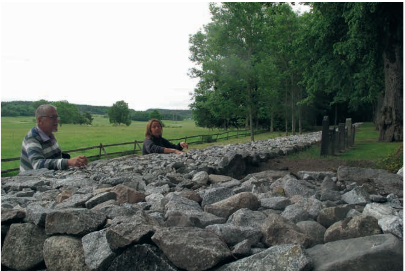
LP 201300598. Staket måste sättas upp utefter den östra mursträckningen, där marken terrasserar i Västra Ryd
