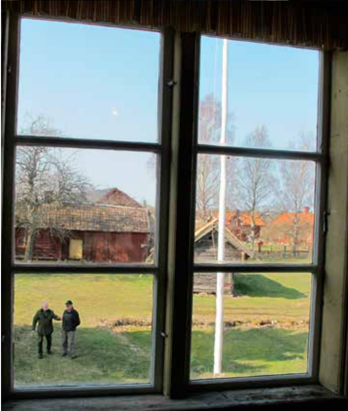
Fig. 12. Ute på gården i väster går P.O. och Bertil och samtalar. Fönstret är husets äldsta, placerat ovanför verandan. Karmen, mittposten, smygen och fönsterbrädan är lämnade omålade. Fönsterhaspen är av 1700-talstyp. Foto: H. Bellberg. LP_2014_00098.
