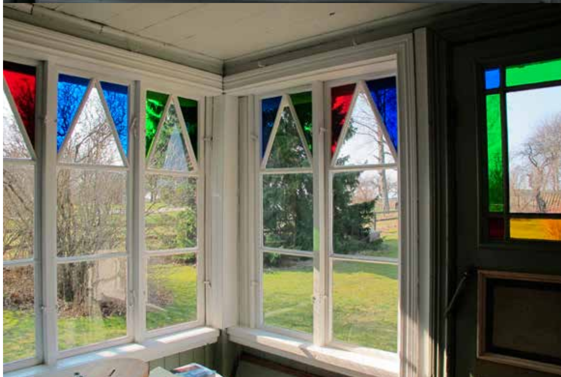
Fig. 14. Övre bild. LP_2014_00100. Fönstren mot norr i verandan, med nymålade kringliggande fönsterdelar. Foto: H. Bellberg
