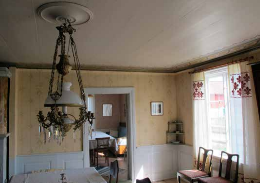
Fig. 7. Salstaket färdigt med den lagom matta glansen tydligt synlig ovan ljusinsläppet. En rosett sattes vid ljuskronan. Den målades lika taket, men skulle kunna bemålas med några enkla linjer i gulgrönt för att bättre ta upp bårdens färgskiftningar. Foto: H. Bellberg. LP_2014_00093.
