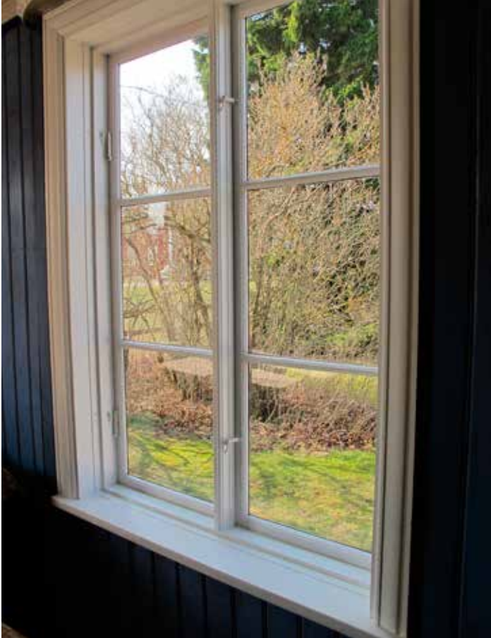
Fig. 11. Fönster i köket i söder med nymålade karmar, smygar och fönsterbräde. Foto: H. Bellberg. LP_2014_00097.
