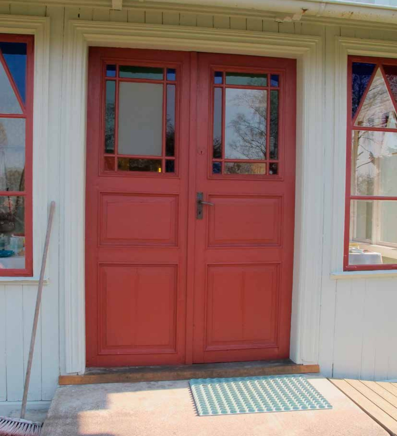
Fig. 19. Pardörrarna rödmålades lika befintlig färg och speglarna kompletterades med fyllningslister som rödmålades. Dörrspeglarna var tidigare täckta av masonitskivor, men visas efter restaureringen i sin helhet med de helfranska profilerna. Pardörrarna fick även en ny sparkbräda längs tröskelns framsida. Foto: H. Bellberg. LP_2014_00105.
