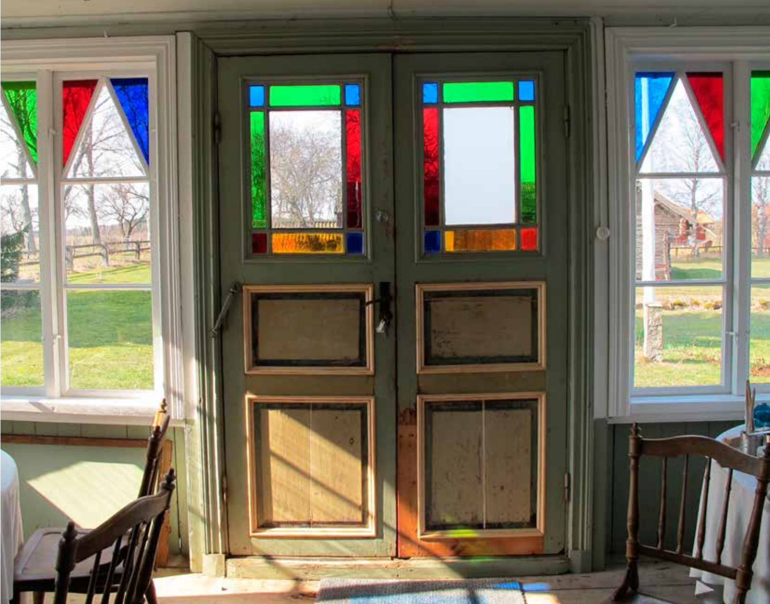
Fig. 16. Pardörrarna blev lagade med nya fyllningslister, vilka bemålades. Foto: H. Bellberg. LP_2014_00102.
