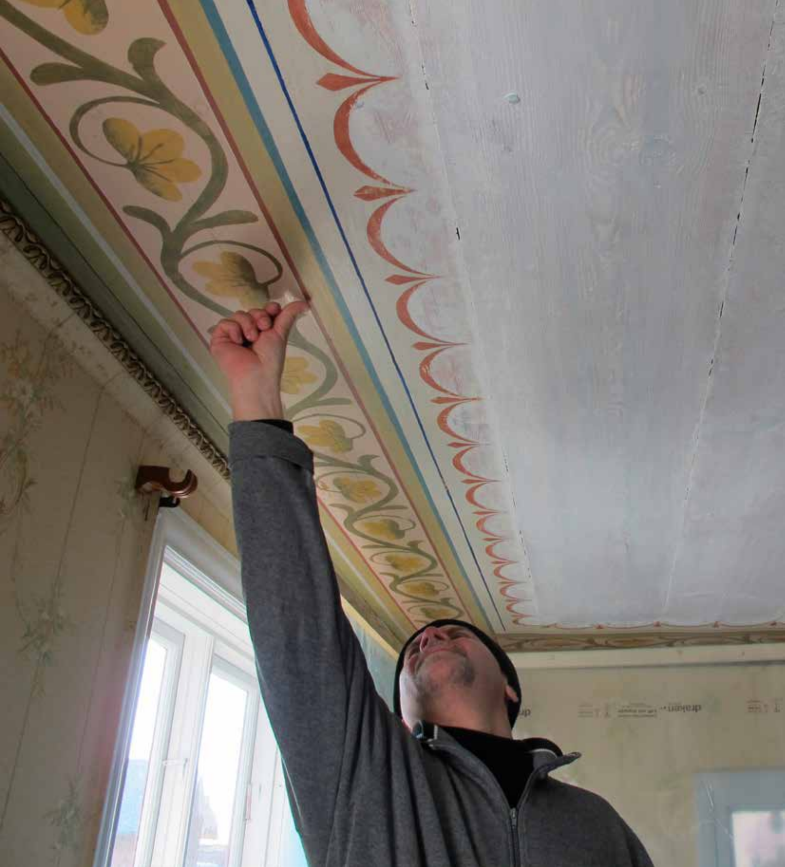
Fig. 5. Salstaket efter en strykning med vit linoljefärg samt linoljekitt som fog mellan brädorna. Målaren Kjell undersöker den befintliga glansgraden som syns där han gnuggar med fingret i bården. Foto: H. Bellberg. LP_2014_00106.
